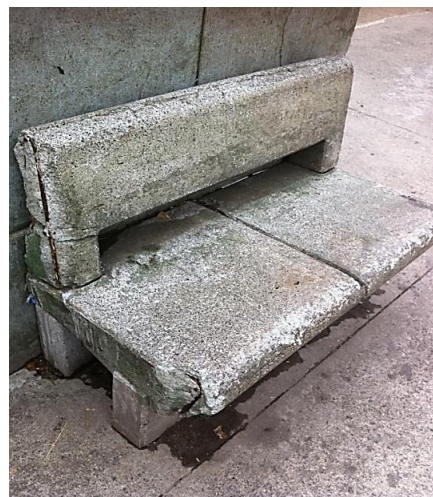
Imagen 9: (Bancas deterioradas zona de patinaje-terminal del sur de Medellín, 2014 foto tomada por equipo de investigación)
