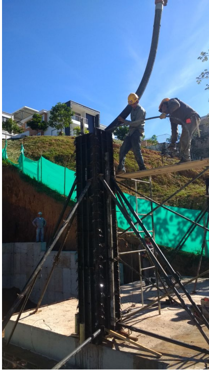
Vertido de concreto
