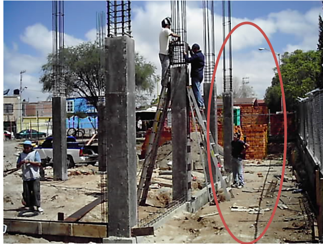
Figura 17. Ubicación de centro de acopio en la construcción
