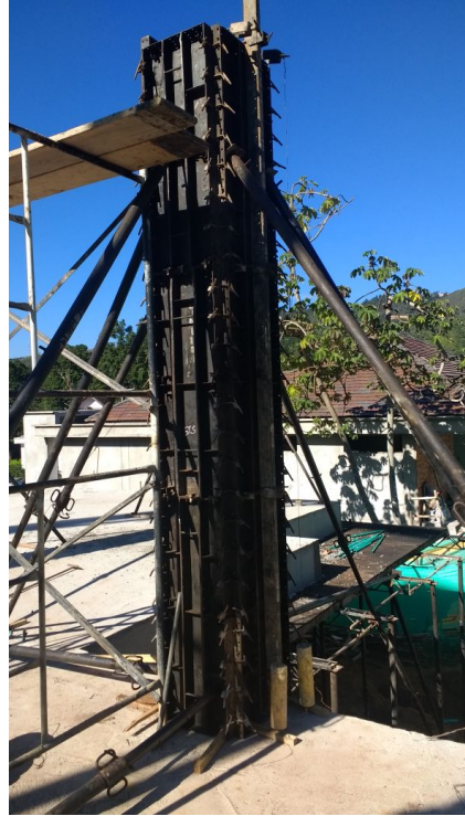
Fraguado y retirada formaleta
