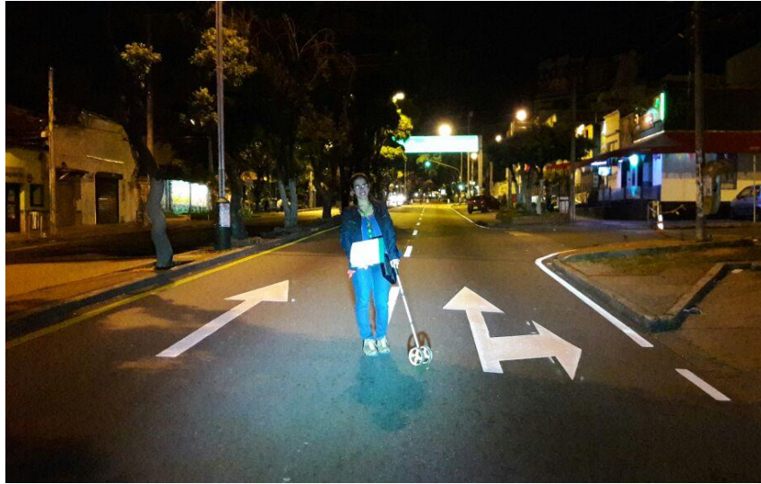
Figura 32. Acompañamiento nocturno para control de obra
