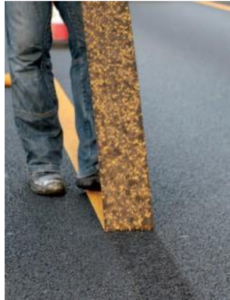
Figura 39. Retiro Cinta Preformada
