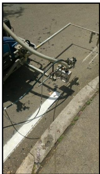
Figura 21. Demarcación ML máquina micropopulsada.
