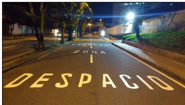
Figura 10. Fotografía tomada en la carrera 33 con Av. Quebrada Seca
