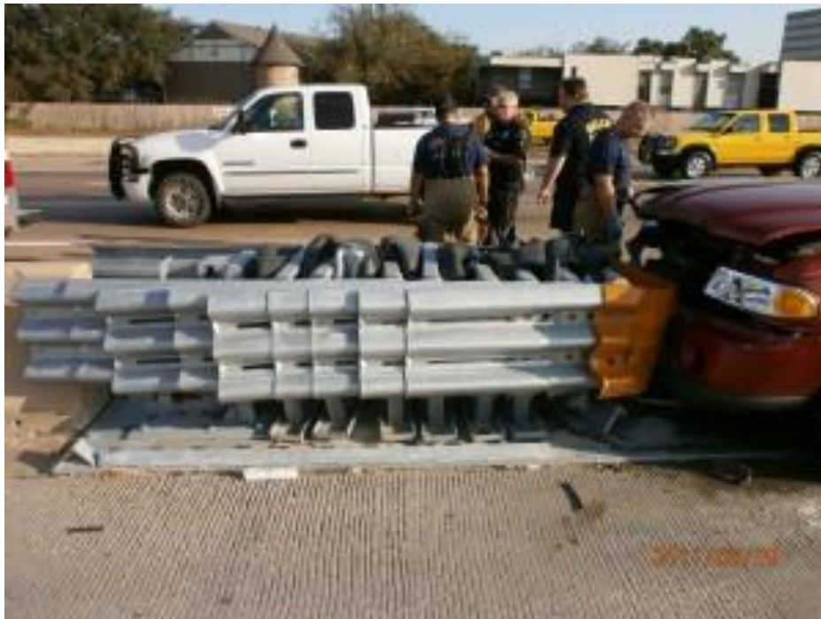
Figura 41. Funcionamiento Amortiguador de impacto
