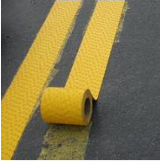
Figura 38. Instalación Cinta Preformada
