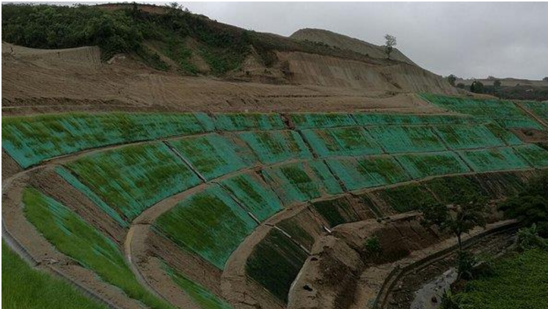
Imagen 12: Uso de Mantos de Revegetalización en un Talud.
