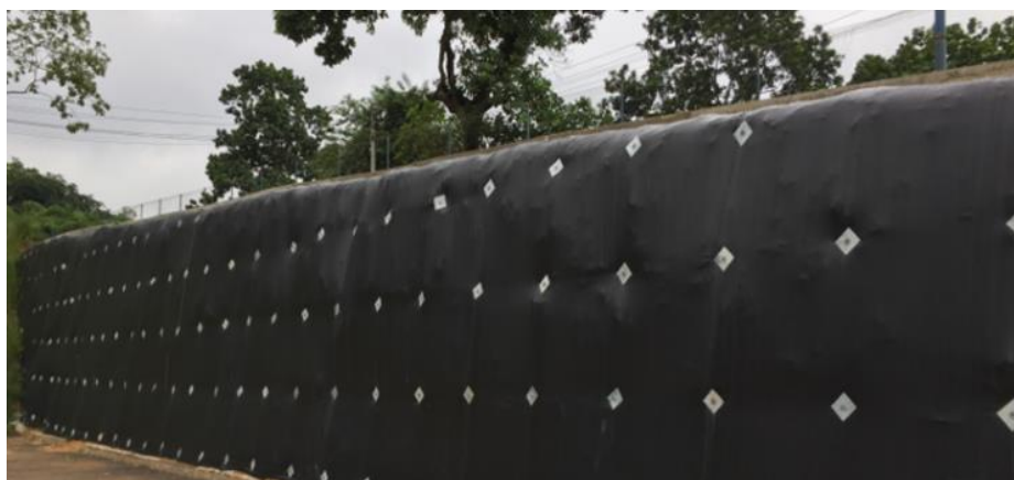
Imagen 29: Instalación del Geotextil en la UPB.
