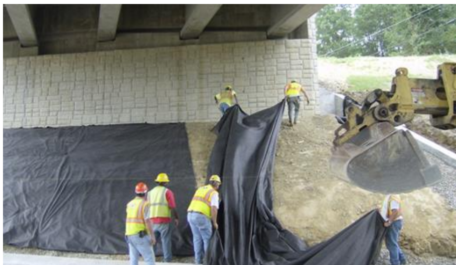
Imagen 28: Instalación del Geotextil en la UPB.
