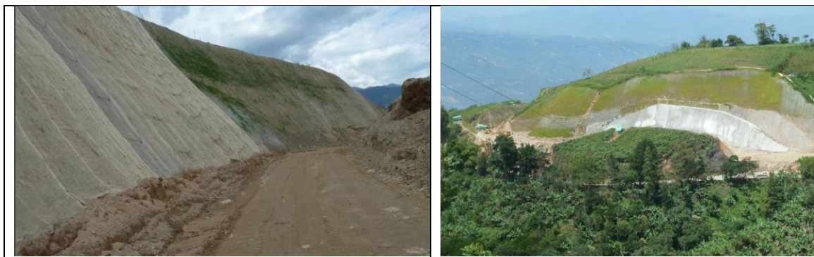
Imagen 24: Hidrosiembra en la via Bucaramanga- Cucuta
