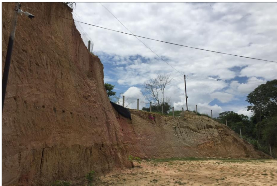
Fotografía 3: Talud de estudio.
