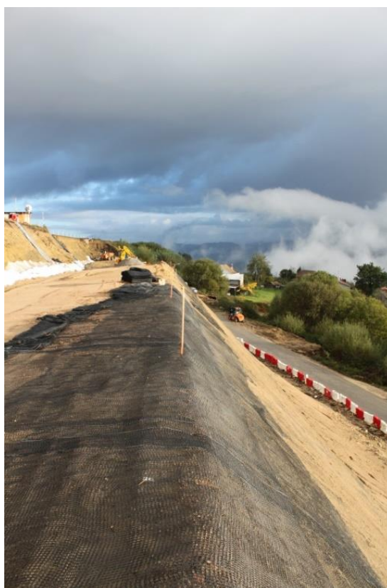
Imagen 30: Instalación de Geomallas.
