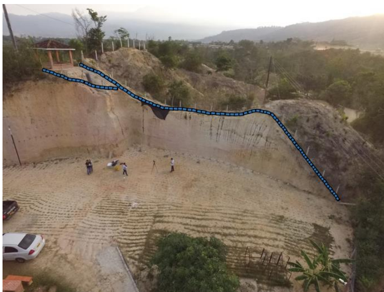
Imagen 31: Diseño Preliminar de las Zanjas de Coronacion.
