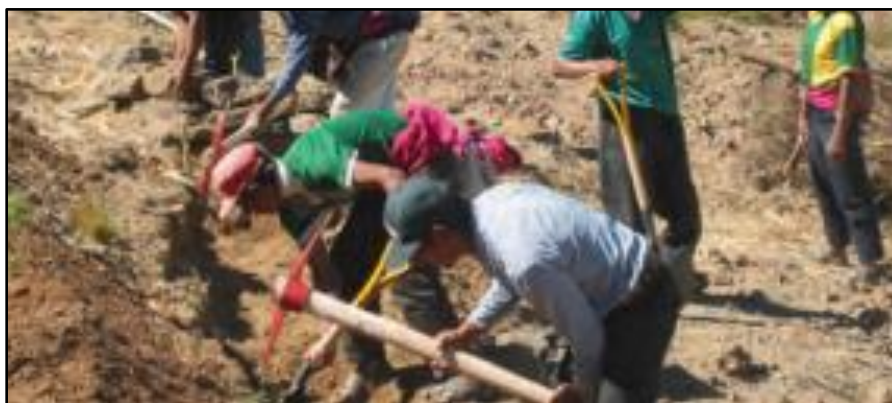
Imagen 9: Excavación Zanja de Coronación.
