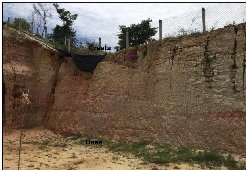
Fotografía 4: Partes Generales del talud en estudio.
