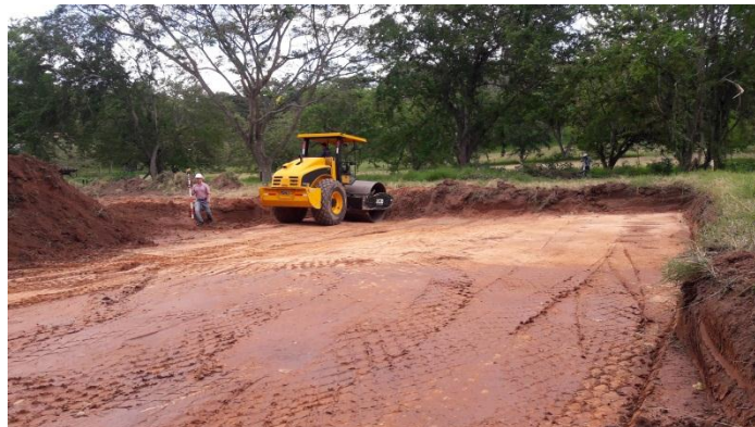
Ilustración 11: Sellamiento con el Vibro compactador de la caja MZ D
