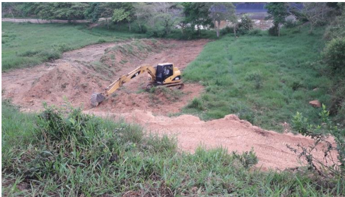
Ilustración 9: Excavadora y buldoser descapotando áreas marcadas por topografía.
