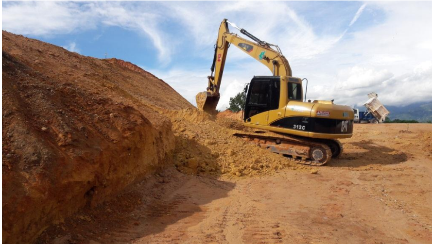
Ilustración 31: Corte chaflanes lote 46 Manzana A – Conjunto pradera
