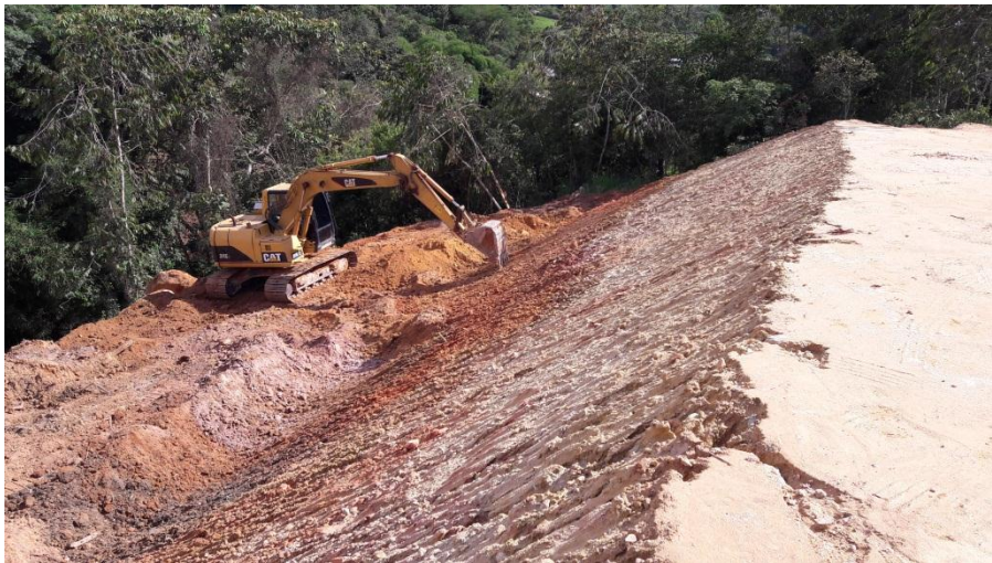
Ilustración 32: Corte chaflanes lote 40 Manzana A – Conjunto Pradera
