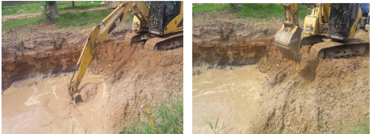
Ilustración 12: Excavación en colchones a 1.8 m respecto al terreno natural Manzana C y D – Conjunto Pradera
