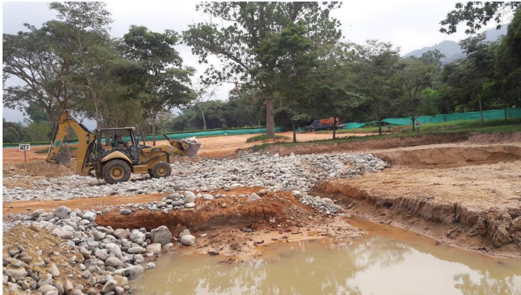
Ilustración 18: Retrocargado 430 E- Extendiendo bolo para zonas de mejoramiento
