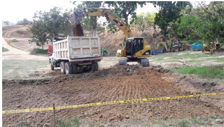
Ilustración 15: Caja de mejoramiento Manzana F y G – Conjunto Pradera
