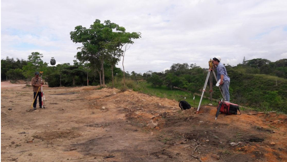
Ilustración 6: Topografía marcando chaflanes en Conjunto La Sierra.
