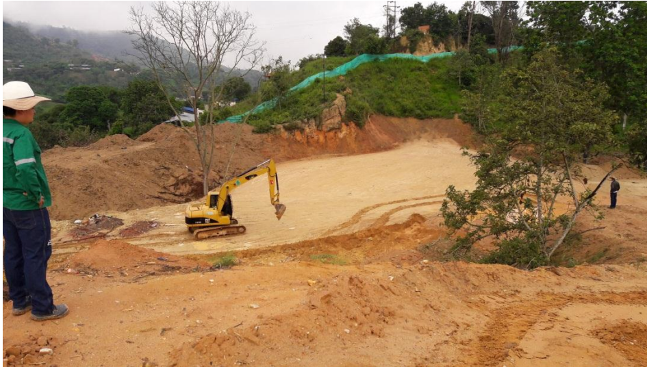
Ilustración 40: Rellenno Manzana D y E de la Sierra
