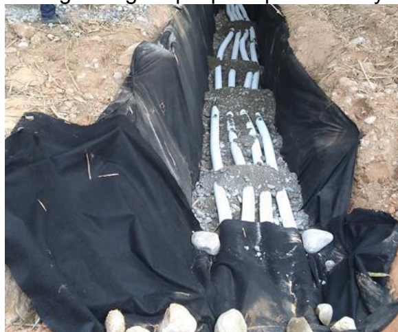
Ilustración 19: Filtro realizado en Manzana C – Conjunto Pradera
