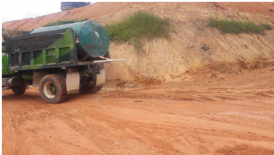
Ilustración 41: Riego de relleno en Manzana G – Conjunto La Loma
