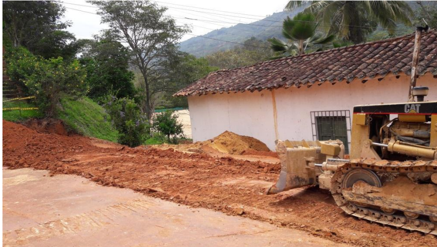
Ilustración 42: Relleno capa # 3 en Manzana G – Conjunto de La Loma
