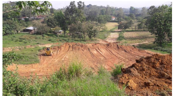
Ilustración 9: Excavadora y buldoser descapotando áreas marcadas por topografía.
