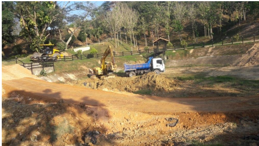
Ilustración 17: Cargue material sobrante en Manzana H – Conjunto La Loma
