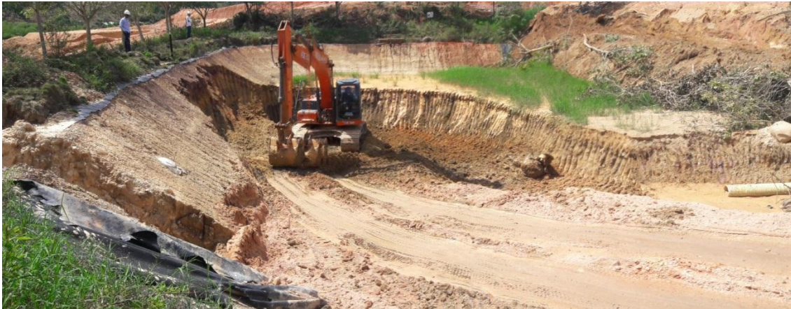
Ilustración 38: Excavación y relleno manzana C – Conjunto La Loma (Segundo lago)
