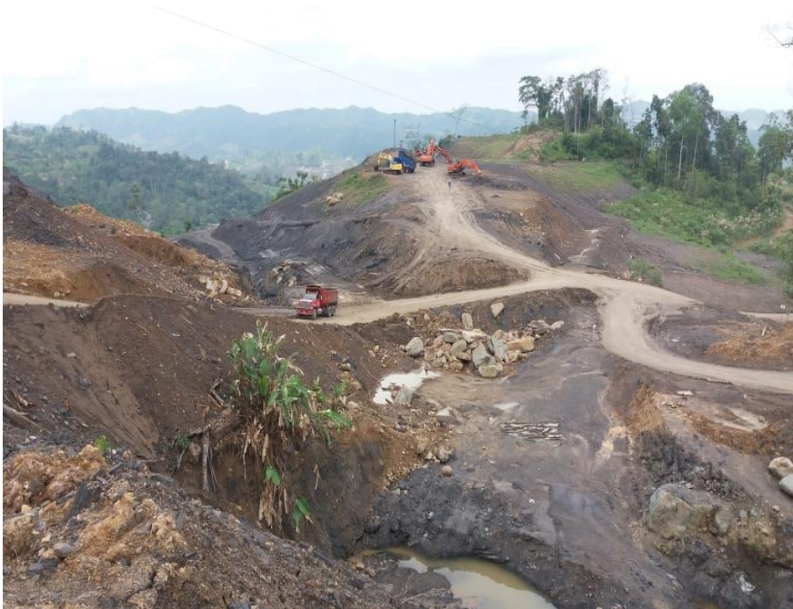
Ilustración 33: Vías realizadas en Frente 3
