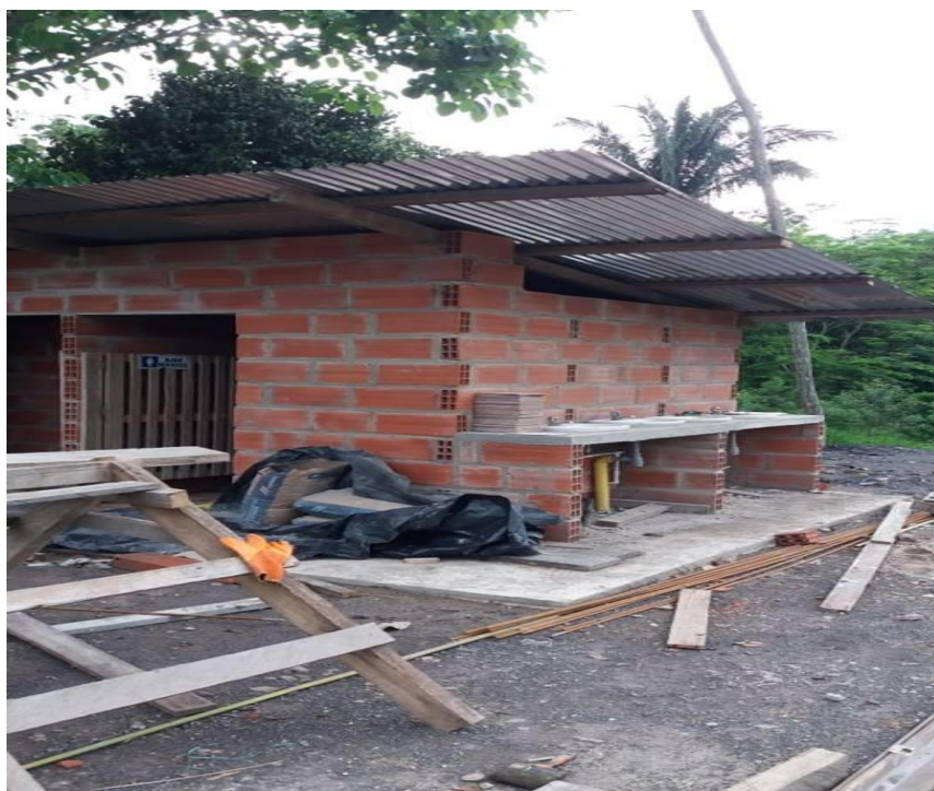
Ilustración 22: resultado final de la construcción de la unidad sanitaria.
