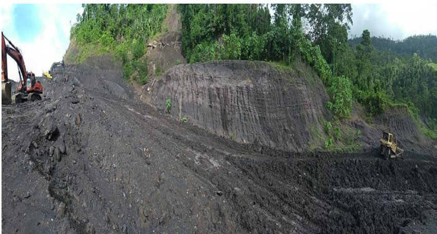
Ilustración 29: Construcción de la nueva vía
