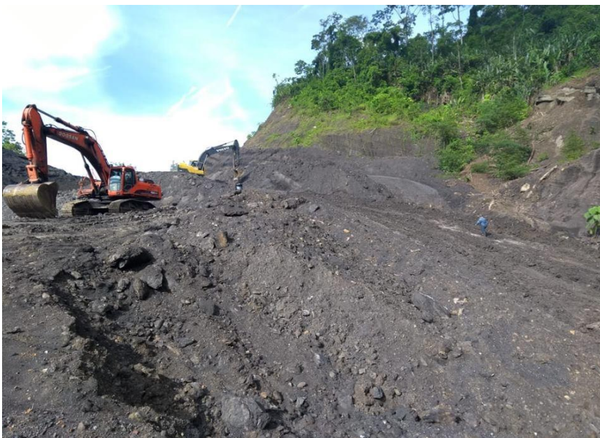
Ilustración 28: Construcción de la nueva vía
