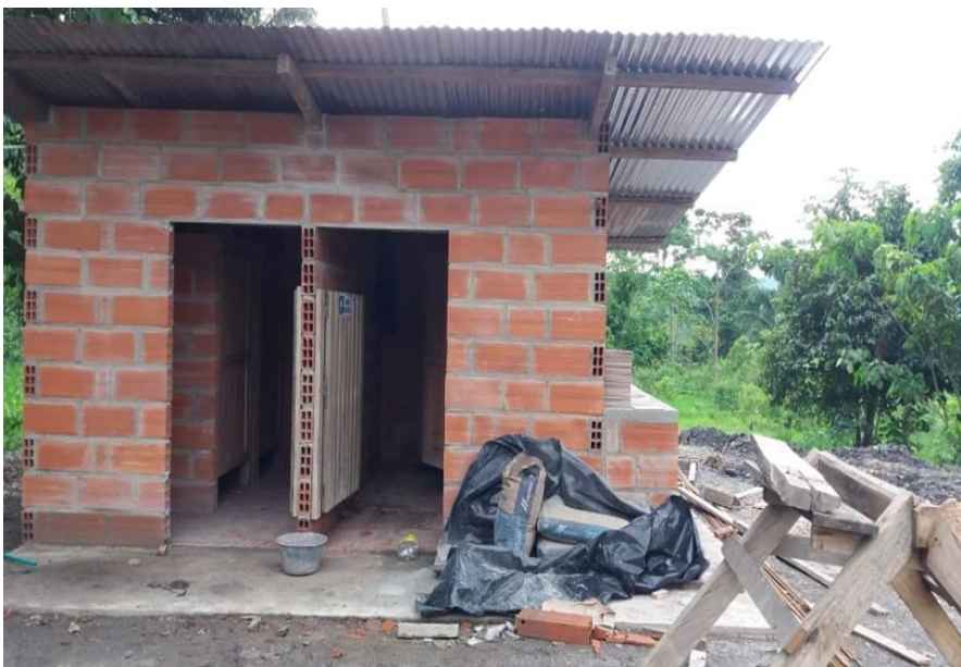
Ilustración 21: resultado final de la construcción de la unidad sanitaria.
