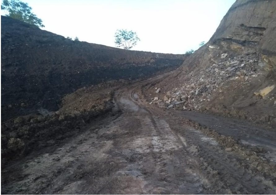
Ilustración 32: Construcción de la nueva vía, resultado final
