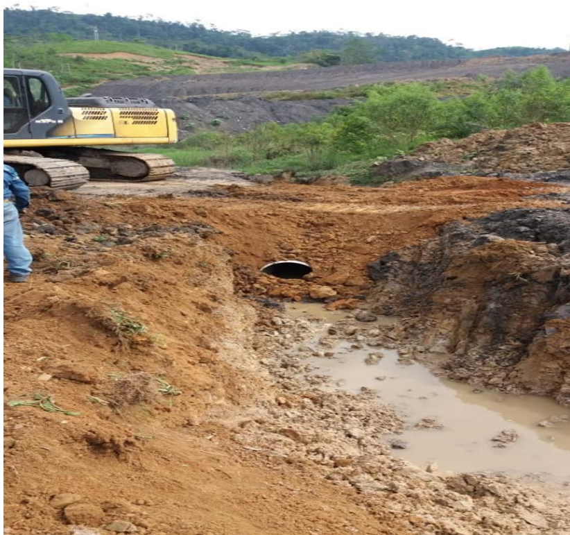
Ilustración 19: instalación de tubería
