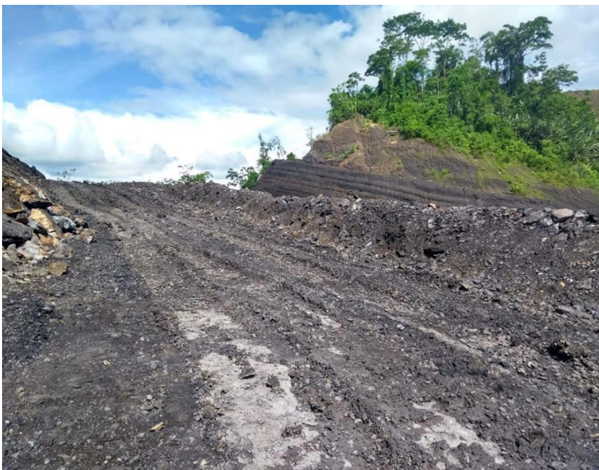
Ilustración 30: Construcción de la nueva vía
