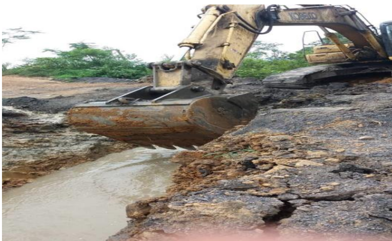
Ilustración 15: Zanja para la colocación de tubería
