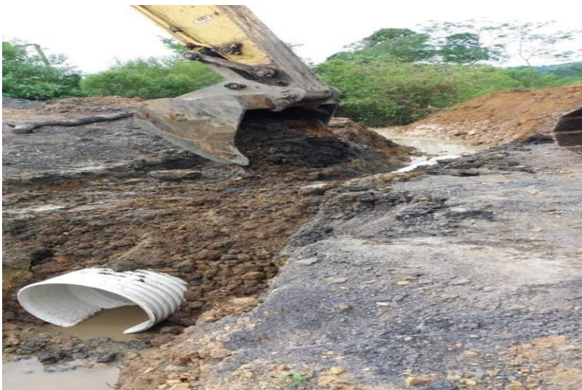
Ilustración 17: instalación de tubería
