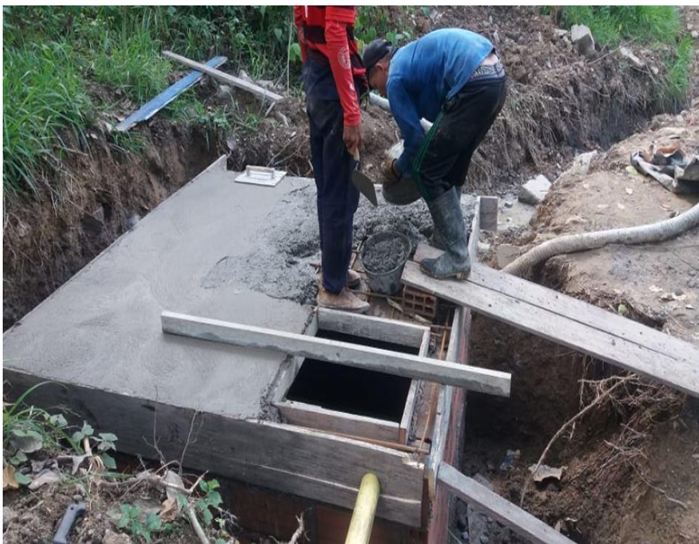
Ilustración 26: construcción de tanque almacenamiento de la unidad sanitaria
