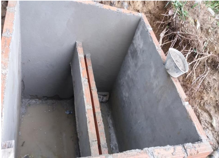
Ilustración 25: construcción de tanque almacenamiento de la unidad sanitaria
