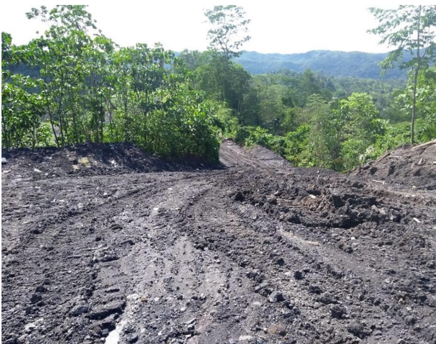
Ilustración 31: Construcción de la nueva vía
