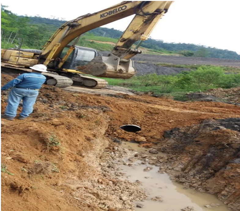
Ilustración 20: instalación de tubería resultado final
