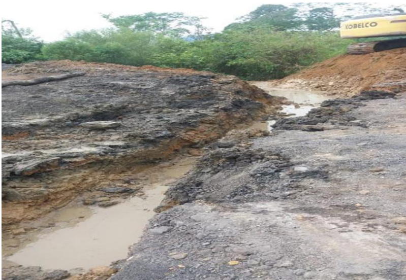
Ilustración 16: Realización de zanja para la colocación de tubo y desagüe del agua depositada
