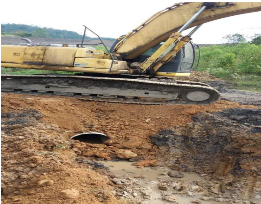
Ilustración 18: Instalación de tubería
