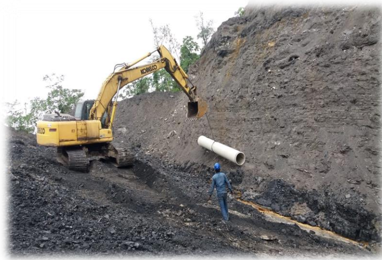
Ilustración 14 : Transporte de tubería
