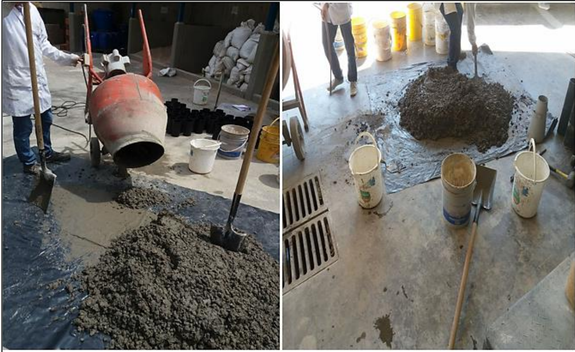
Ilustración 16. Elaboración del concreto utilizando un trompo y mezclando manualmente.
