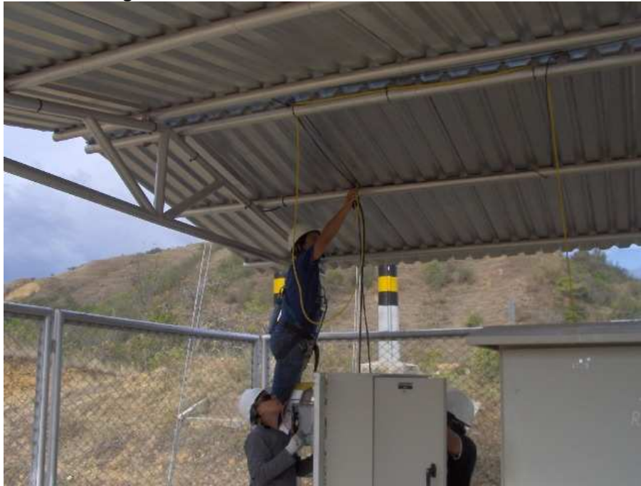
Figura 99. Instalación de la línea de transmisión.
