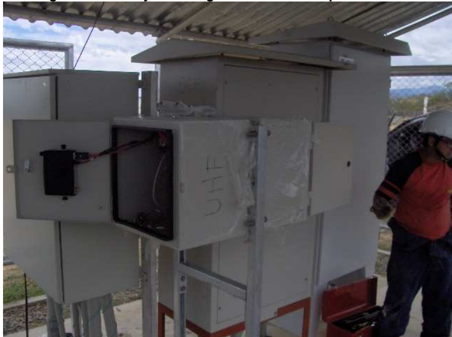
Figura 98. Montaje de dos gabinetes sobre soporte metálico
