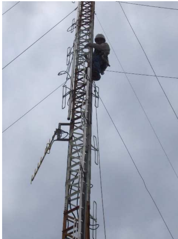
Figura 101. Instalación de antenas en centro de control.
