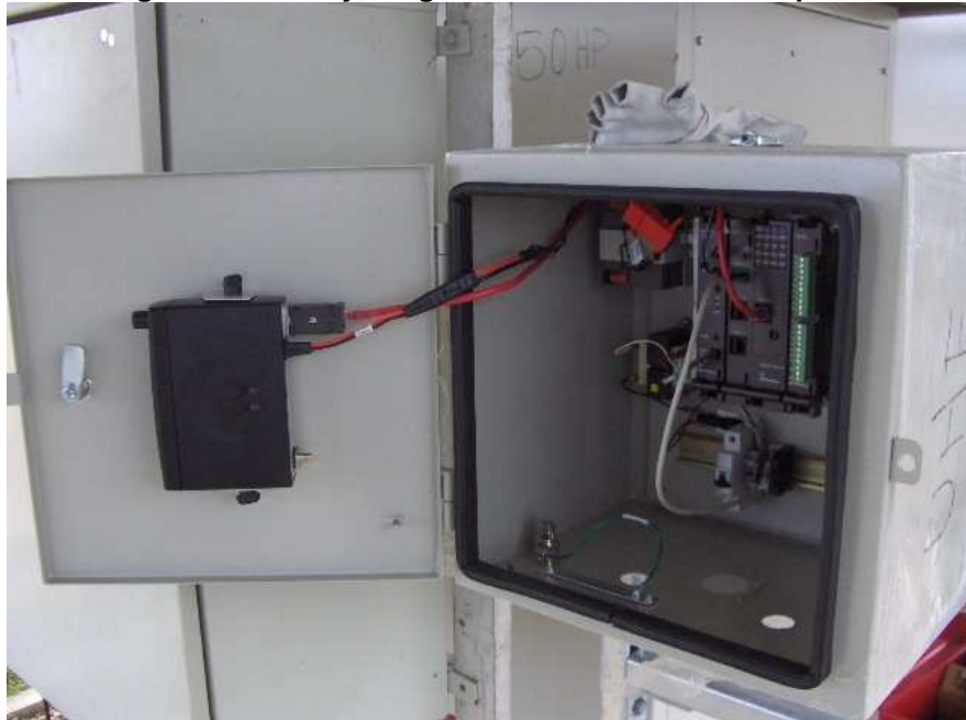
Figura 97. Montaje de gabinete metálico sobre soporte
