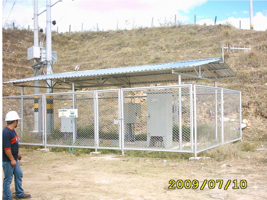
Figura 81. Vista lateral de la caseta
