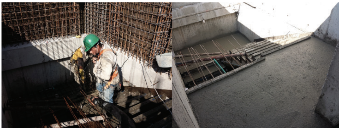
Figura 15. Supervisión fundida escaleras
