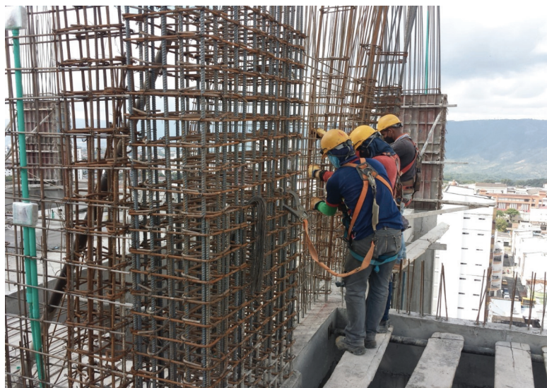
Figura 9. Supervisión de armado y amarre del acero foso ascensor 1 piso 16
