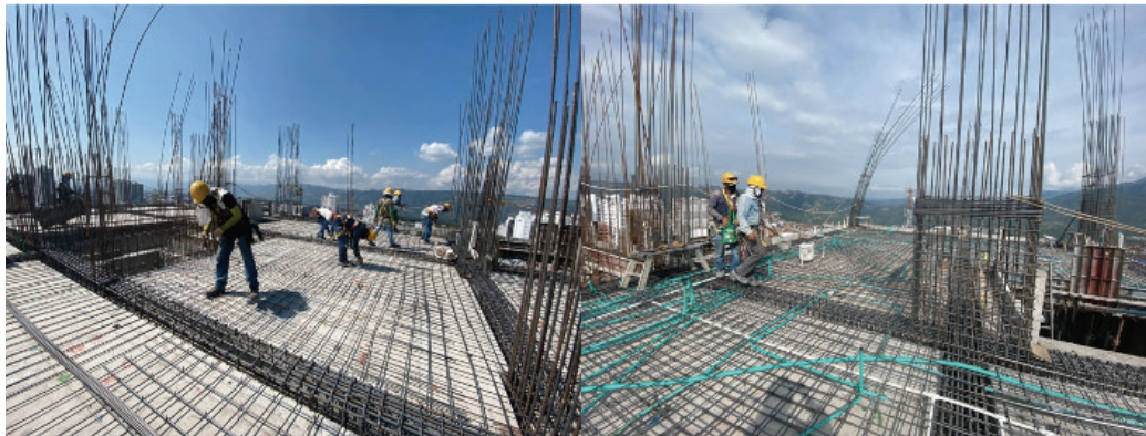
Figura 12. Armado "in situ" de malla electrosoldada e instalación de tubería
