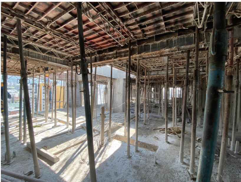
Figura 6. Revisión de parales
