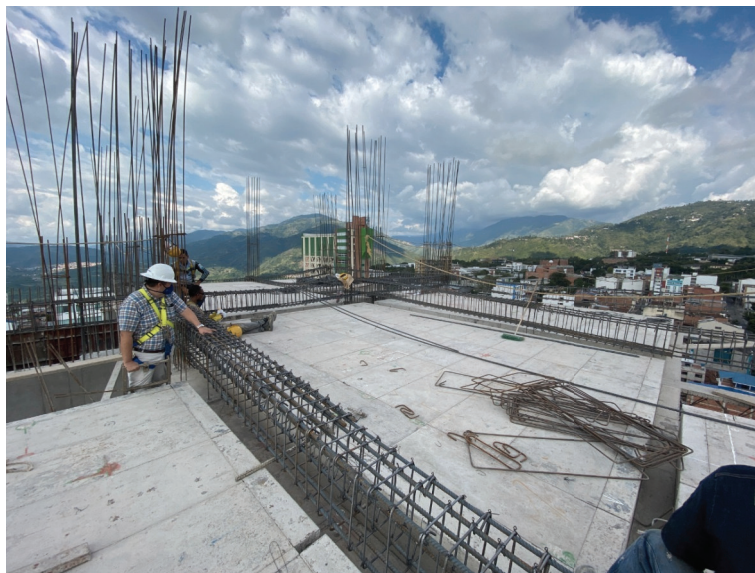
Figura 11. Armado y amarre de vigas principales placa piso 18
