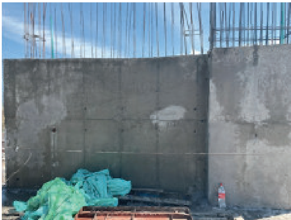
Figura 5. Reparación del muro con SIKA TOP 122
