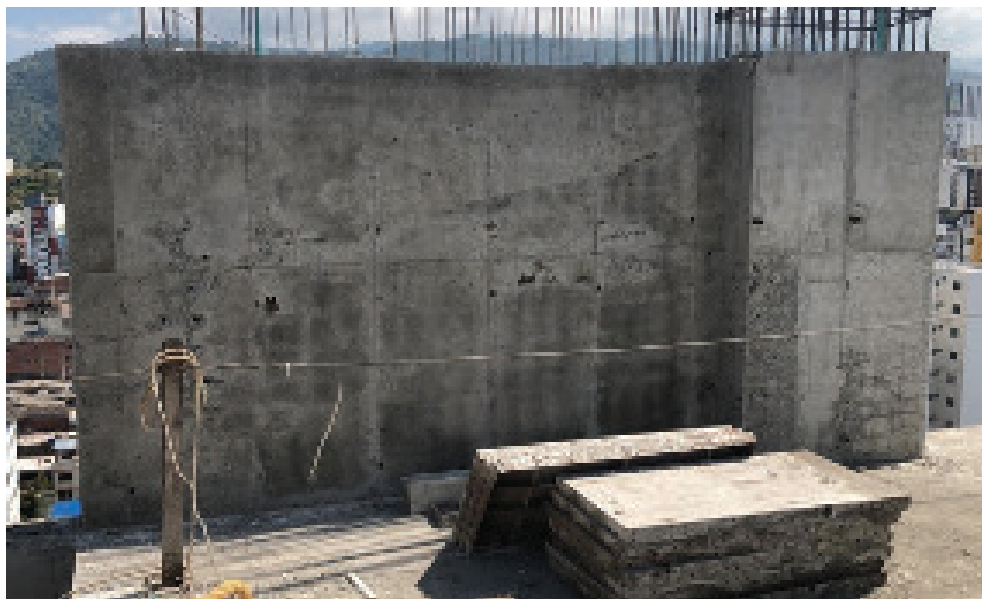
Figura 4.1. Muro sobre vibrocompactado
