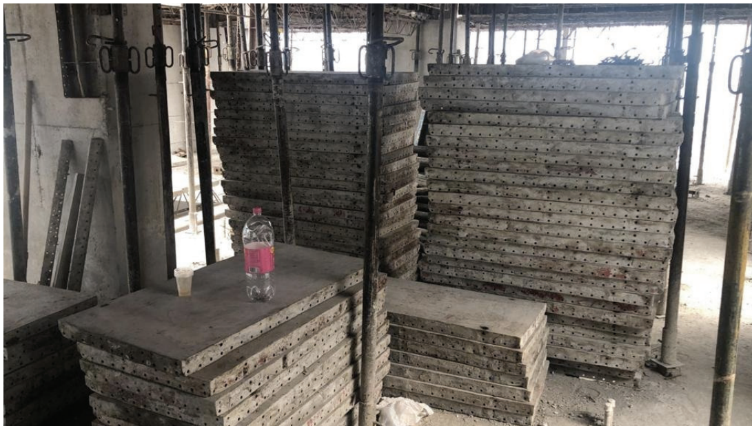
Figura 8. Formaletas después del mantenimiento
