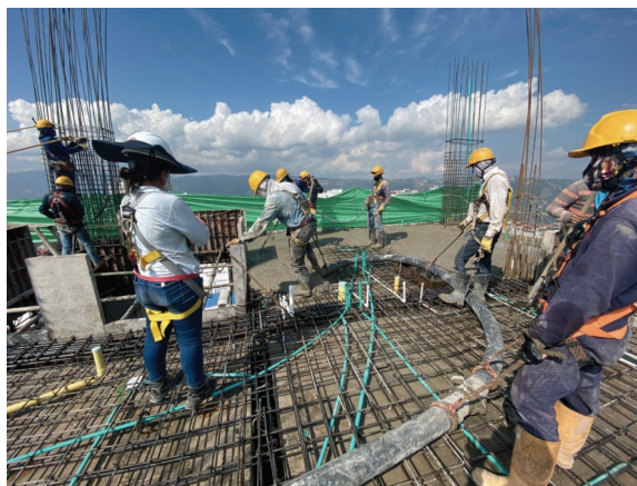
Figura 13. Fundida placa piso 18
