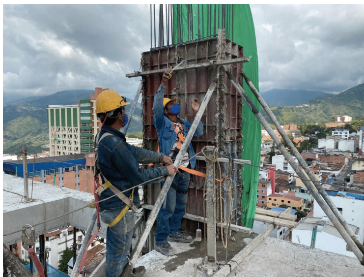
Figura 14. Replomada de las columnas ya fundidas
