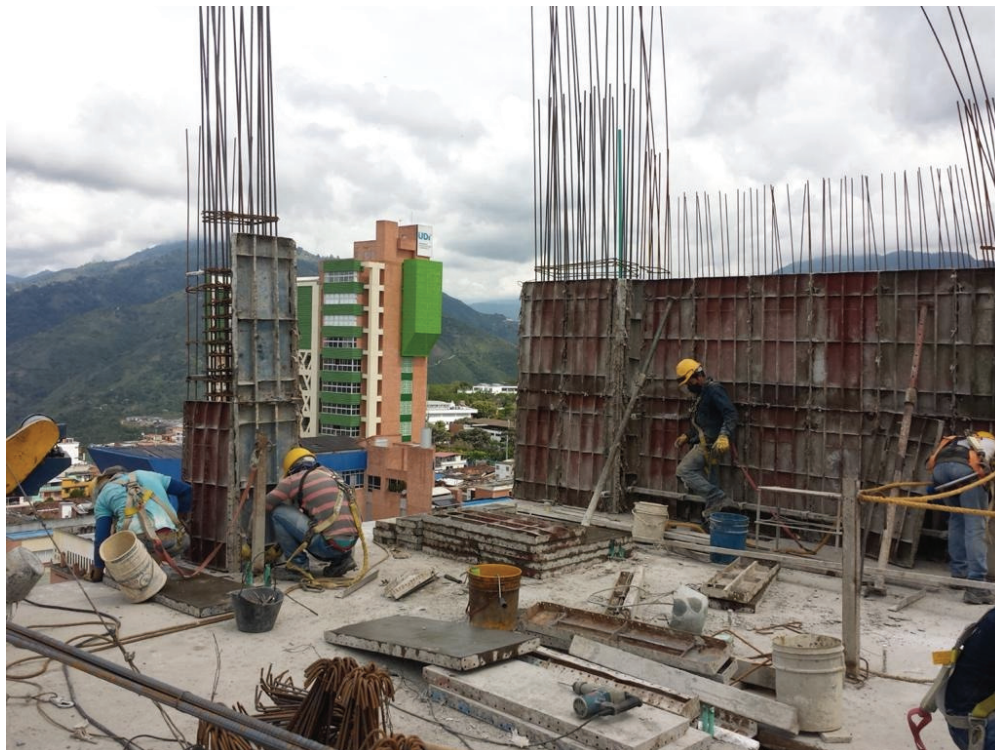
Figura 7. Proceso de montaje de las formaletas.
