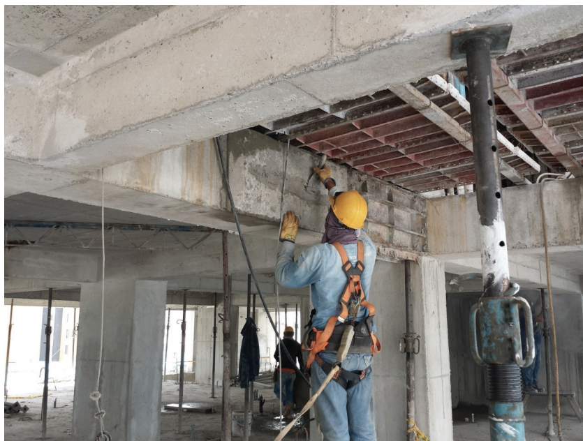
Figura 3. Resane estructura piso 15
