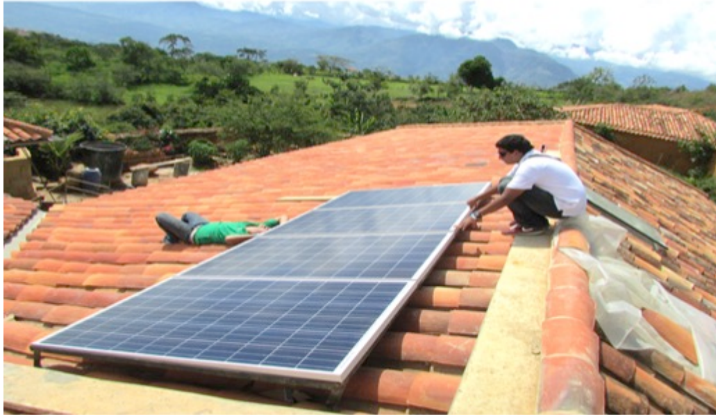
Figura 44. Instalación del banco de paneles
