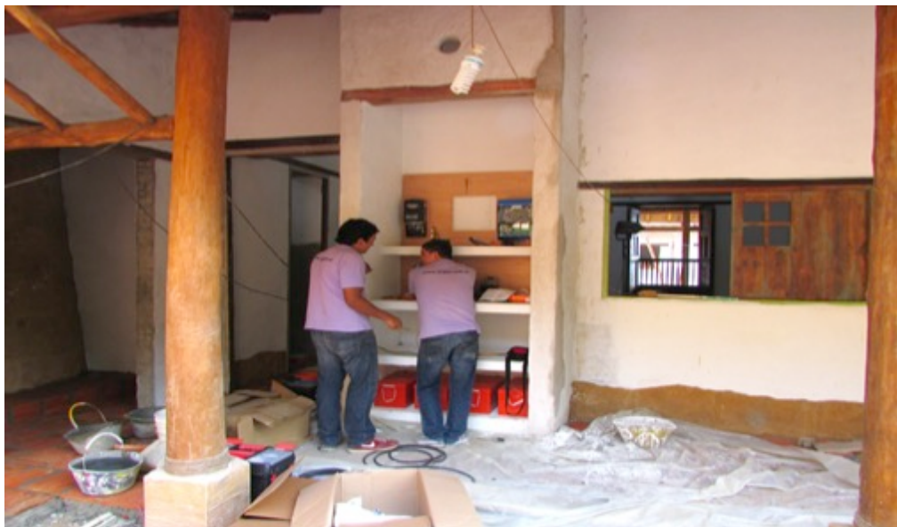
Figura 45. Instalación de los equipos en el cuarto de maquinas
