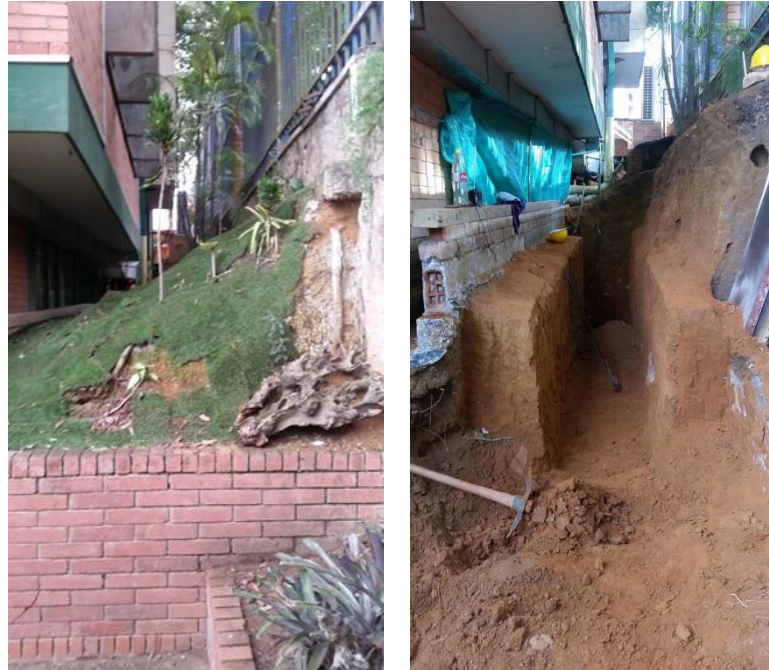
Figura 18. Talud existente y excavación Eje 0
