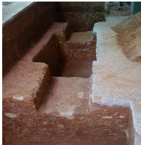
Figura 15. Excavación zapatas y vigas de amarre Eje Z
