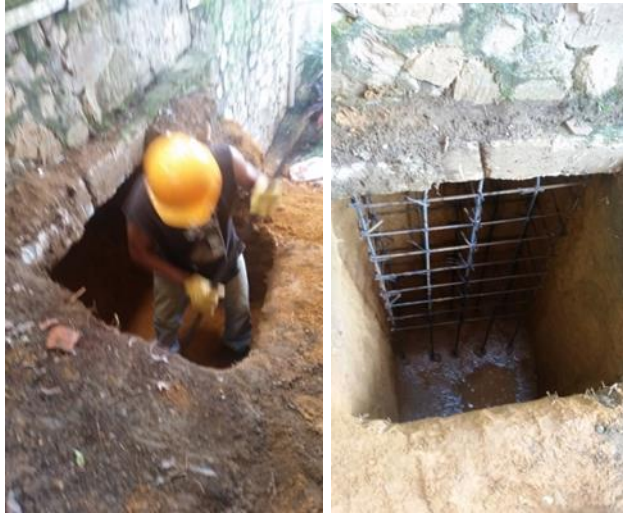
Figura 26. Concreto ciclópeo y concreto de 3000 psi columnas submuración
