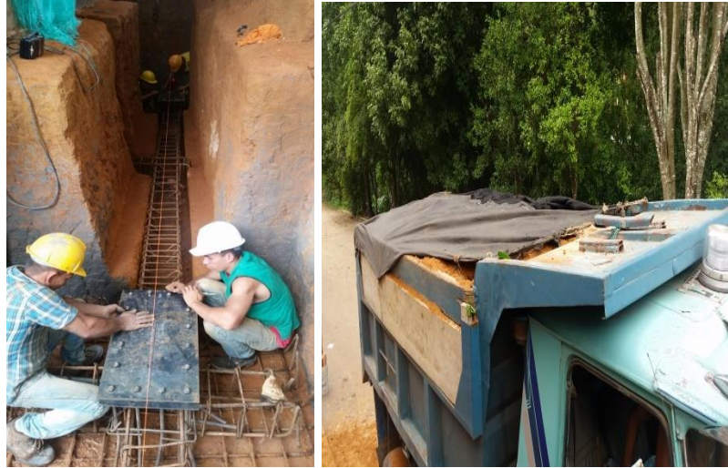
Figura 30. Cimentación Eje 0 y retiro de escombros
