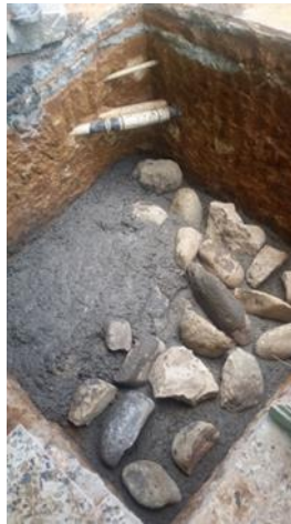
Figura 19. Fundida concreto ciclópeo en zapatas
