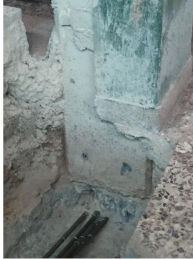
Figura 21. Perforación para anclajes
