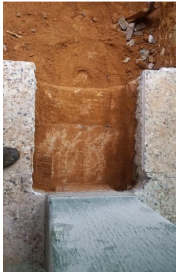
Figura 16. Excavación viga de amarre a zapata existente
