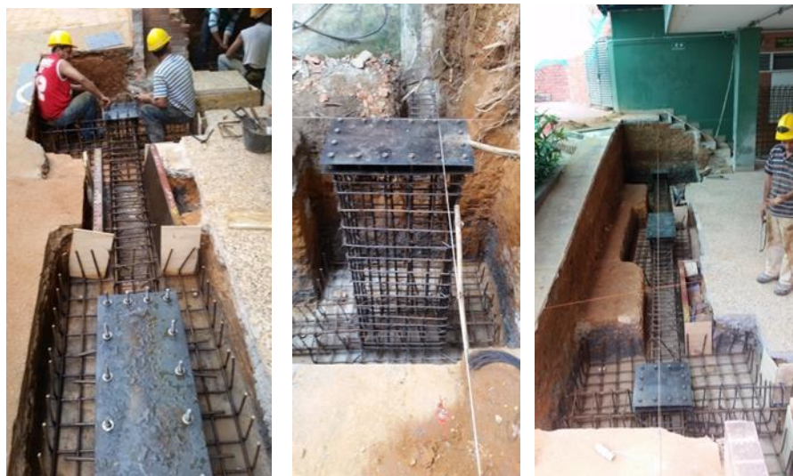
Figura 20. Armado de acero
