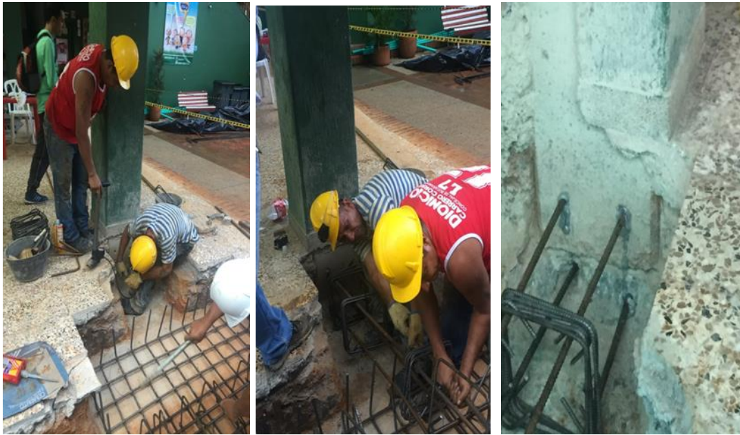
Figura 22. Proceso de anclaje a la estructura
