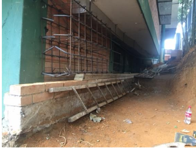
Figura 14. Demolición canal aguas lluvias Eje 0
