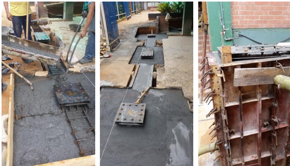
Figura 24. Concreto de 4000 psi para zapatas, vigas y pedestales
