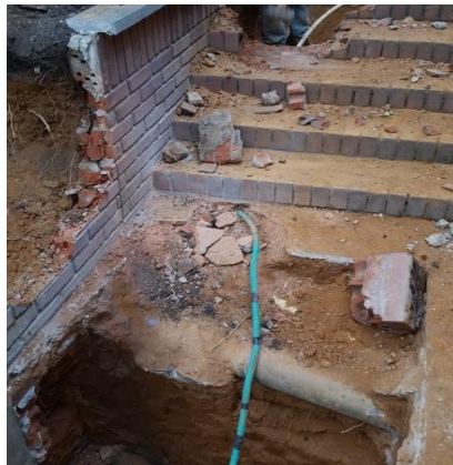
Figura 13. Demolición mampostería y escaleras Eje F
