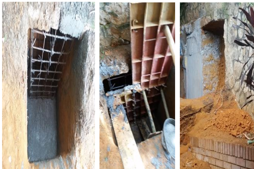
Figura 26. Concreto ciclópeo y concreto de 3000 psi columnas submuración
