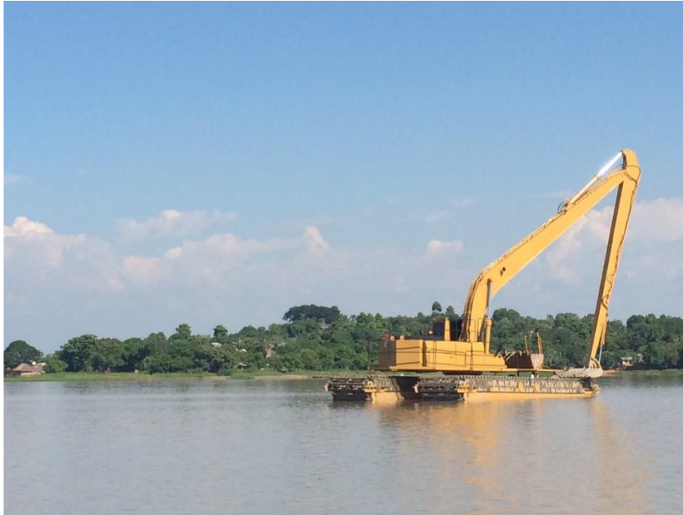
Ilustración 15: Equipos especializados (Retroexcavadoras Anfíbias)
