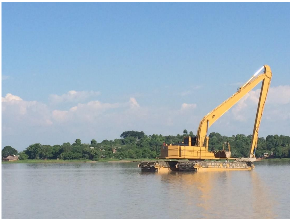
Ilustración 34: Retroexcavadora Anfibia - Conexión río Sogamoso-Ciénaga el Llanito
