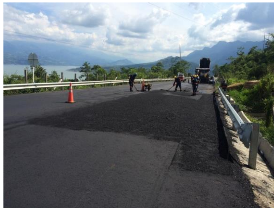
Imagen 2: Renivelación de Carpeta Asfáltica
