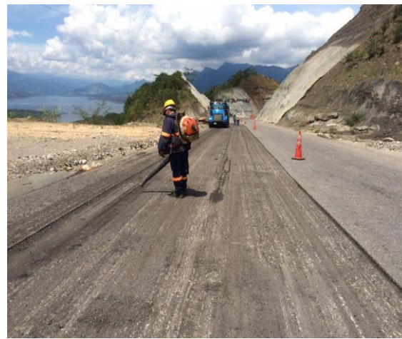
Ilustración 18: Fresado de la Carpeta Asfáltica
