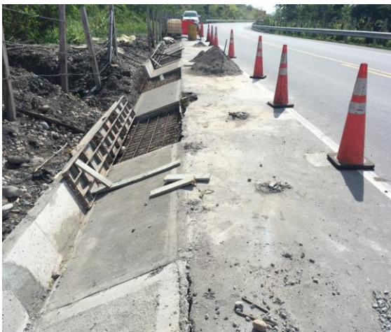
Ilustración 17: Construcción de cunetas
