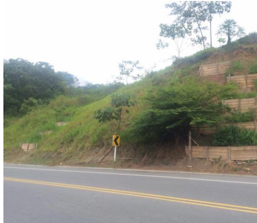
Ilustración 4: Empradización talud vía sustitutiva
