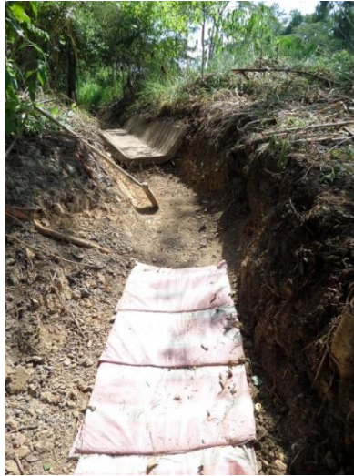
Ilustración 3: Prolongación de zanja en sacos de suelo cemento
