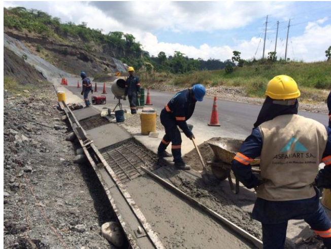
Ilustración 6: Construcción de cunetas K8+900 vía sustitutiva
