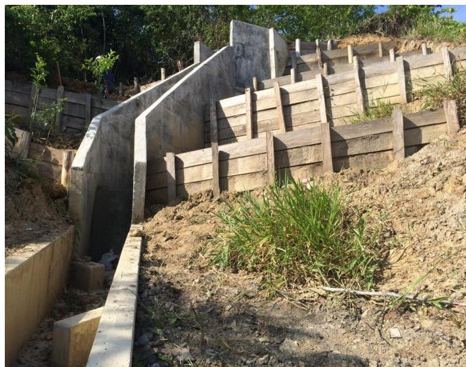
Ilustración 5: Construcción de trinchos K5+580 vía sustitutiva
