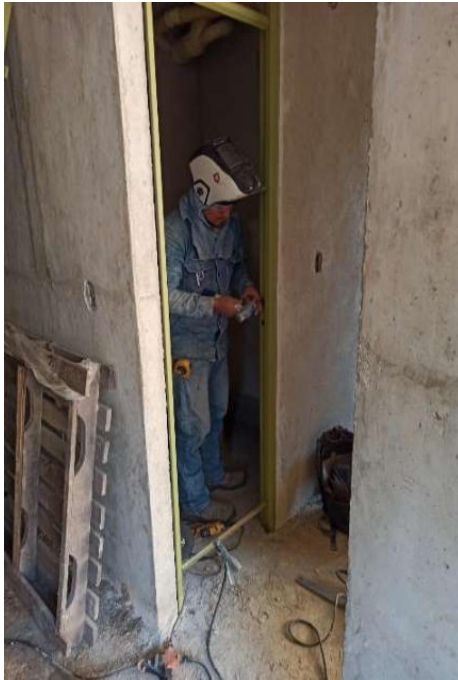
Figura 53. Instalación de base da la puerta del baño
