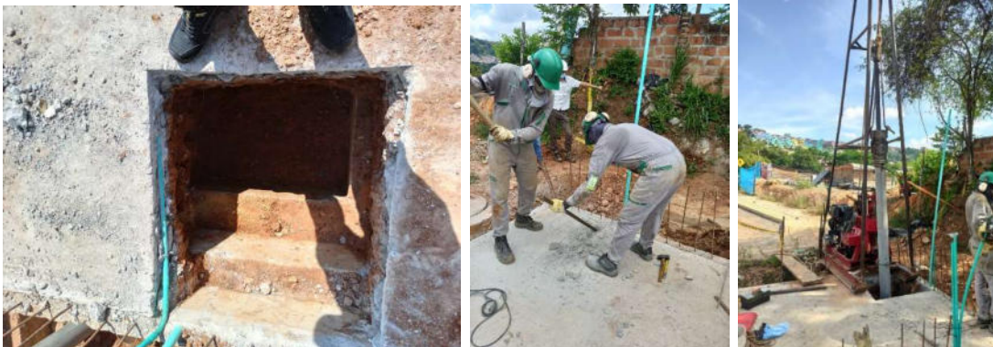
Figura 14.Perforación de la cimentación e hincada para el micro pilote 1
