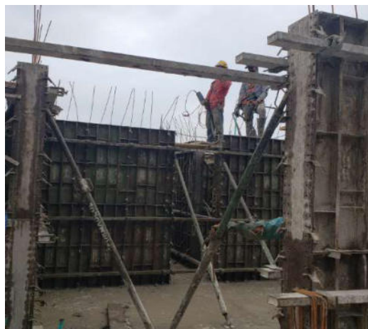
Figura 35. Fundición de los muros estructurales
