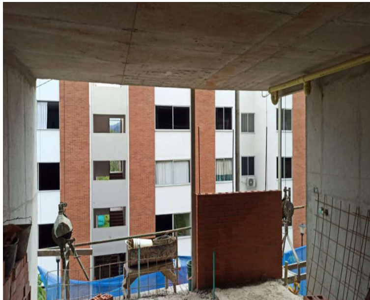
Figura 40.Mampostería de fachada a la vista 3 pisos
