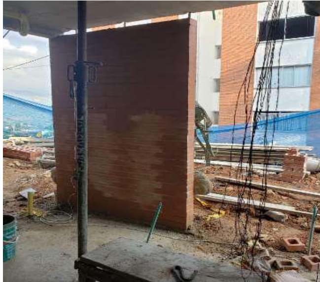
Figura 41.Mampostería de fachada a la vista 1 piso
