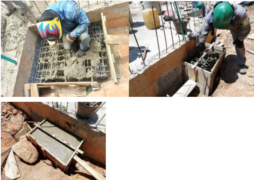
Figura 28. Fundición de dados
