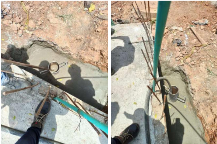
Figura 18. Inyección de micropilotes
