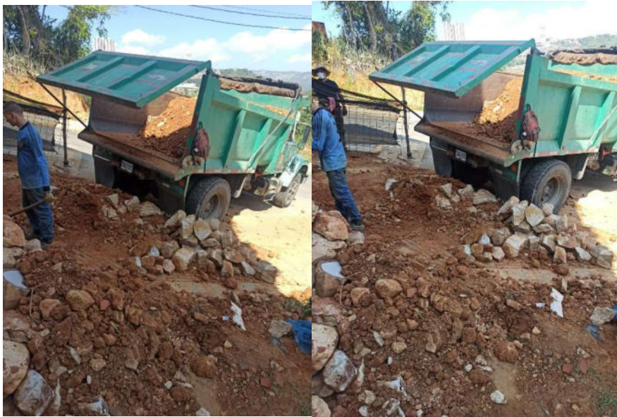
Figura 60. Retiro de escombros
