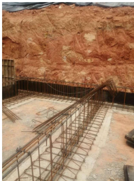
Figura 3. Aceros de zarpas y vigas de cimentación
