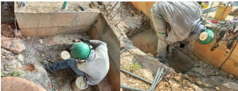
Figura 19. Perforación de zapatas y vigas
