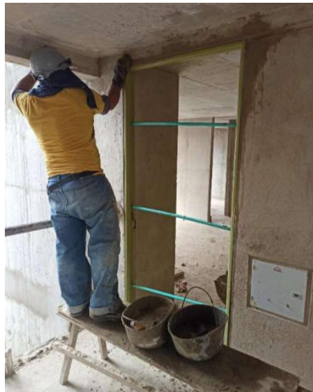
Figura 54. Relleno de la base de la puerta del apartamento
