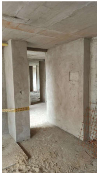
Figura 43. Friso de muros de acceso al apartamento terminado
