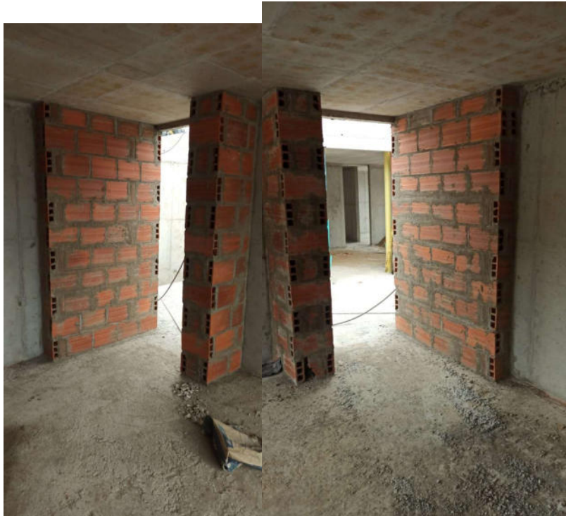
Figura 39.Mampostería acceso a apartamentos
