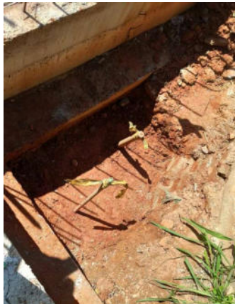
Figura 12. Ubicación de los micros pilotes
