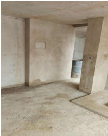
Figura 48. Terminación completa de muro y caja de tacos
