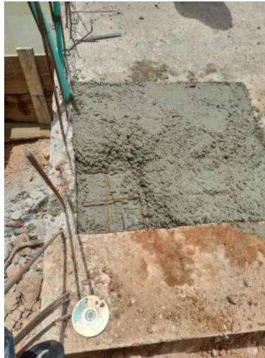
Figura 31. Fundida final del sobrecimiento
