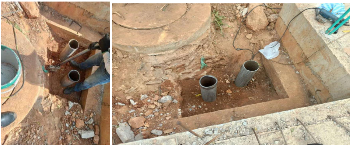
Figura 16.Compactación y limpieza del suelo
