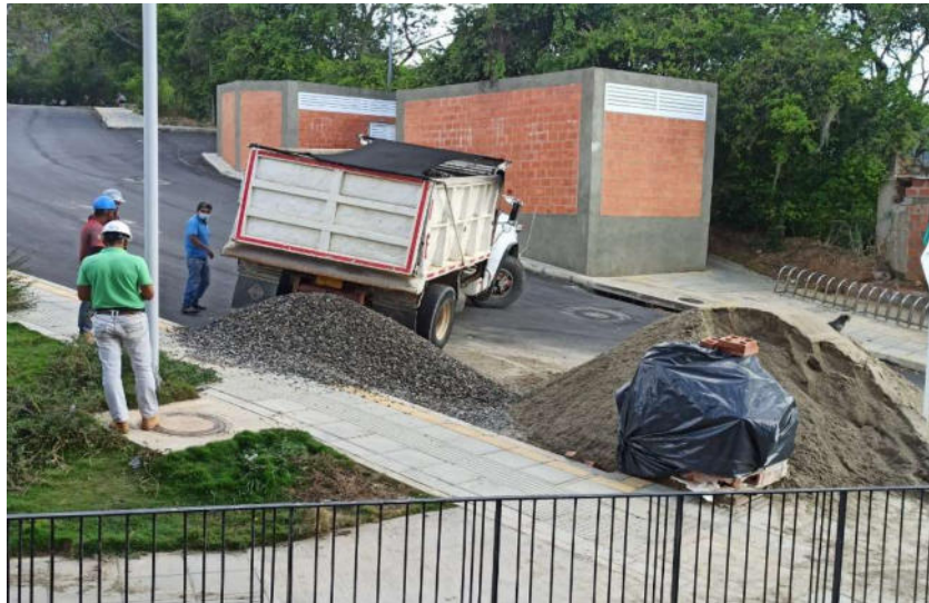
Figura 58.Descargue del triturado y arena
