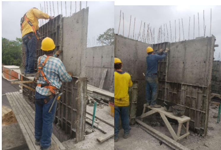
Figura 37.Desencofrado de muros estructurales
