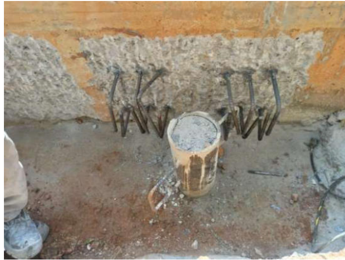
Figura 22. Anclajes ya empalmados en la cimentación
