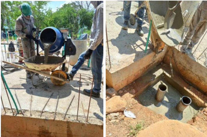
Figura 17. Fundida de solado
