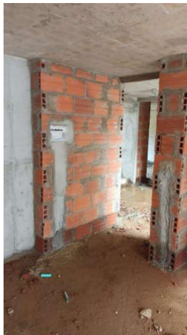
Figura 47. Cubrimiento de tubería de caja de tacos
