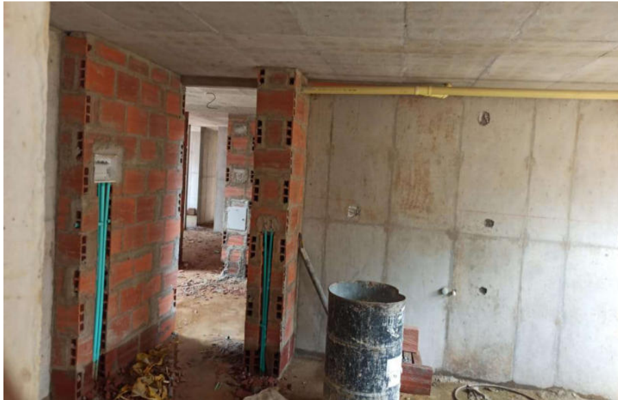
Figura 46. Tubería de caja de taco de corriente
