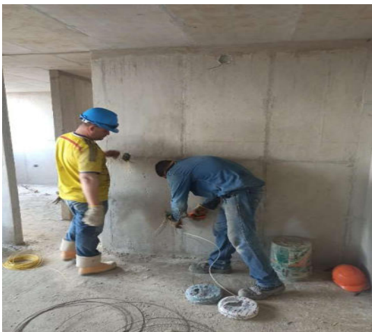
Figura 56. Alambrado de apartamentos
