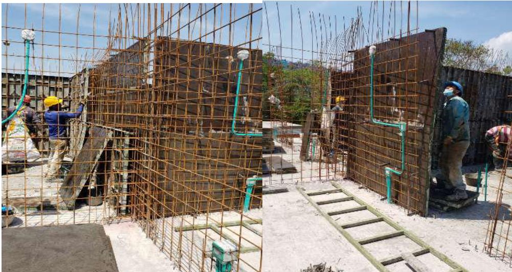
Figura 34. Armado de mallas y formaletas para muros estructurales
