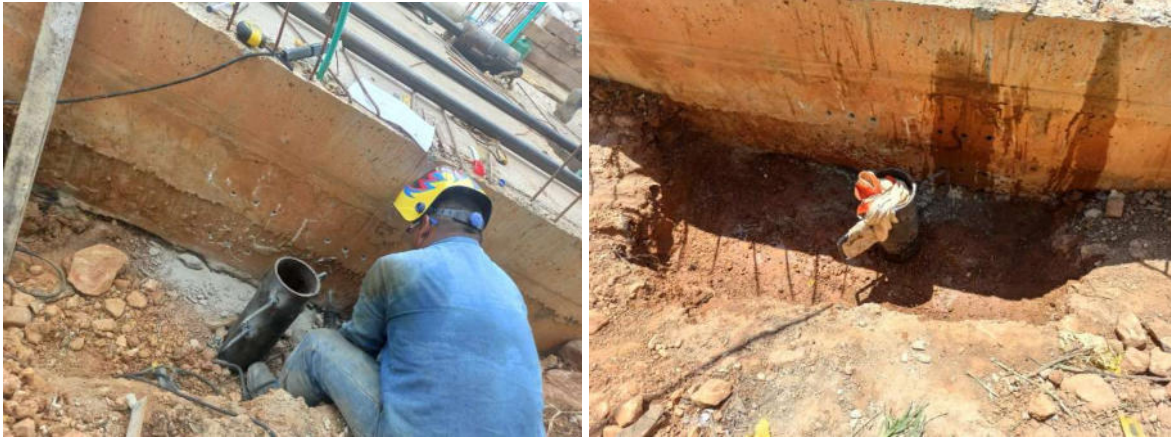
Figura 15 .Perforación de la cimentación para los flejes de anclaje
