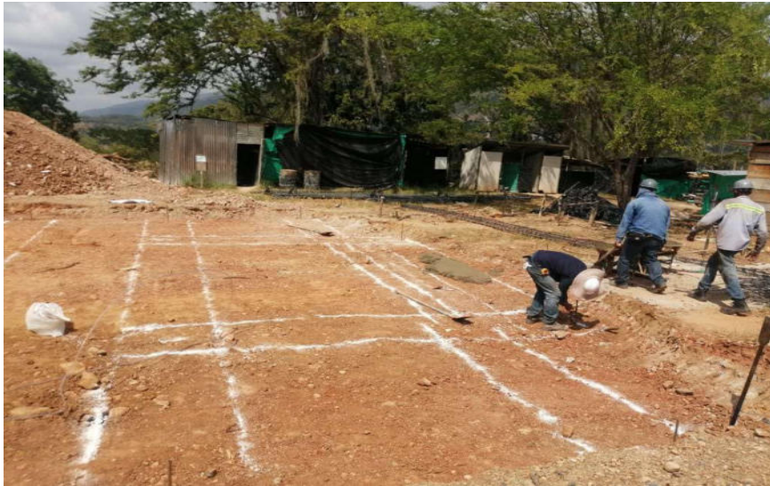
Figura 2. Marcación del solado de la cimentación
