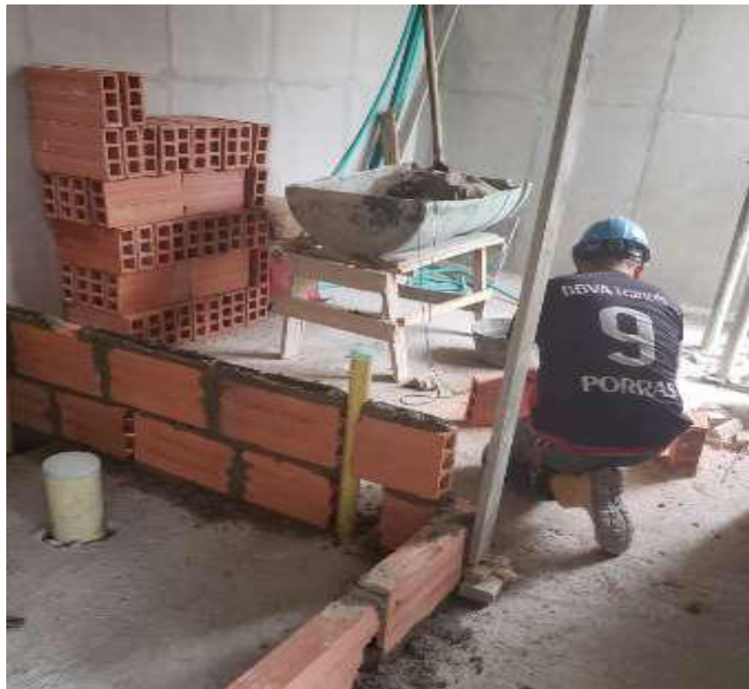
Figura 38. Elaboración de la mampostería de baños
