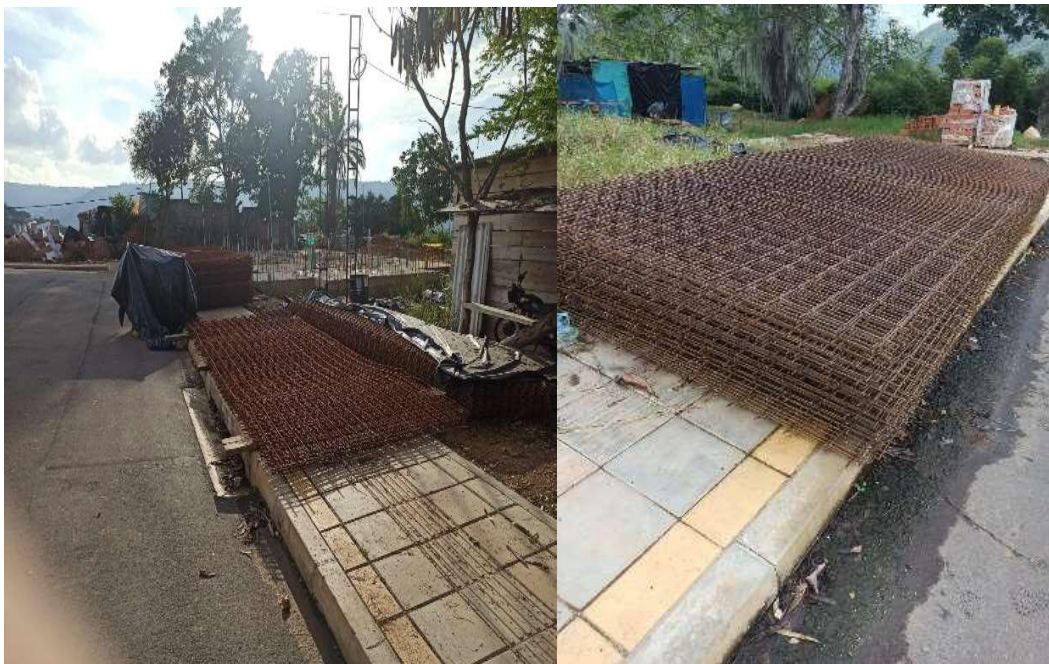
Figura 57. Almacenamiento de malla estructural
