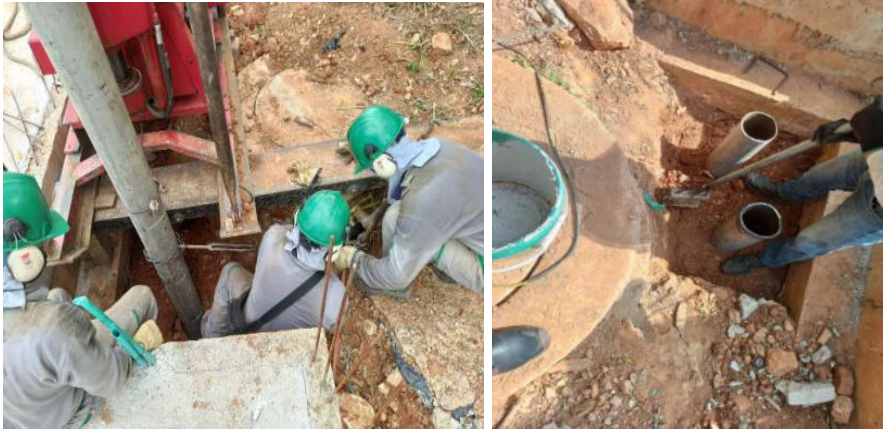
Figura 13.Hidada de micropilote
