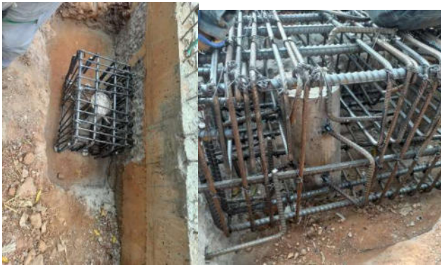
Figura 25. Armadura armada y soldadura de orejas del micro pilote
