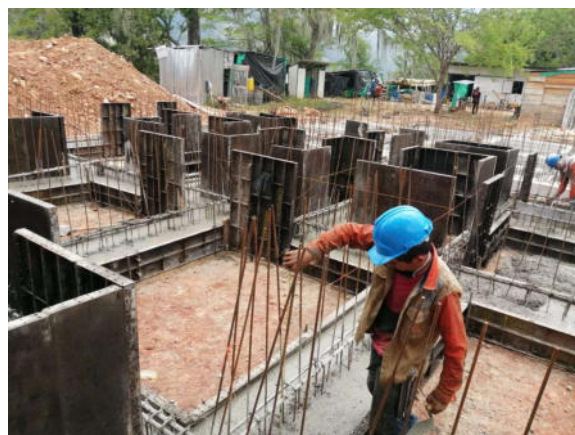
Figura 5. Revisión de hierros de arranque
