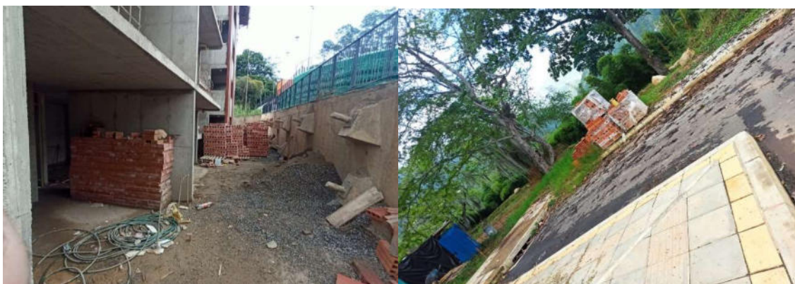
Figura 59.Almacenamiento de ladrillos
