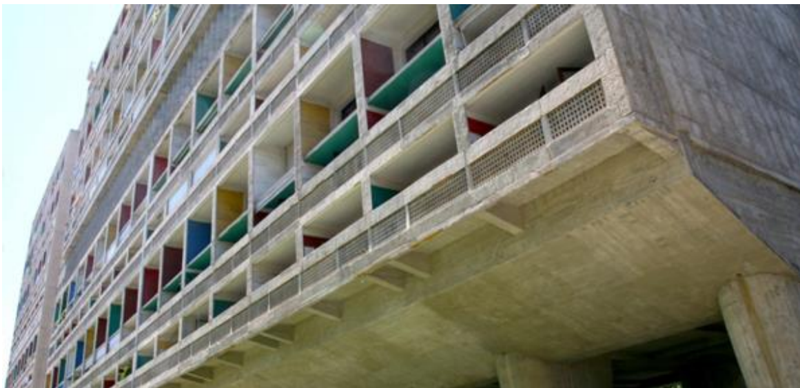
Figura 20. Vista Exterior de Unité d'habitation de Marseille. ArchDaily, (s.f.).
