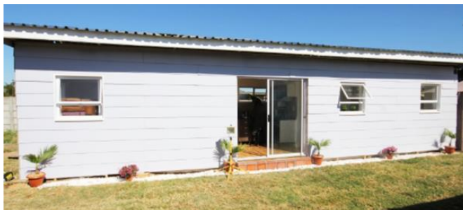
Figura 70. Fachada de la unidad habitacional. Kalil (s.f.).
