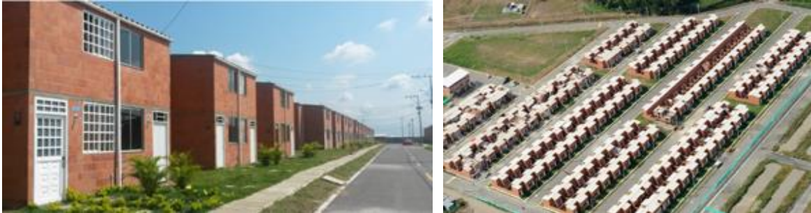
Figura 36. Vivienda de interés social de dos pisos en la ciudad de Cali, Colombia. Skema (s.f.).
