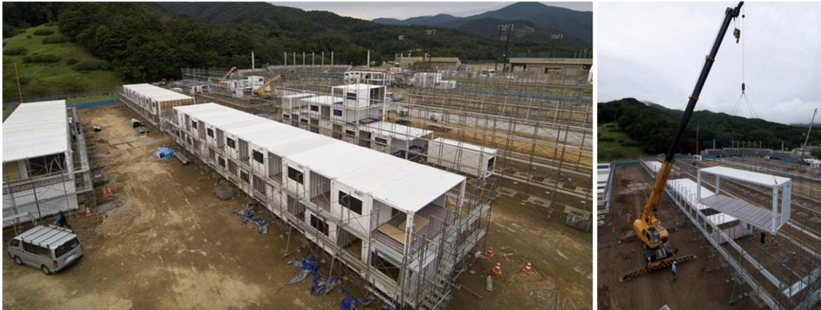
Figura 49. Proceso de construcción, Onagawa Container Temporary Housing. Designboom (2012).
