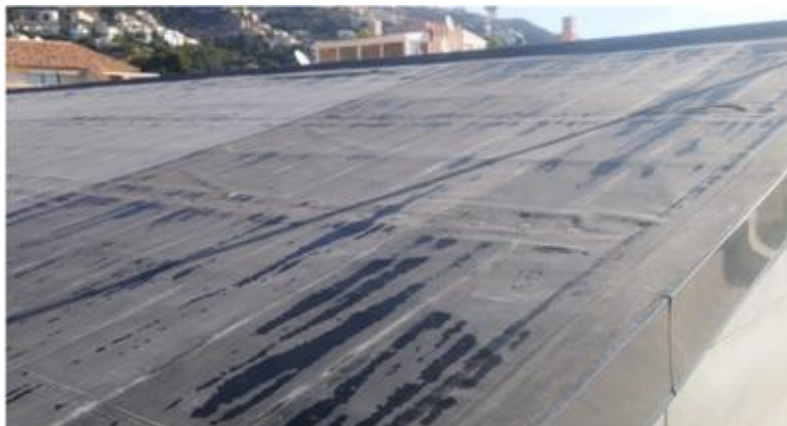
Ilustración 1. EPDM, Sistema de impermeabilización amigable con el ambiente. Wit (s.f.).
