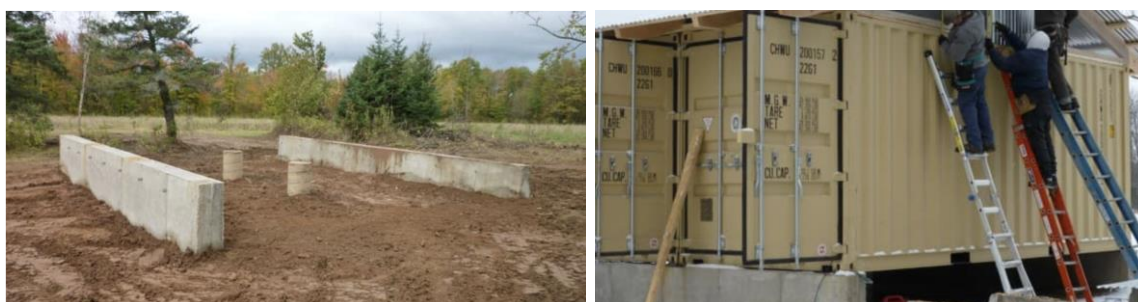
Figura 81. Sistema de zapata corrida. Dazne (2014).
