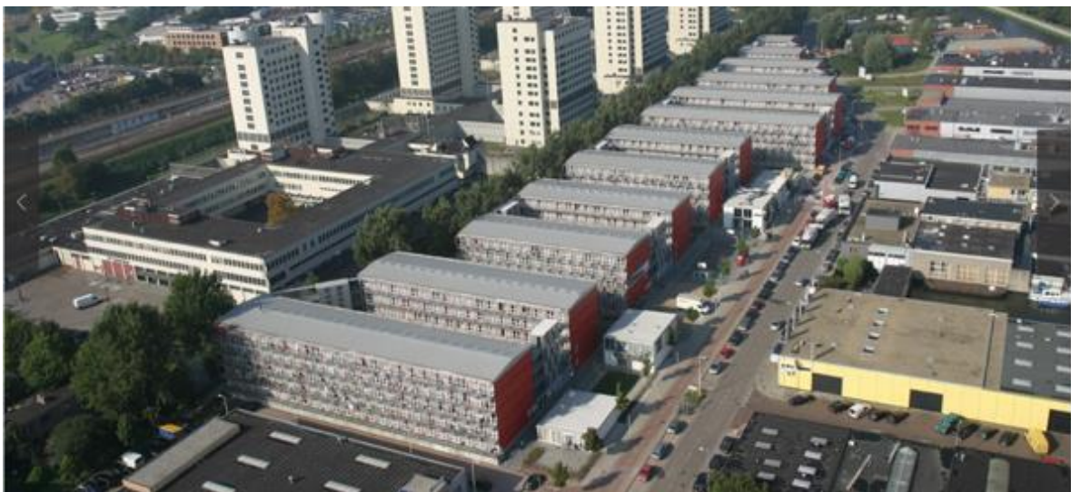
Figura 62. Vista del conjunto residencial. (Tempohousing, 2006)
