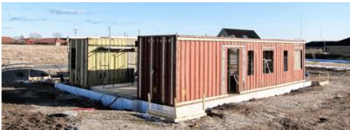
Figura 73. Proceso constructivo de la vivienda. Archdaily (2014).
