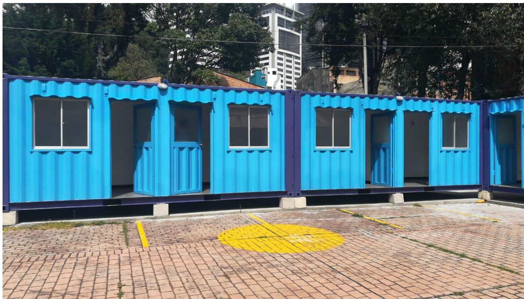
Figura 79. Sistema de "dados" de concreto. El Trébol (2020)
