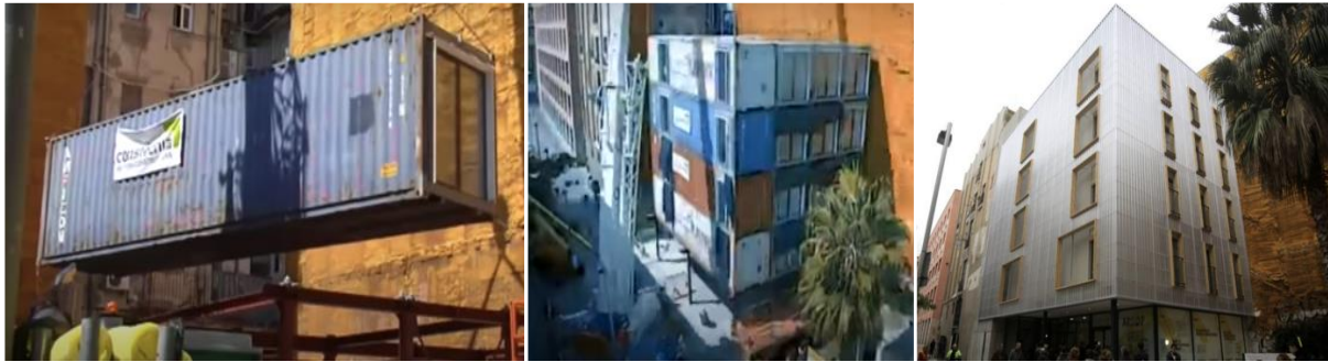
Figura 11. Vivienda Contenedor para el Ayuntamiento de Barcelona. Blanchar (2019).
