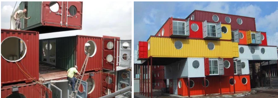
Figura 57. Ensamble de las unidades y vista exterior del conjunto. Alamy (s.f.).
