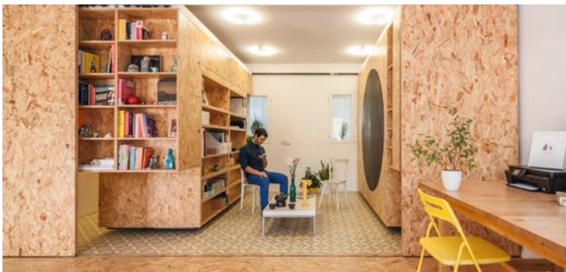
Figura 84. Revestimiento interior con panales de OSB. Galindo (2015).
