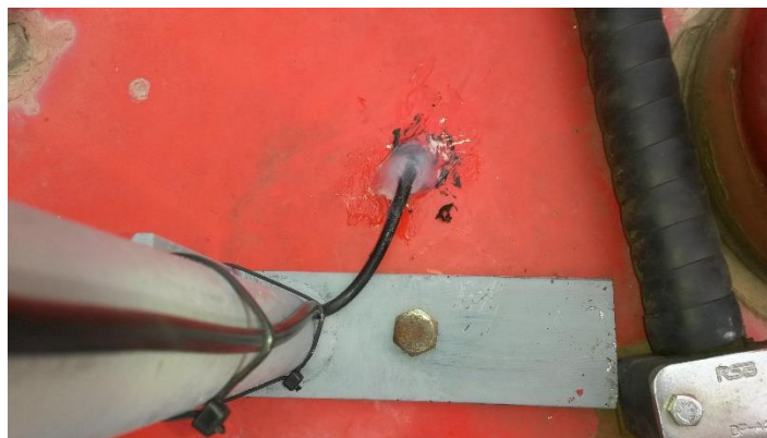
Figura 41: Vista superior entrada de cable de antena omnidireccional.
