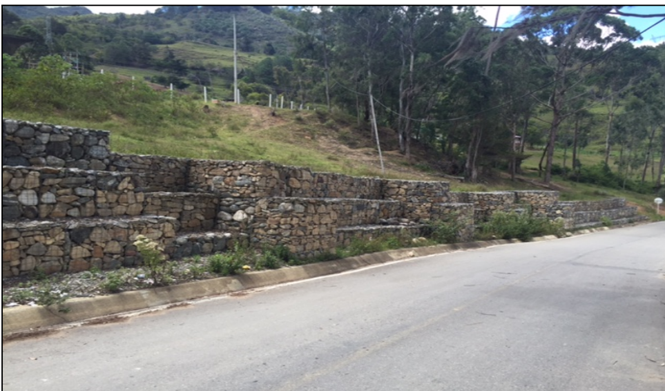
Fotografía 4: Vista longitudinal del muro en gavión con malla electrosoldada costado derecho de la vía que conduce del Municipio de Matanza al Municipio de Surata. Fuente propia
