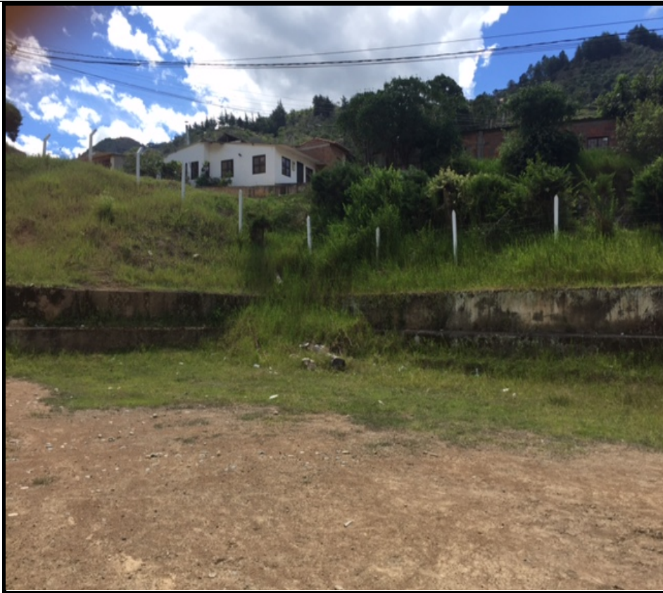
Fotografía 1: Panorámica muro en gavión Polideportivo Leoncio Silva, cerro sagrado Corazón Municipio de Matanza
