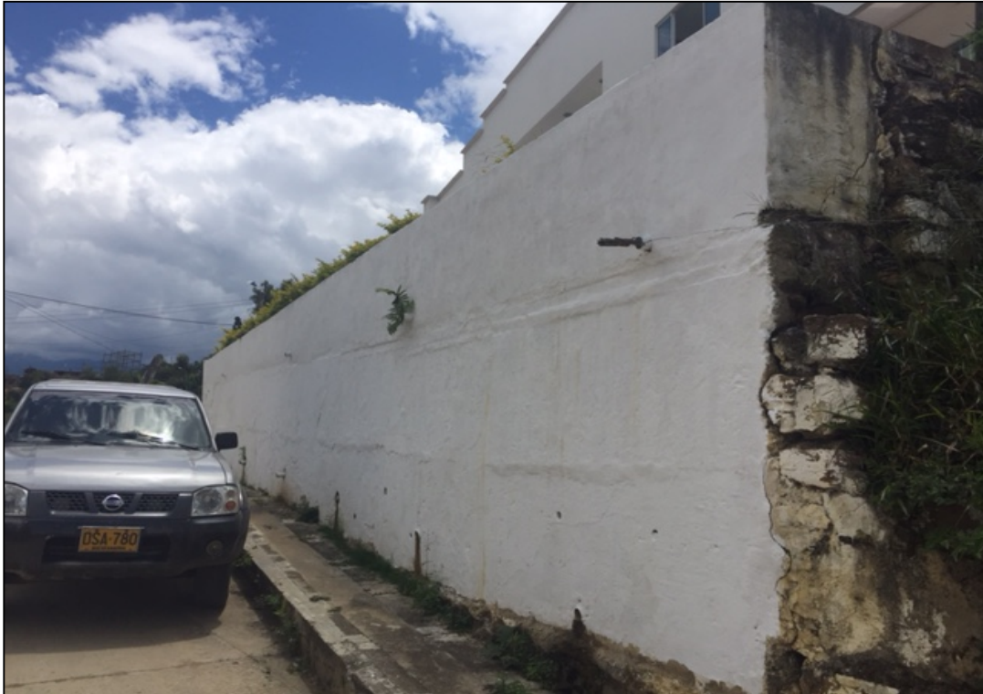
Fotografía 8: Muro en gavión Hospital de Matanza
