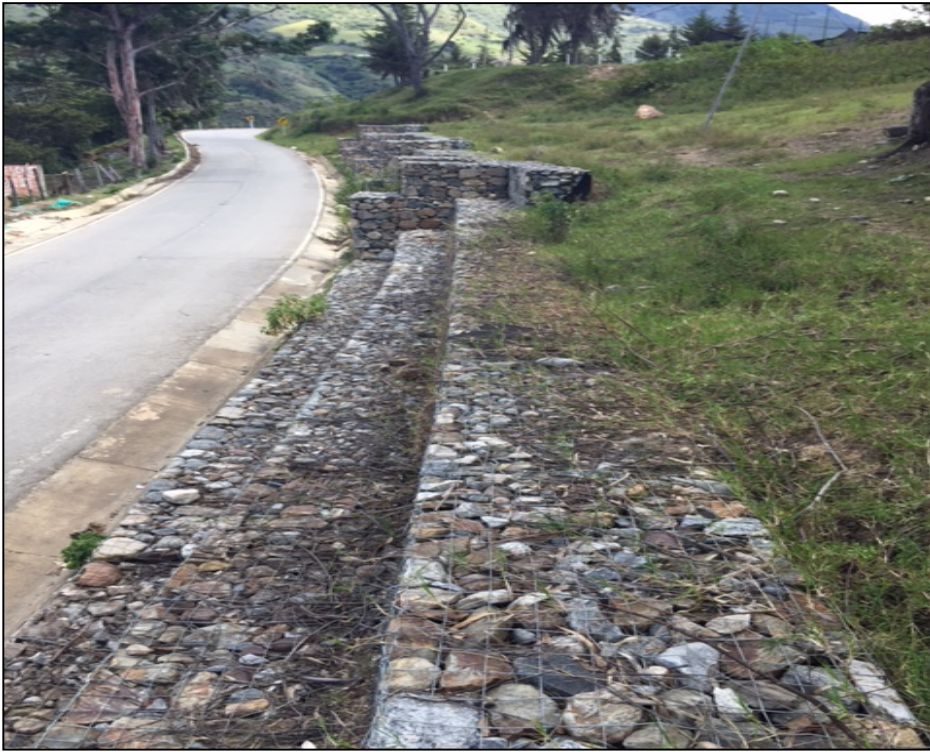
Fotografía 5: Parte superior del muro en gavión con malla electrosoldada costado derecho de la vía que conduce del Municipio de Matanza al Municipio de Surata. Fuente propia
