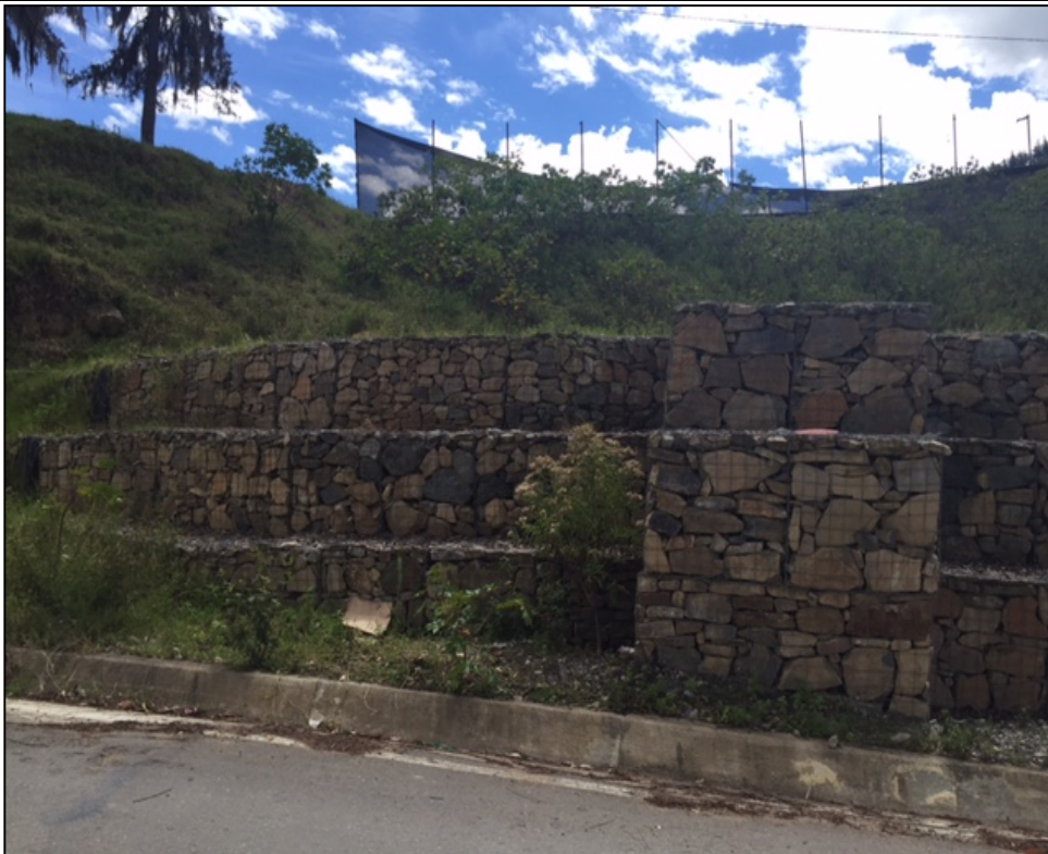
Fotografía 3: Muro en gavión con malla electrosoldada costado derecho de la vía que conduce del Municipio de Matanza al Municipio de Surata. Fuente propia
