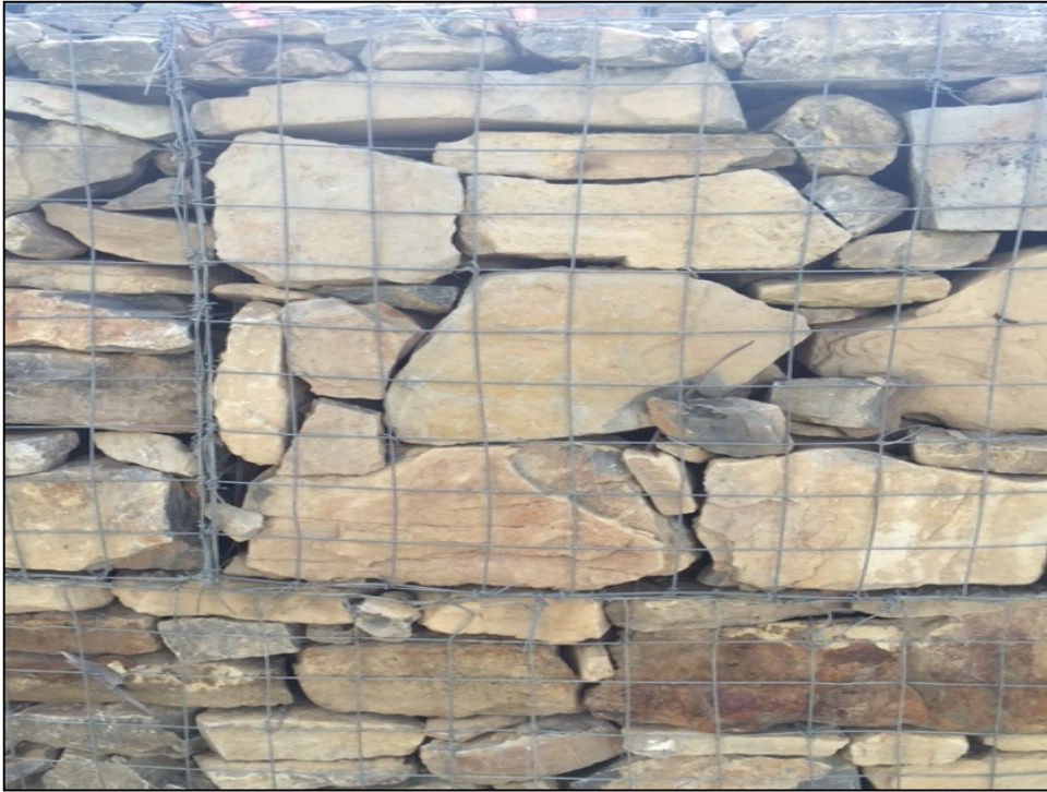
Fotografía 2: Pie de talud y muro en gavio parte superior.
