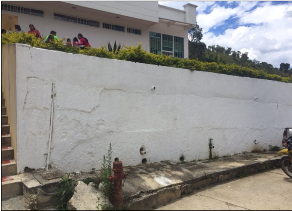
Fotografía 6: Muro en gavión Hospital de Matanza
