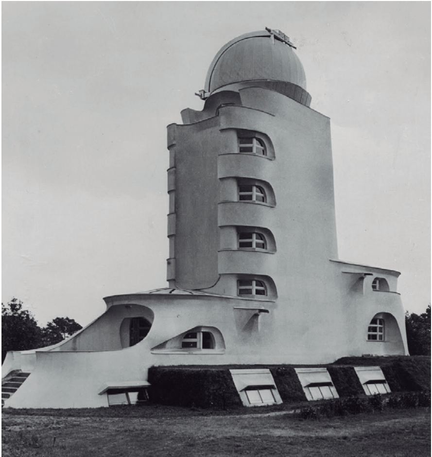
Figura 20. [Fotografía] Einsteinurm del Arq. Enric Mendelsohn - Autor desconocido [s.f.]
