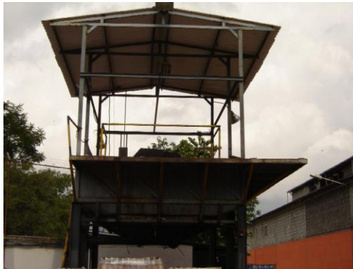
Foto 5. Aspecto adecuado de la tolva
