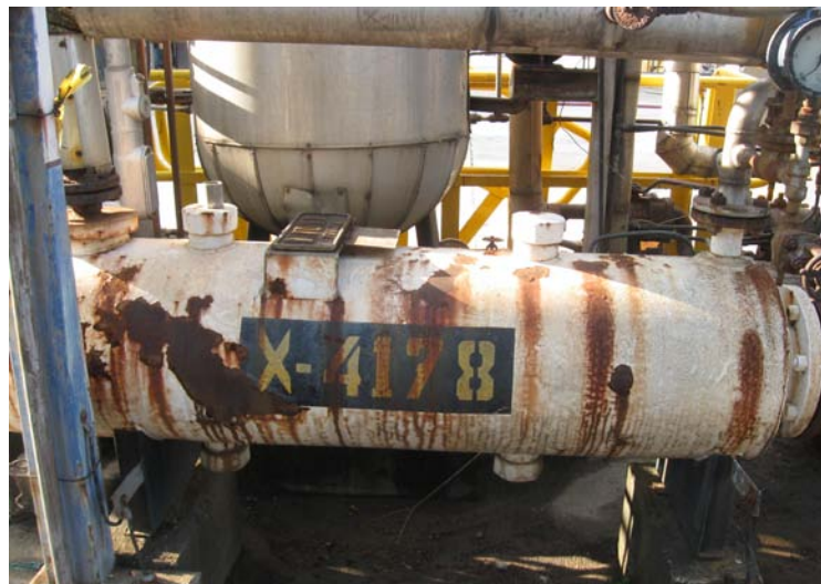
Figura 9. Resistencia de Regeneración X-4178 [1]
