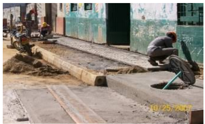
Instalación de loseta guía y lisa, remates contra predios
