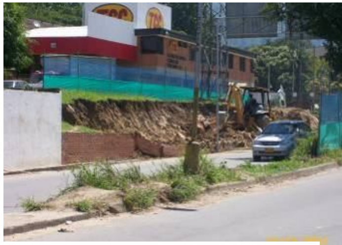
Muro de contención frente al establecimiento TCC, costado oriental
