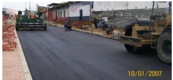
Aplicación de pavimento de alto modulo
