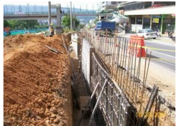
Muro de Equilibrio, ubicado en el costado occidental
