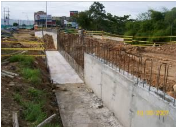
Muro denominado de La Cuellar, ubicado al pie de la torre Picasso que actualmente se encuentra en construcción, calzada occidental.
