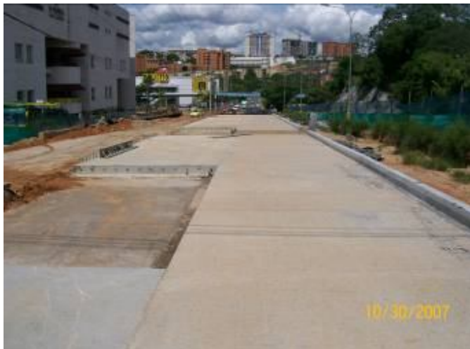
Detalles losas de concreto rígido frente CC. La Florida, costado occidental.
