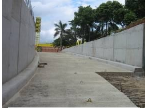
Piso y Muros a la salida del Túnel sobre la Dgnal 15
