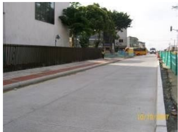
Vaciado de concreto Cra 27 calles 14-16
