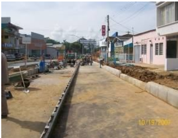
Colocación de Formaleta para vaciado de concreto
