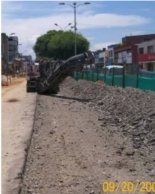
Fresado calzada oriental entre calle 16 y 18
