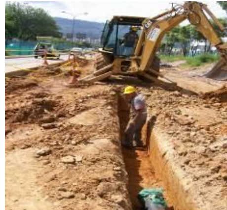
Algunos trabajos de instalación de tubería de alcantarillado, calzada occidental.
