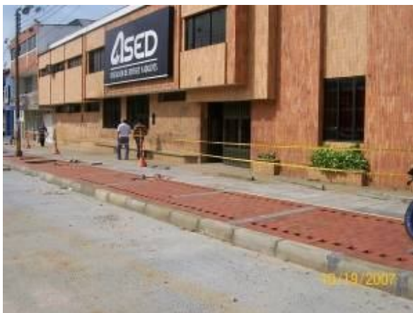
Construcción de andén Cra. 27 calles 19-20
