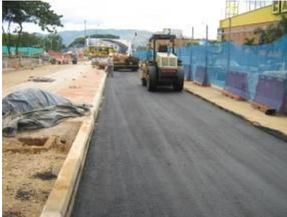
Construcción del tercer carril Avenida La Rosita
