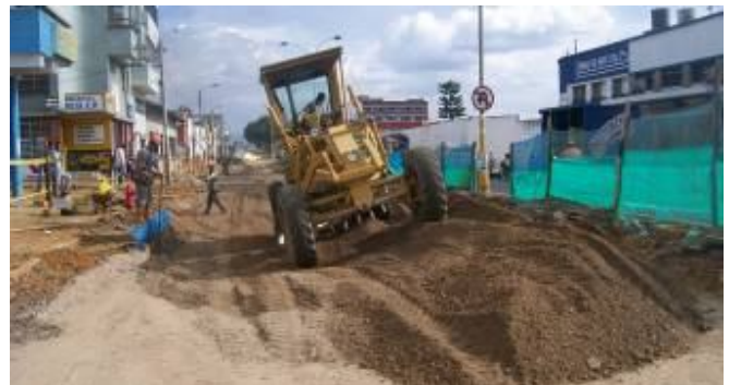
Conformación de subrasante
