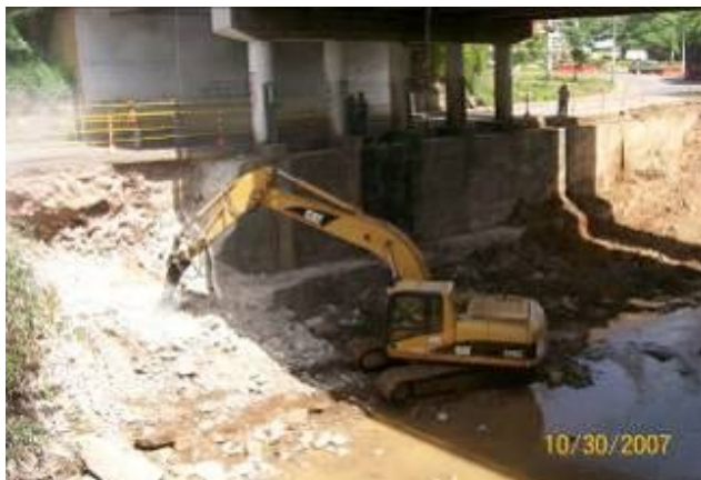
Ampliación del puente vehicular de Cañaveral
