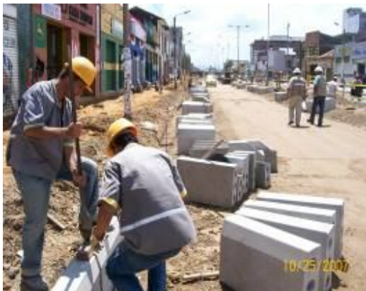
Instalación de Sardinel entre calles 17 y 18
