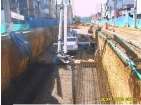
Aplicación de concreto a la entrada del Túnel carrera 17
