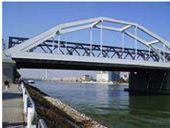
Fig. 5.9. Puente fabricado en acero.
