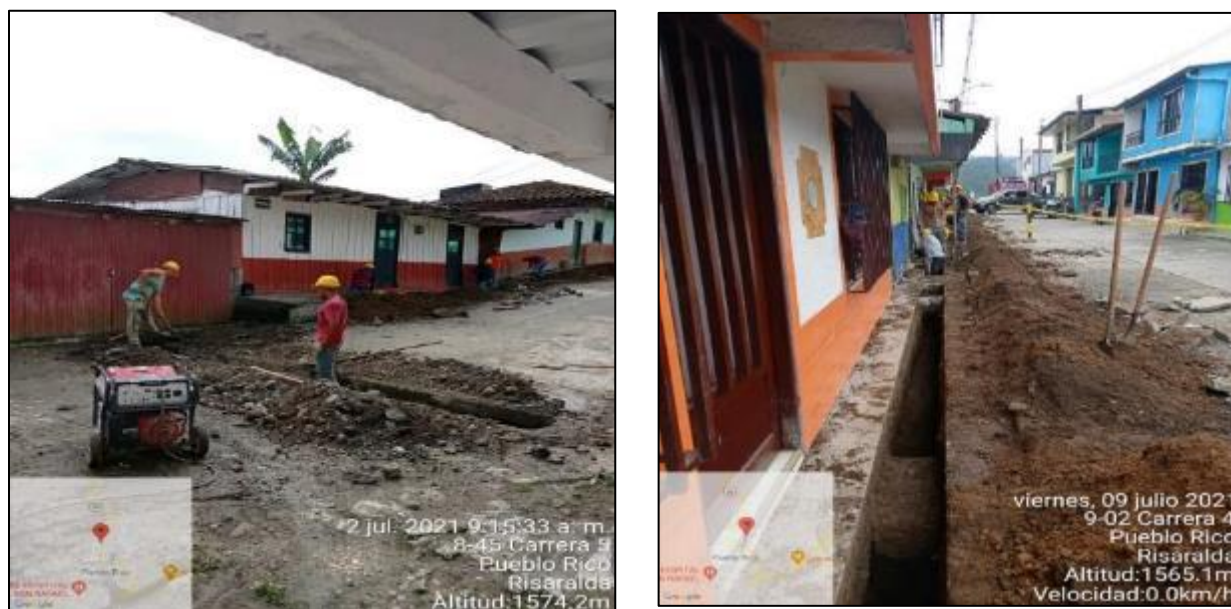
Ilustración 36. Excavación de zanjas. Proyecto No.2.
