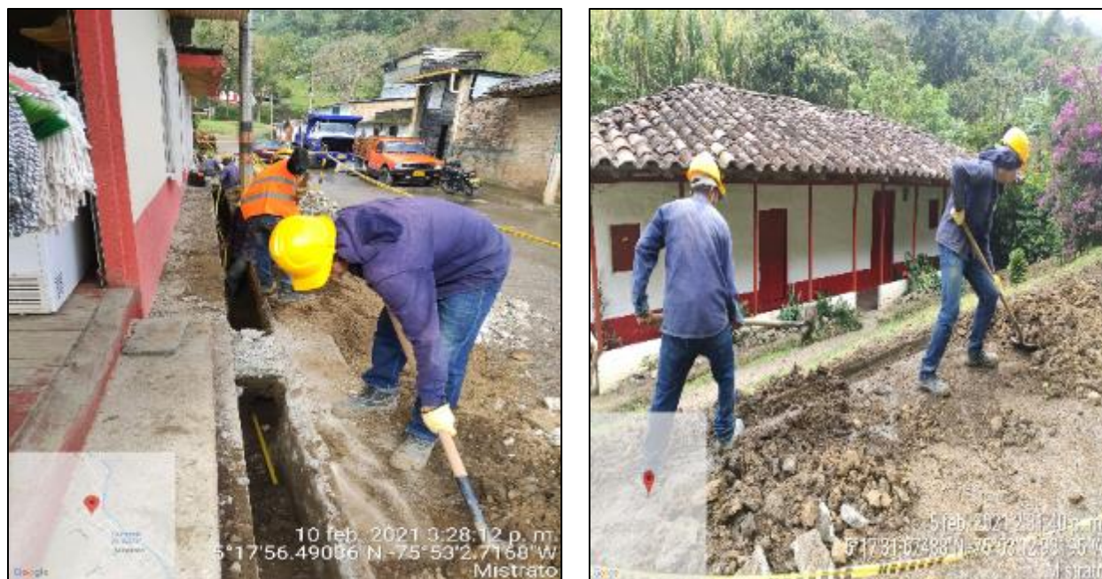
Ilustración 18. Tape Manual Proyecto No. 1.
