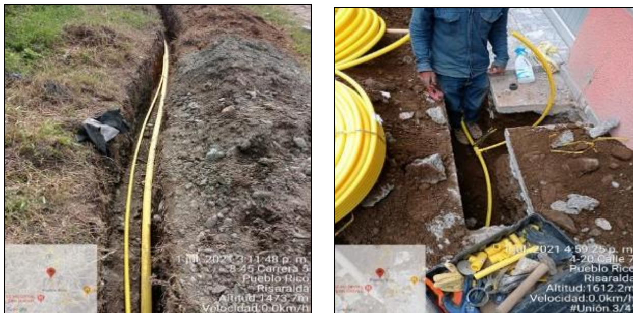
Ilustración 37. Suministro e Instalación de Tubería. Proyecto No.2.
