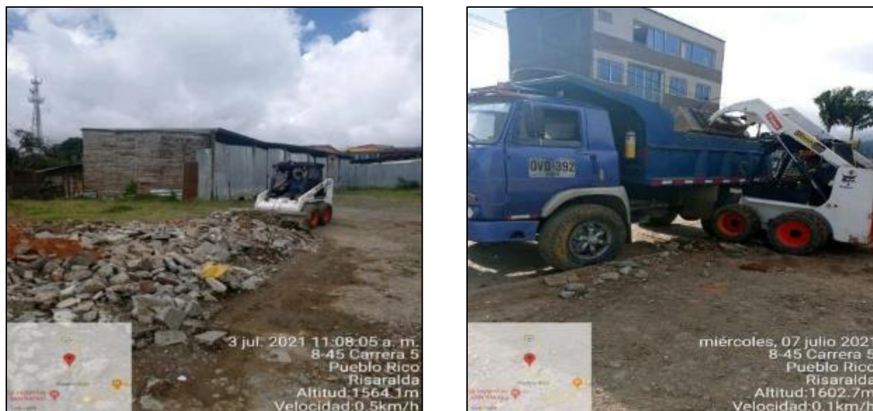
Ilustración 43. Retiro de Escombros. Proyecto No.2.
