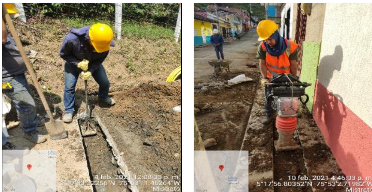
Ilustración 20. Compactación Manual del Proyecto No.1.
