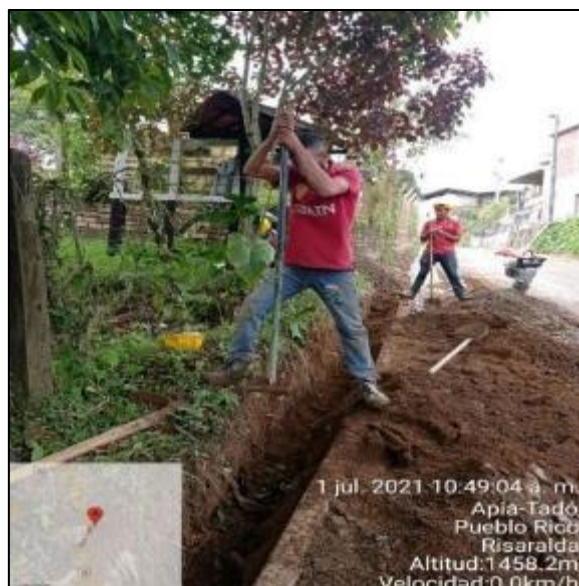
Ilustración 40. Compactación Manual. Proyecto No.2.
