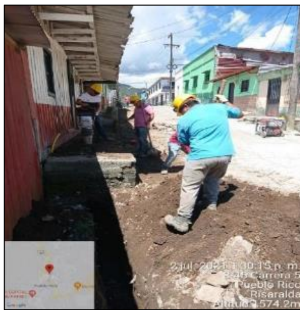
Ilustración 38. Tape Manual. Proyecto No.2.
