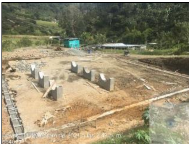
Ilustración 27. Vigas de Encerramiento de la Estación.
