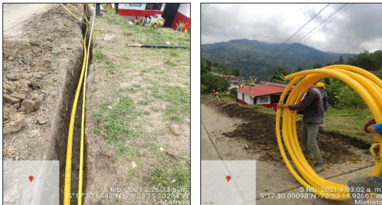
Ilustración 17. Suministro e Instalación de Tubería. Proyecto No. 1.
