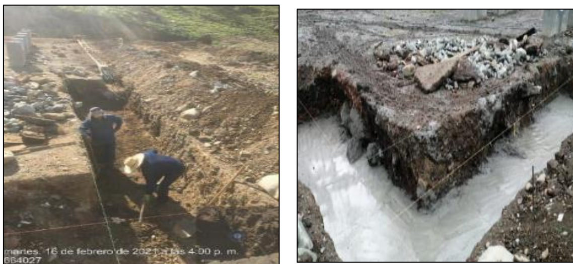
Ilustración 26. Construcción Zapata.
