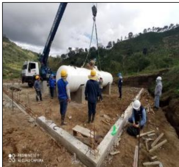
Ilustración 24. Colocación Tanques de Almacenamiento.
