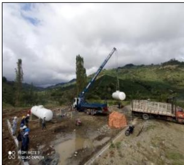
Ilustración 25. Montaje Final Tanques de Almacenamiento.
