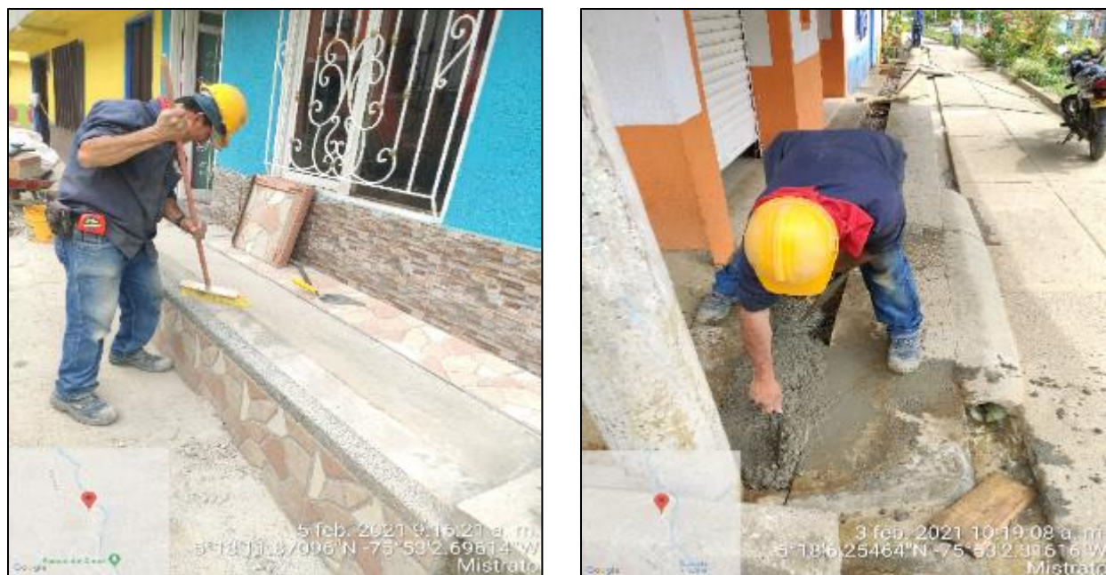
Ilustración 21. Reposición de Andenes en Concreto o Tableta. Proyecto No.1.
