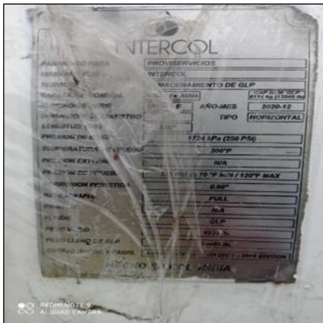
Ilustración 23. Especificaciones Tanque de 3000 GL.
