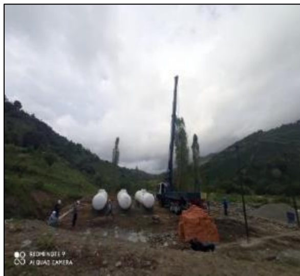
Ilustración 25. Montaje Final Tanques de Almacenamiento.
