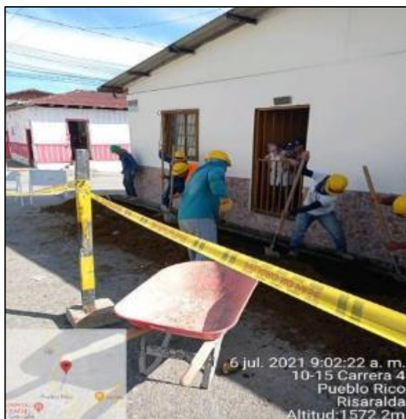
Ilustración 38. Tape Manual. Proyecto No.2.
