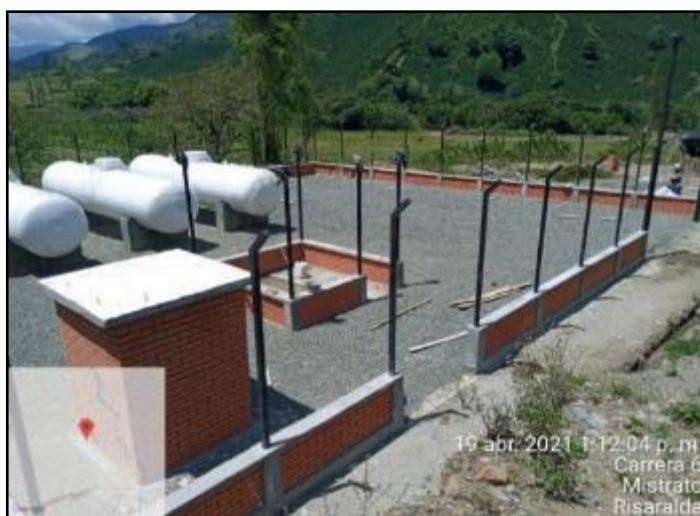
Ilustración 30. Puesta en Sitio del Suelo de la Estación.
