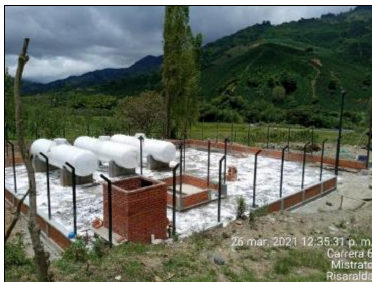
Ilustración 29. Construcción de Caseta y Cerramiento.
