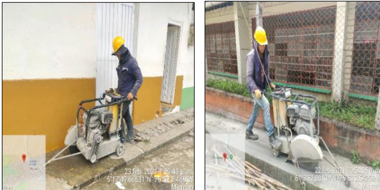
Ilustración 14. Corte de Concreto o Anden. Proyecto
