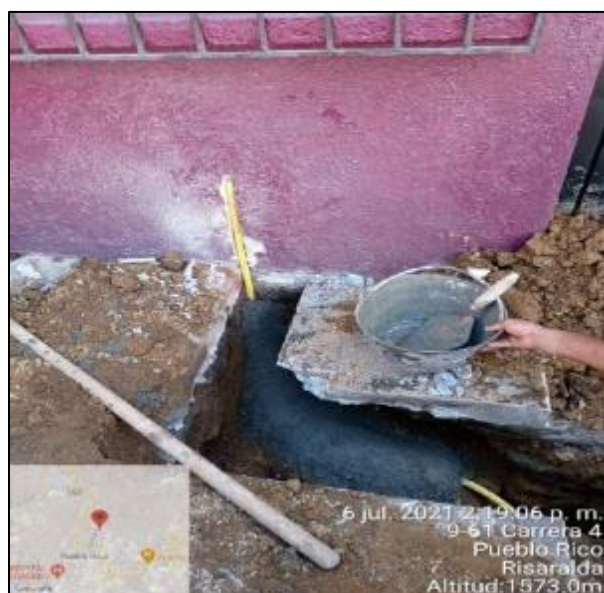
Ilustración 34. Corte de Concreto o Tableta. Proyecto No.2.
