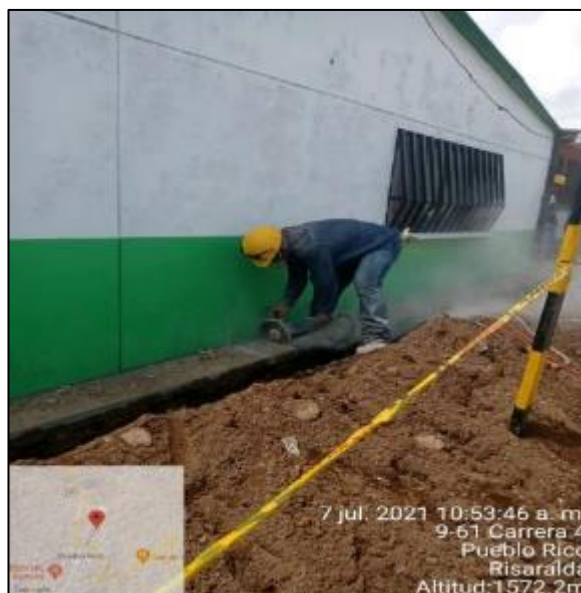
Ilustración 34. Corte de Concreto o Tableta. Proyecto No.2.
