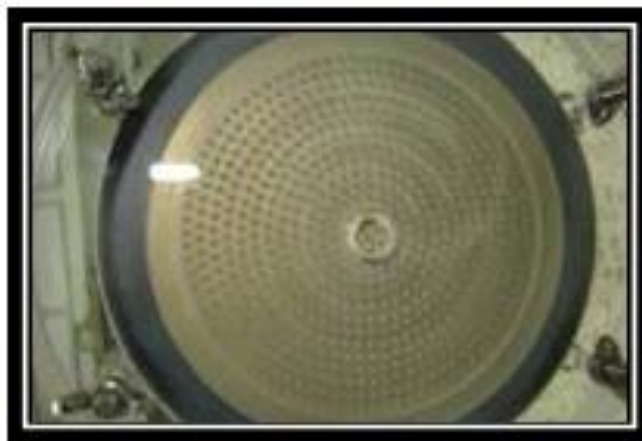
Figura 16 Revisión empaques y ajustes terminales columna
