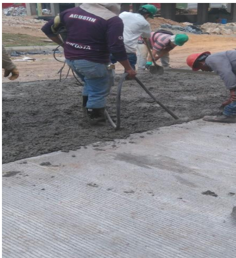
Figura 43 Vibrado vertical del concreto en forma de "zig-zag"
