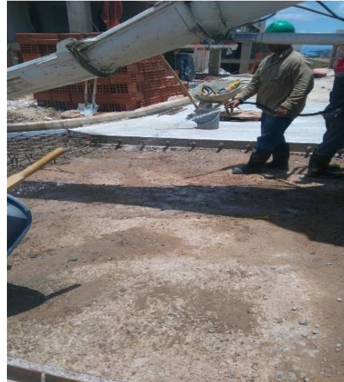
Figura 42 Humedecimiento del terreno
