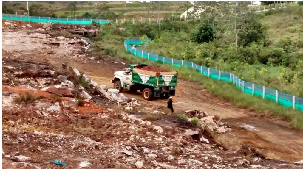
Figura 35 Movimiento de tierra
