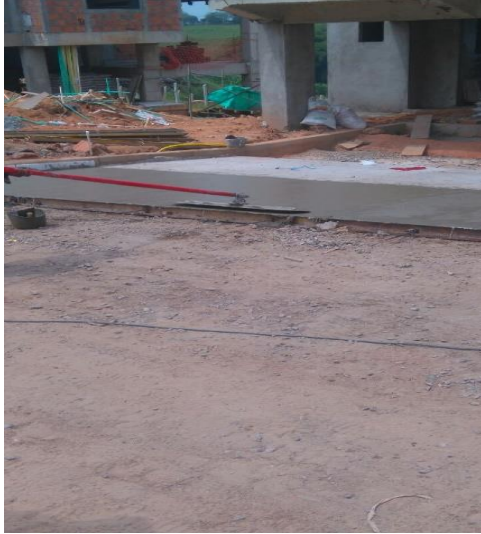
Figura 45 Flotacanal
