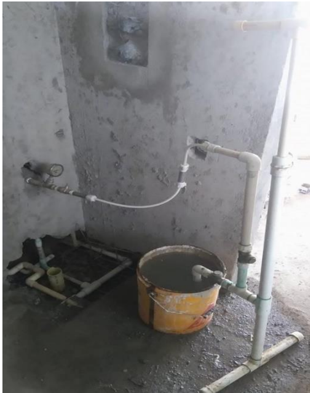
Figura 16 Instalación prueba hidráulica
