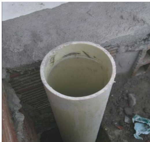
Figura 21 prueba de estanqueidad
