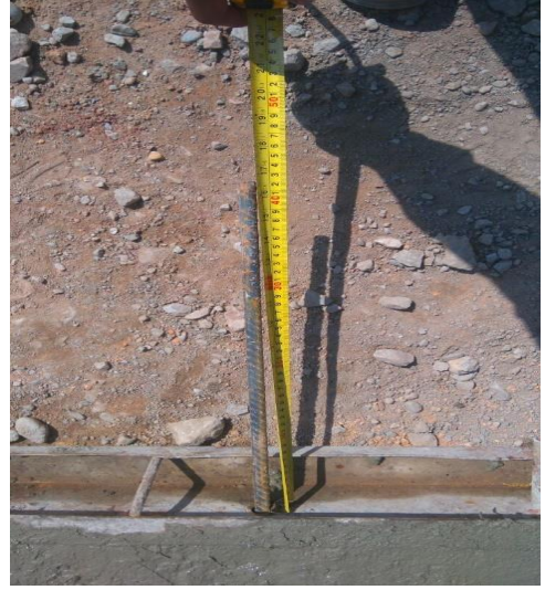
Figura 46 Revisión acero de transferencia longitudinal
