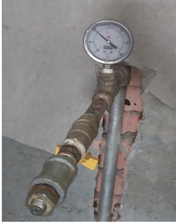
Figura 19 Manómetro ubicado.
