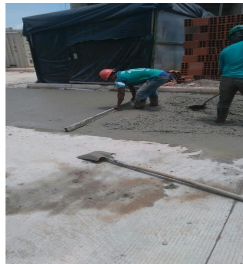
Figura 44 Recorte de concreto con regla
