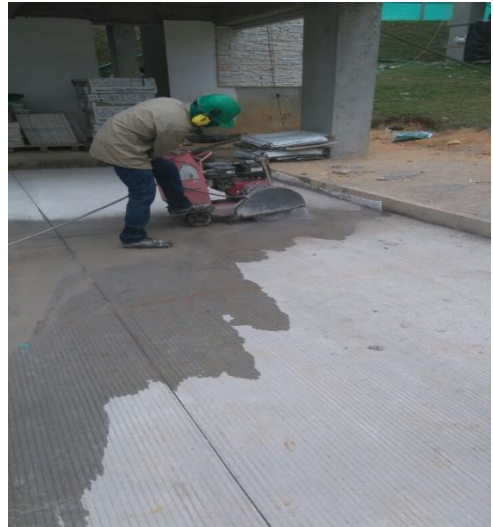
Figura 48 Corte de losas de concreto
