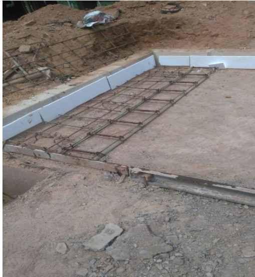
Figura 41 Aislamiento y refuerzo de losa
