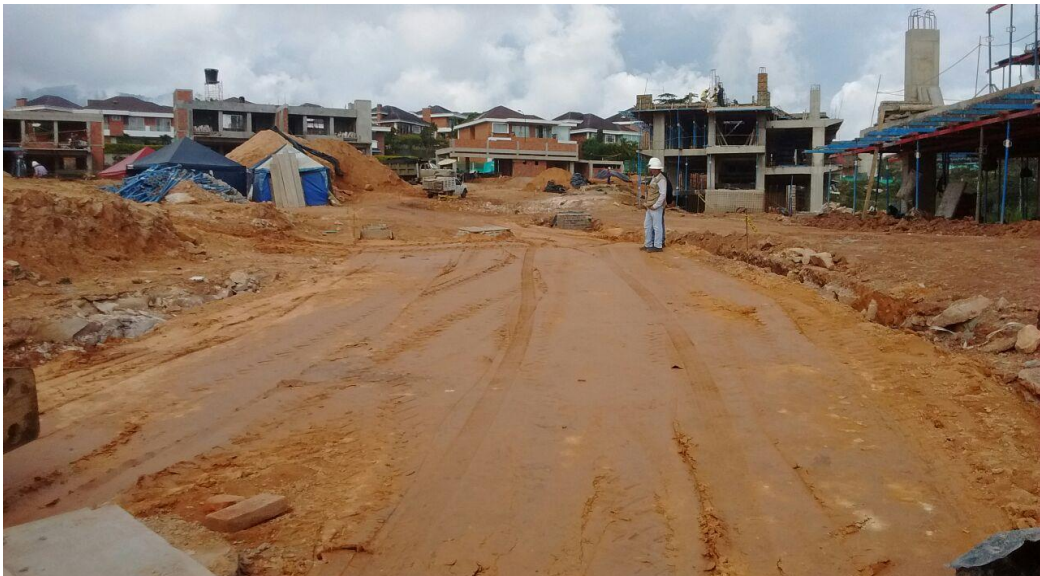
Figura 37 Conformación de la subrasante
