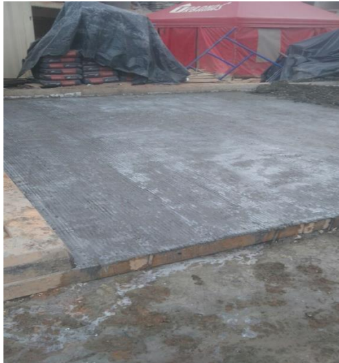
Figura 47 Losa posterior al rayado y curado
