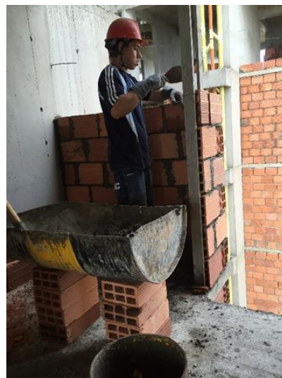
Figura 11 Cuadrilla A Mampostería
