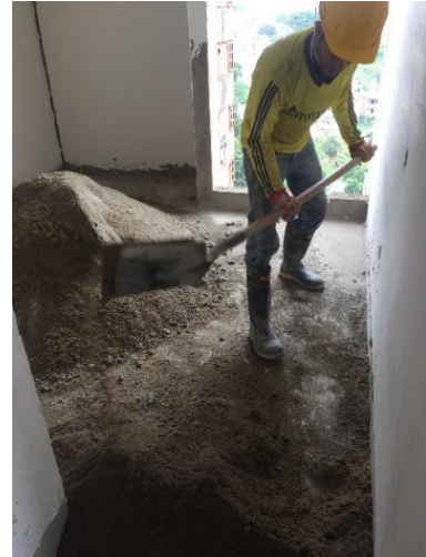
Figura 13 Cuadrilla B Mortero de nivelación
