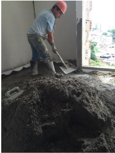
Figura 12 Cuadrilla A Morteros de nivelación
