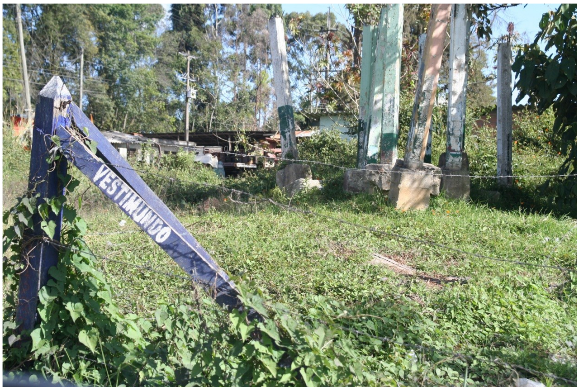
Figura 52. [Fotografía de Vicente Guerra Peña]. (2013). El predio está ubicado en el borde del lote de Vestimundo y la carretera antigua entre Rionegro y Marinilla. Se observa hacia el centro las columnas de una estructura antigua. Vicente Guerra Peña. Archivo personal.
