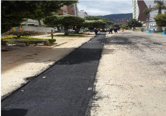
Figura 22. Instalación de mezcla asfáltica.
