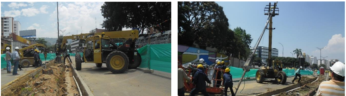
Figura 12. Cargue y transporte a escombrera (Incluye disposición final).
