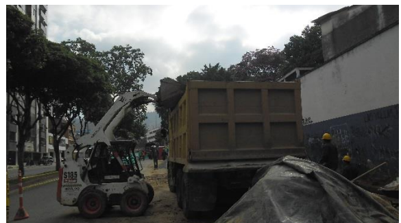
Figura 8. Cargue y transporte a escombrera (Incluye disposición final).
