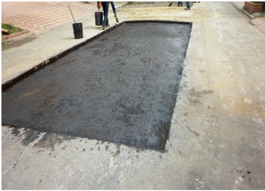
Figura 28. Instalación de mezcla asfáltica.
