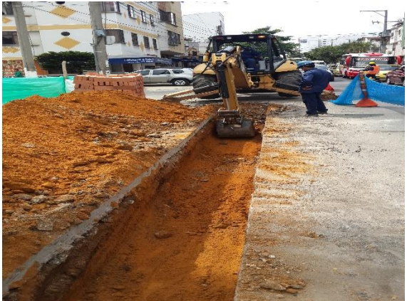
Figura 15. Excavación y replanteo.
