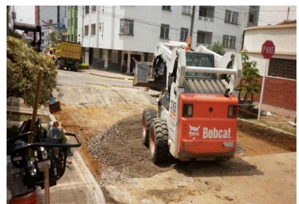
Figura 26. Instalación y compactación de la base granular.
