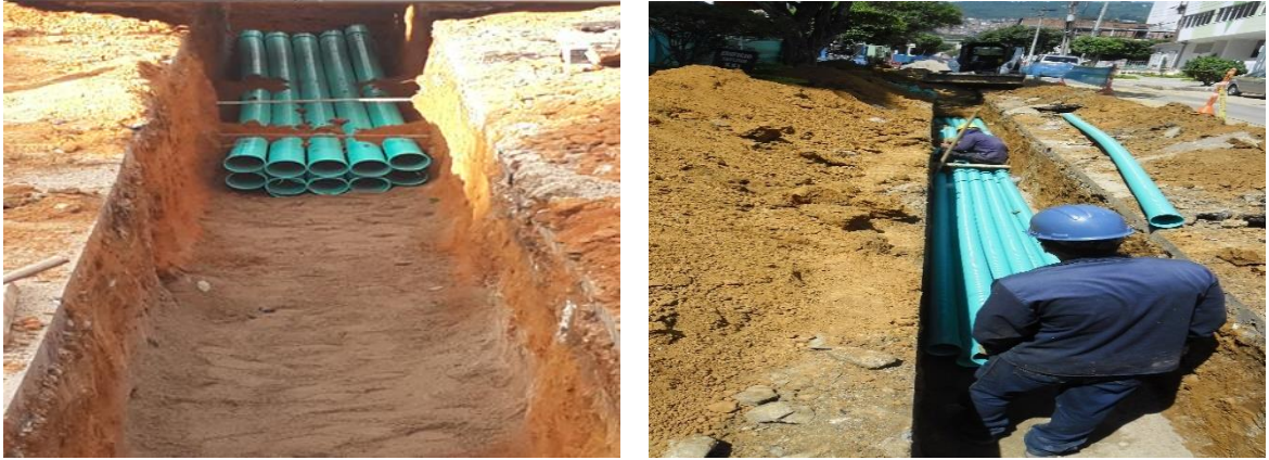
Figura 17. Relleno con material seleccionado.
