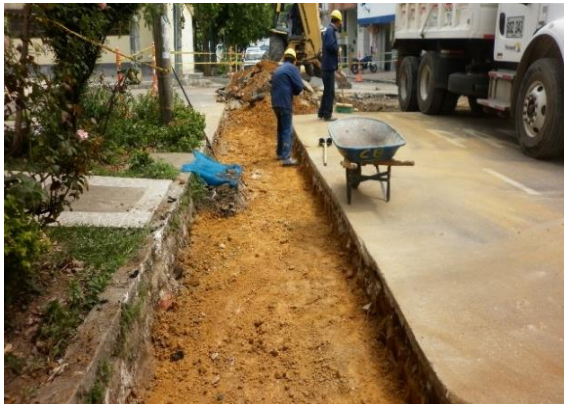
Figura. 25. Replanteo y mejoramiento de la sub rasante.
