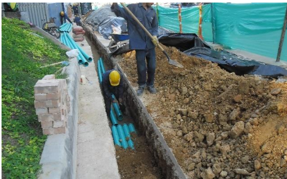
Figura. 4 Suministro e instalación de 1 ducto PVC TDP D=4" andén o calzada colocados en cantidad indicada por el administrador del contrato.
