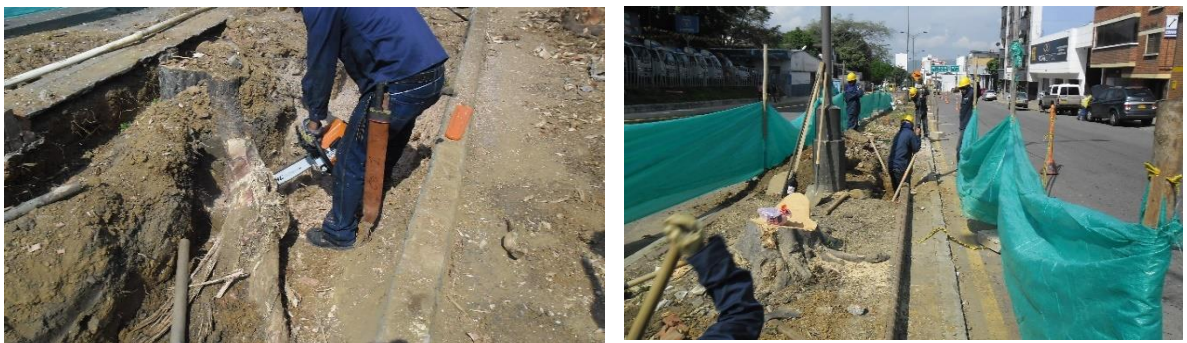
Figura 9. Tala de árboles excavación manual y Malla de Cerramiento.
