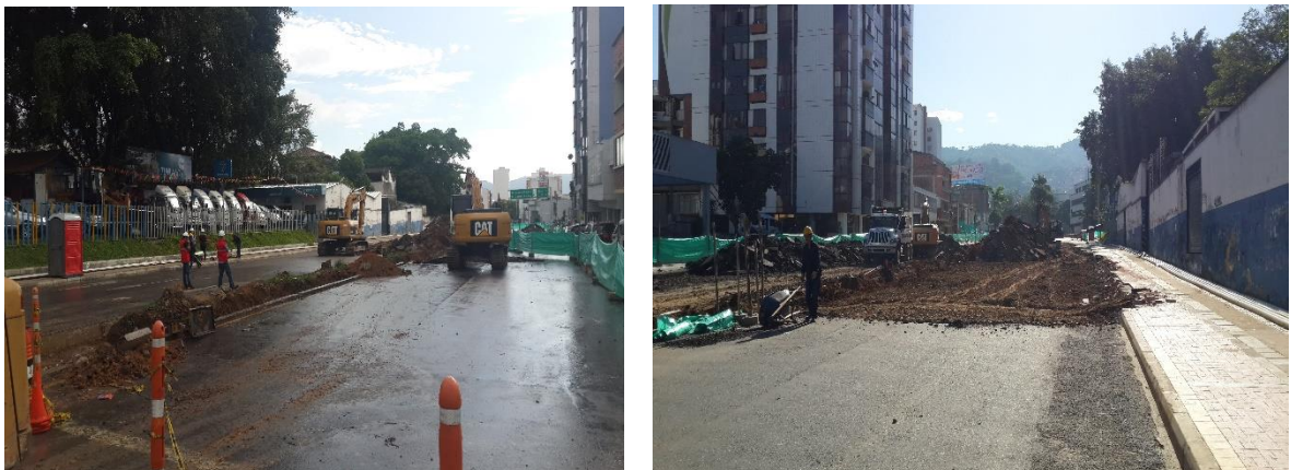
Figura 34. Demolición excavación y retiro de material común.
