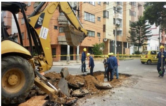
Figura. 25. Replanteo y mejoramiento de la sub rasante.
