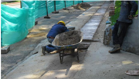
Figura 6. Concreto f'c = 17,50 Mpa para andenes
