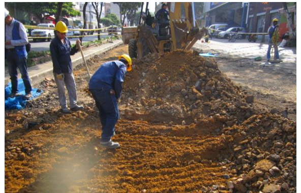
Figura 30. Instalación, replanteo y compactación de base granular.
