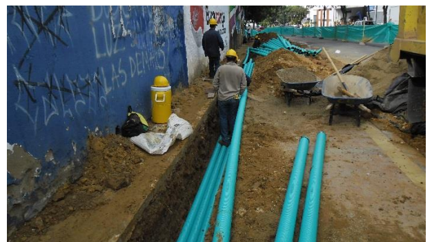
Figura. 4 Suministro e instalación de 1 ducto PVC TDP D=4" andén o calzada colocados en cantidad indicada por el administrador del contrato.
