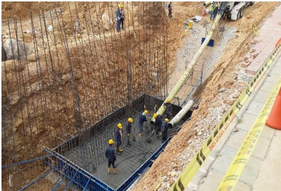
Figura 40. Vaciado y nivelación del concreto en zapatas.
