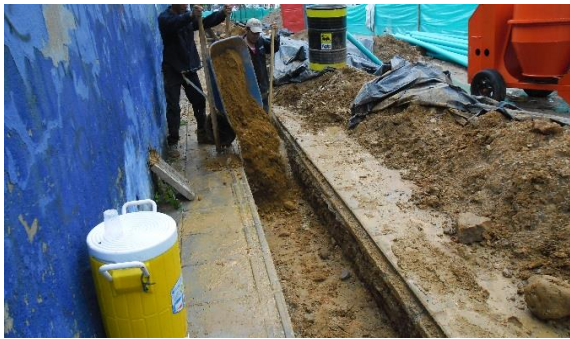
Figura 6. Concreto f'c = 17,50 Mpa para andenes
