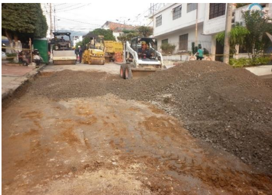
Figura 30. Instalación, replanteo y compactación de base granular.
