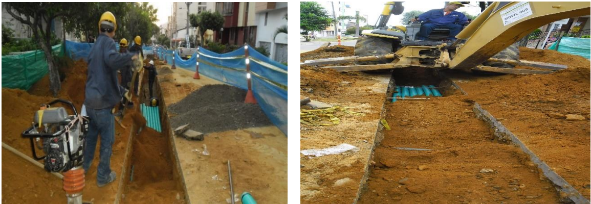
Figura 17. Relleno con material seleccionado.
