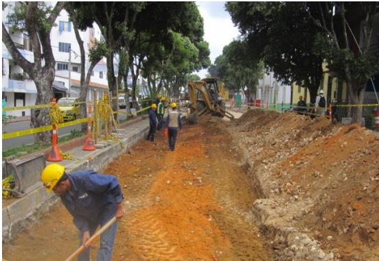
Figura 30. Instalación, replanteo y compactación de base granular.
