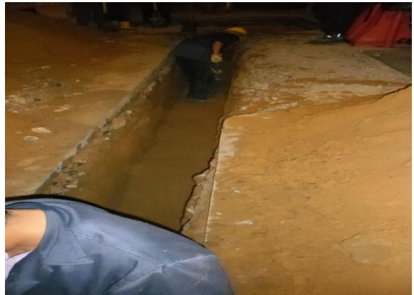
Figura 16. Suministro, conformación de relleno en arena para cimentación de tubería, Suministro e instalación de ducto PVC TDP D=4 colocados en cantidad indicada por el administrador del contrato. .
