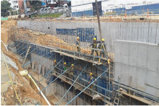
Figura 44. Desencofrado y curado del concreto.
