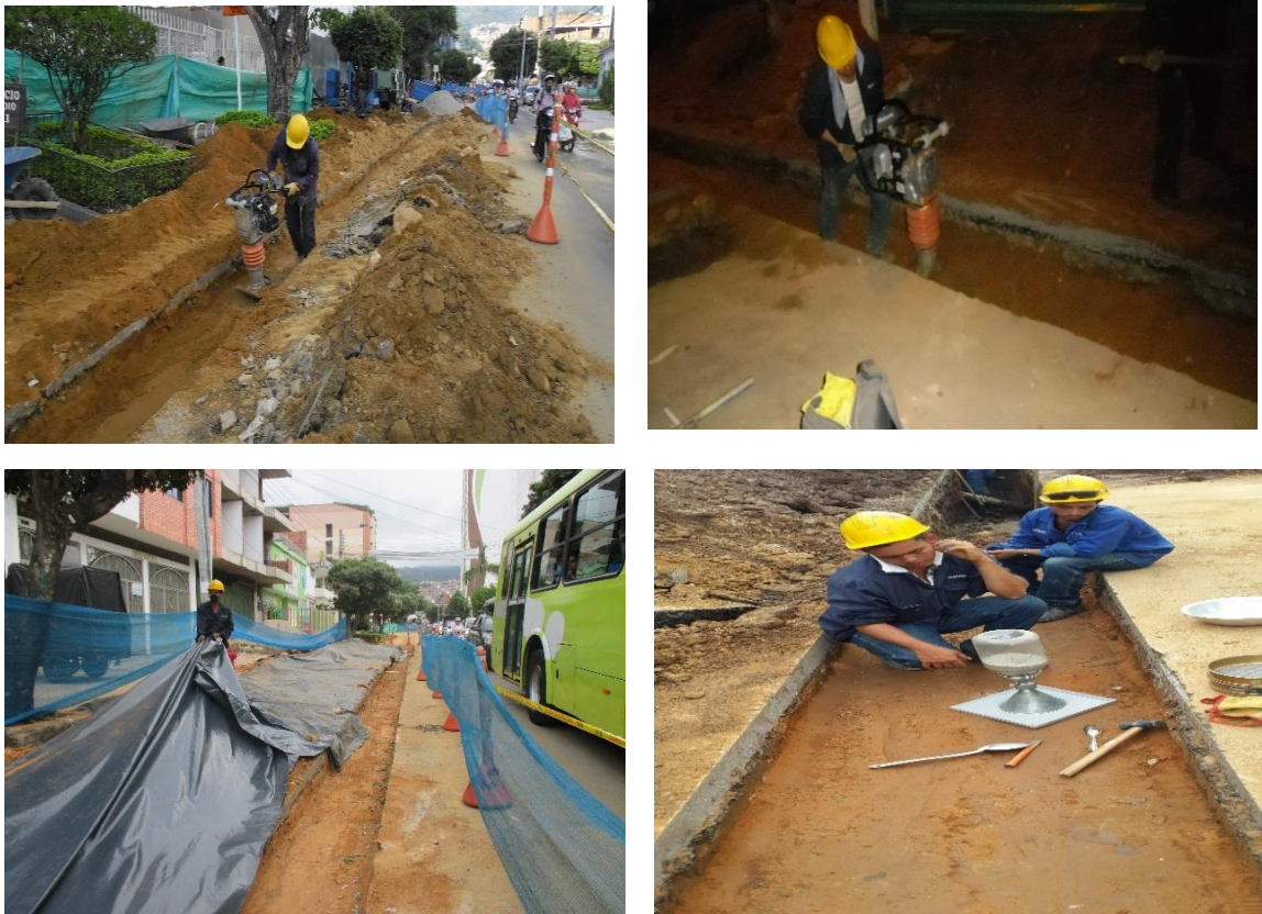
Figura 19 Compactación de base granular.
