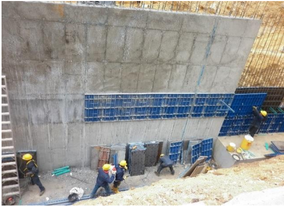
Figura 44. Desencofrado y curado del concreto.
