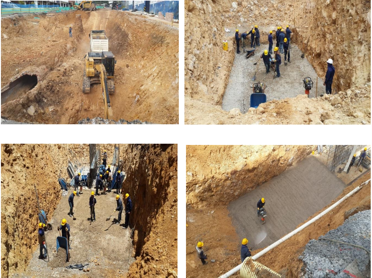
Figura 35. Instalación, replanteo y compactación de base granular
