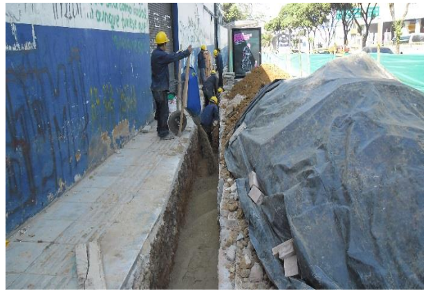
Figura. 4 Suministro e instalación de 1 ducto PVC TDP D=4" andén o calzada colocados en cantidad indicada por el administrador del contrato.
