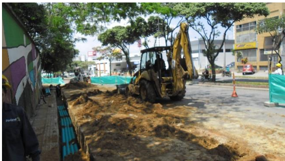
Figura 8. Cargue y transporte a escombrera (Incluye disposición final).
