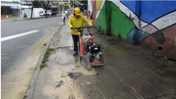
Figura 1. Demolición andenes y separadores existentes.
