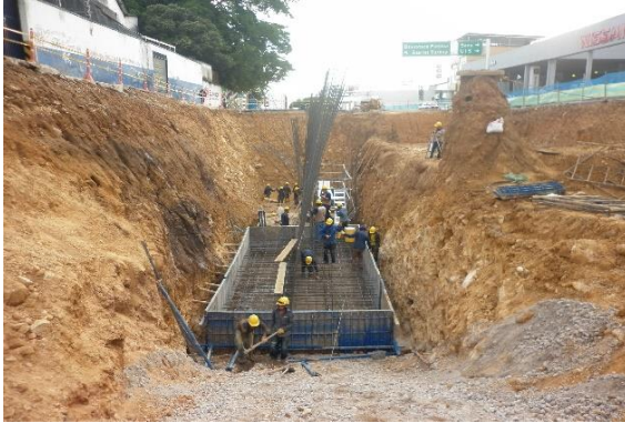
Figura 38. Encofrado con tablero metálico para zapata.
