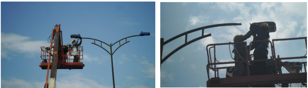
Figura 11. Retiro transporte y entrega en bodega del municipio de red subterránea de baja tensión en cualquier configuración y calibre.
