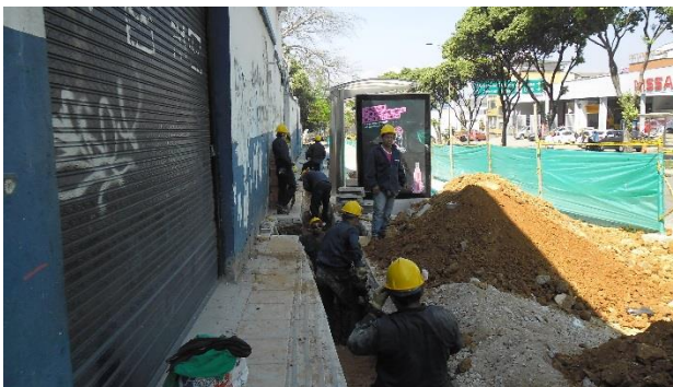
Figura 2. Excavación manual y Malla de Cerramiento
