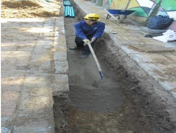
Figura. 4 Suministro e instalación de 1 ducto PVC TDP D=4" andén o calzada colocados en cantidad indicada por el administrador del contrato.
