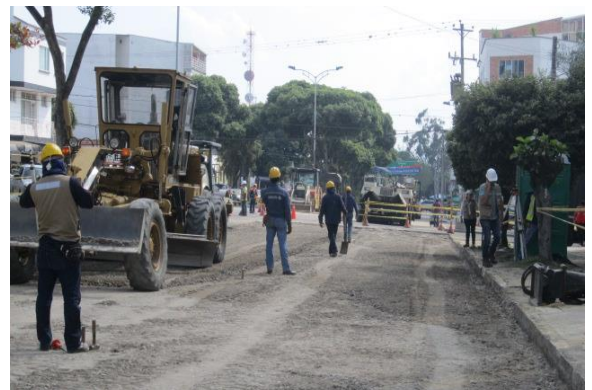
Figura 30. Instalación, replanteo y compactación de base granular.
