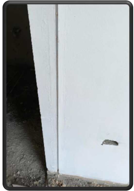
Ilustración 14-Mal postura de las dilataciones de pvc
