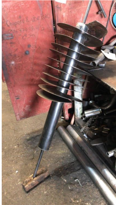
Ilustración 36. Instalación de las aspas del tornillo.
