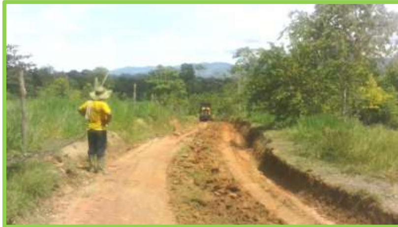
Figura 13. Conformación de terraplén.
