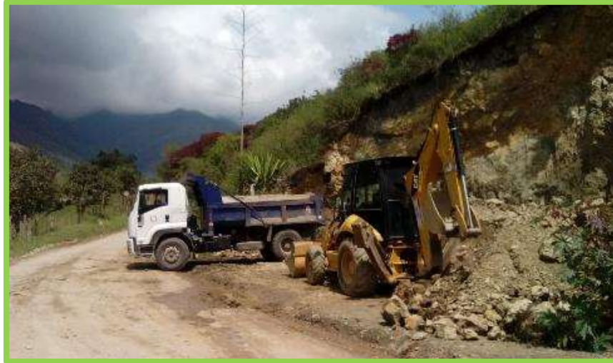
Figura 12. Cargue de material con retroexcavadora.
