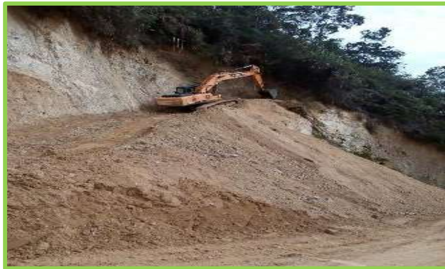
Figura 10. Corte en conglomerado a máquina.
