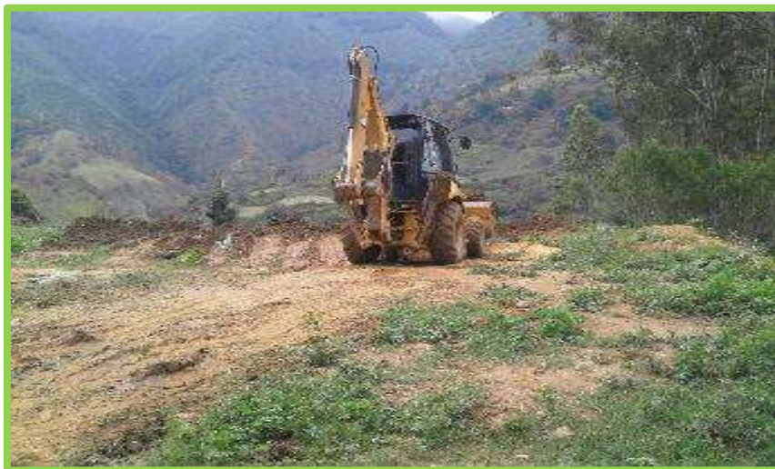
Figura 11. Retiro de sobrantes a máquina.
