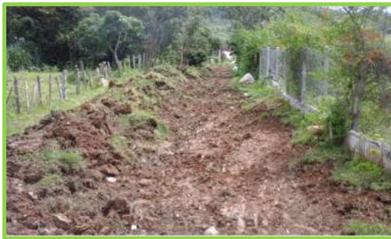
Figura 18. Reconformación de la banca, cueteo y compactación.
