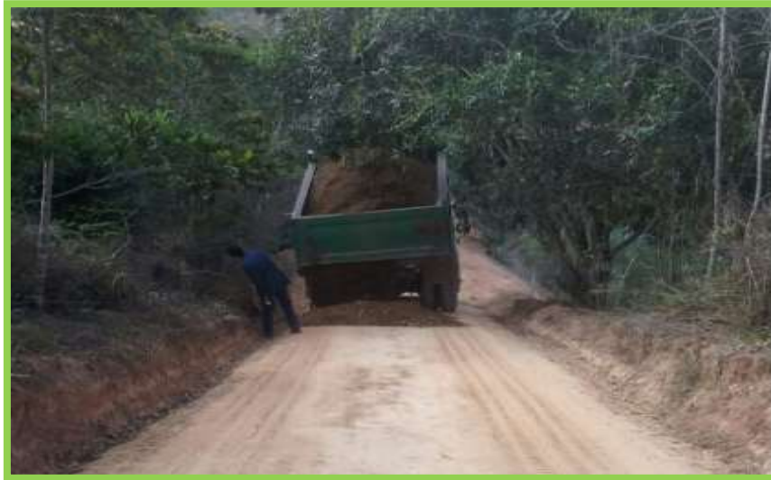
Figura 20. Suministro e instalación de material para afirmado.
