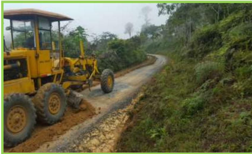
Figura 19. Aplicación y compactación de material para afirmado.
