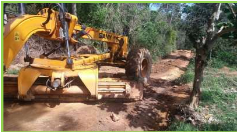
Figura 15. Perfilado.
