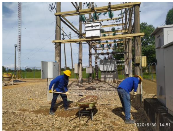
Ilustración 29 Instalación gravilla S/E Santa Catalina
