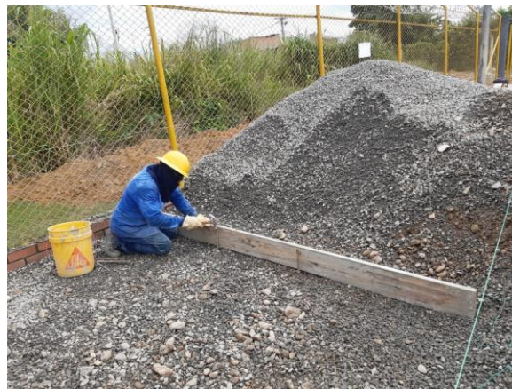
Ilustración 35 Suministro e Instalación de Gravilla S/E San Martin
