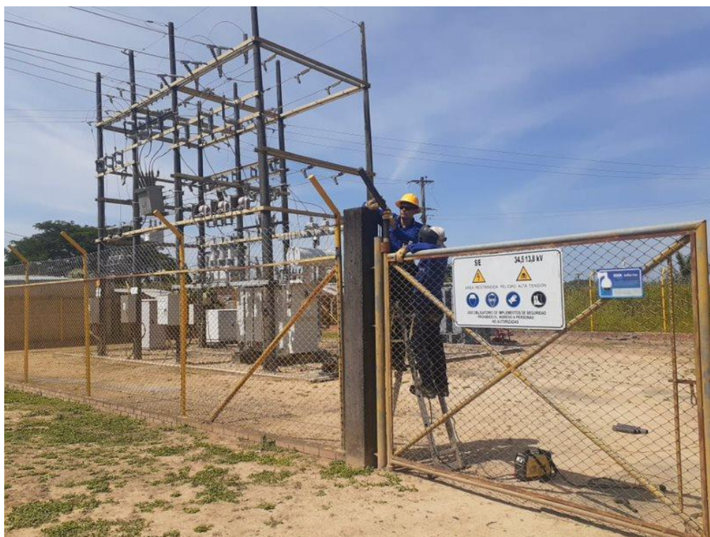
Ilustración 32 Instalación de Concertina S/E San Martín
