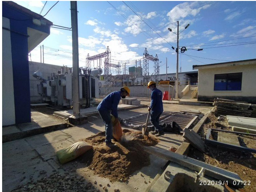
Ilustración 36 Preparación Mortero de nivelación S/E Principal
