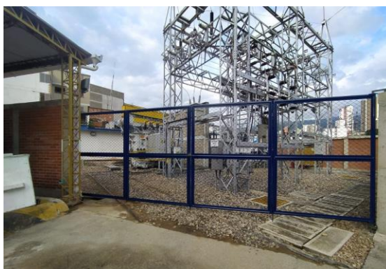
Ilustración 26 Muro en Mampostería S/E Sur
