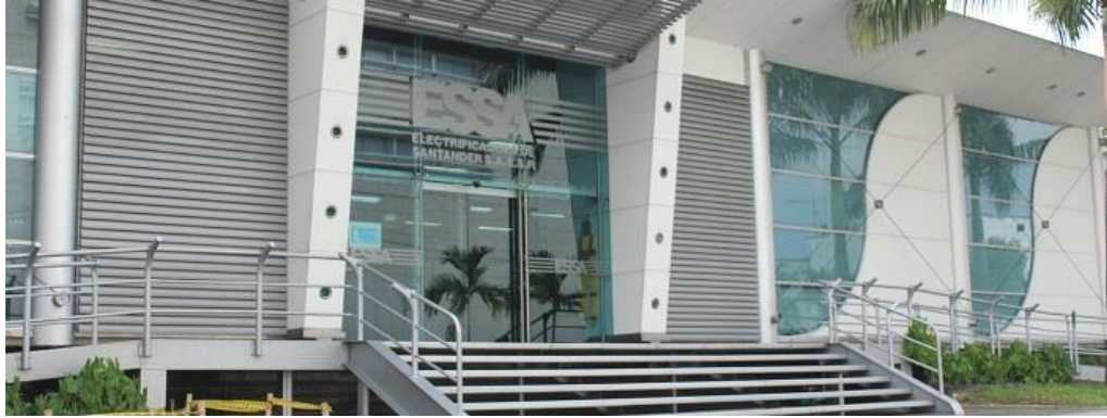
Ilustración 2 Sede Principal de la Electrificadora de Santander S.A. E.S.P.
