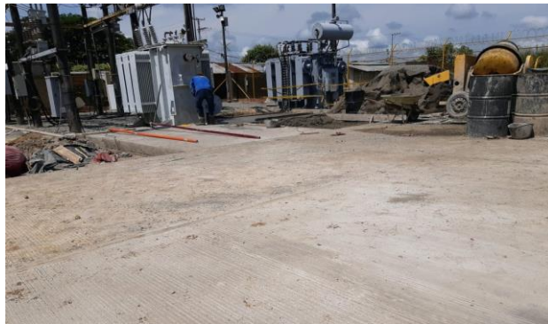
Ilustración 34 lozas de concreto y trabajo en foso de transformador S/E San Martin
