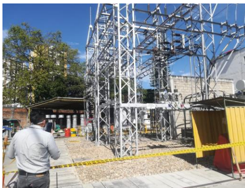
Ilustración 25 Zona para muro S/E Sur
