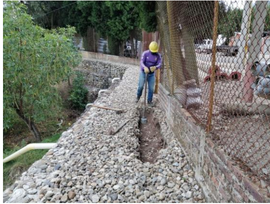
Ilustración 21 Construcción muro de contención, S/E García Rovira
