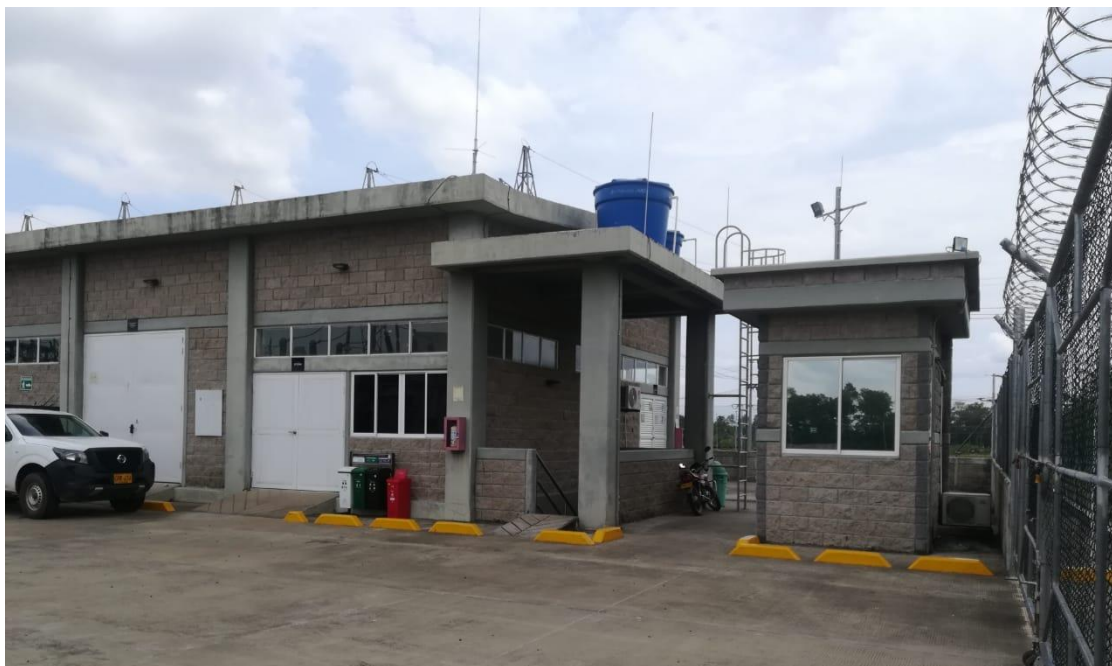
Ilustración 17 Garita S/E Córdor
