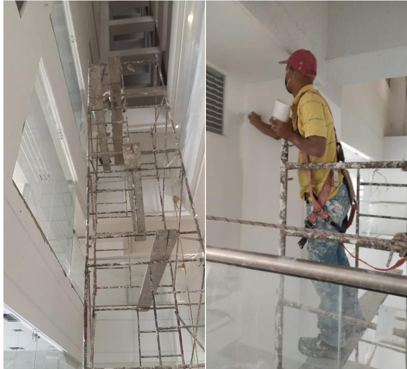
Imagen 19. Personal laborando en andamio
