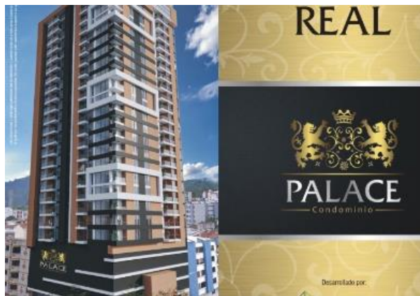
Imagen 11 Palace Condominio Fuente Constructora Innova
