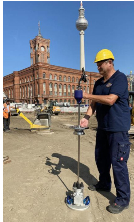
Ilustración 7. Deflectómetro de impacto liviano LWD
