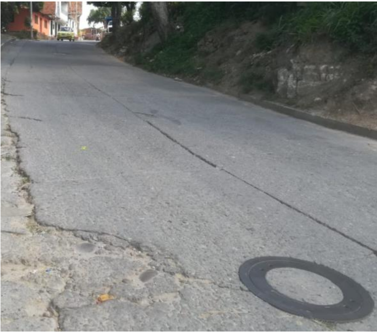
Ilustración 51: Toma de registro de válvulas existentes
