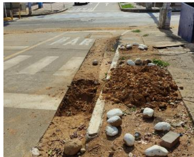
Ilustración 6: Apertura de apiques
