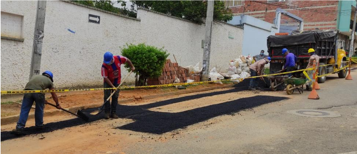
Ilustración 11: Reconstrucción de pavimento asfaltico MDC – 19
