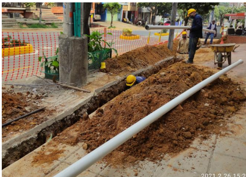
Ilustración 22: Instalación de tubería de 3"
