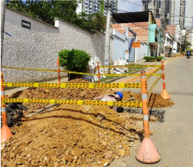
Ilustración 10: Excavación en tierra y conglomerado
