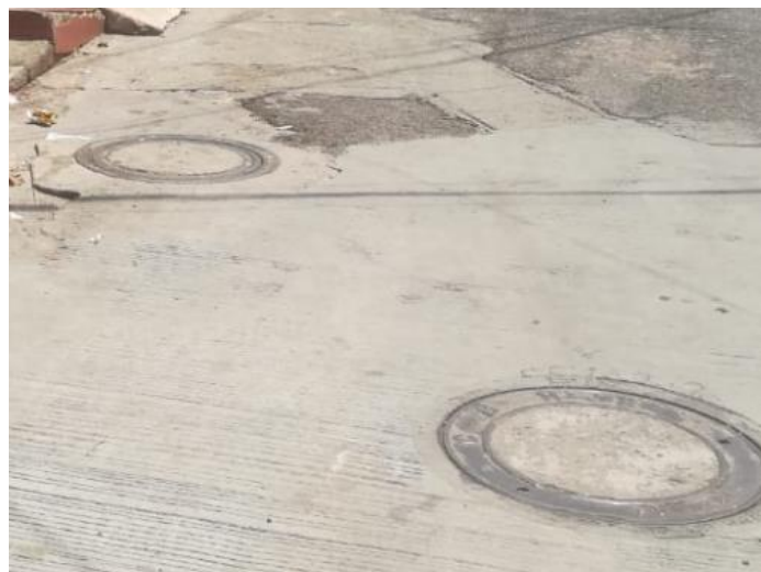
Ilustración 69: Toma de datos - Válvulas existentes
