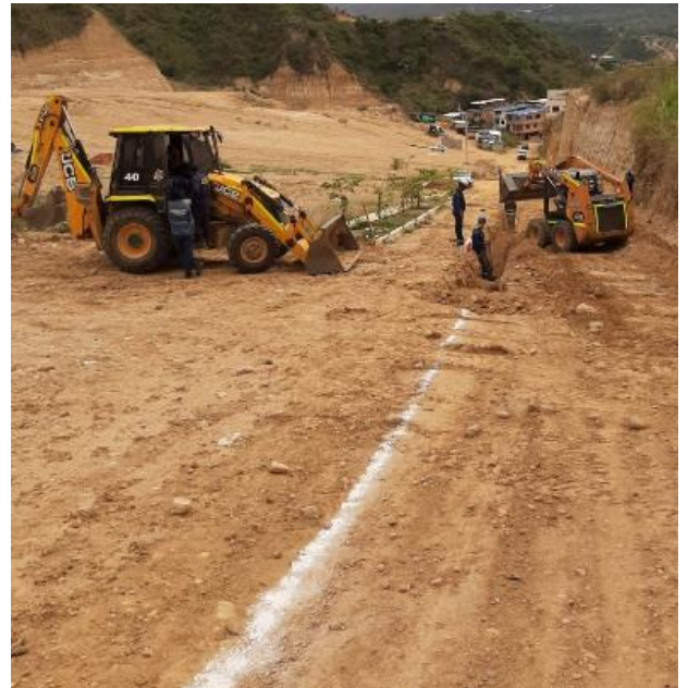
Ilustración 43: Localización de tuberías
