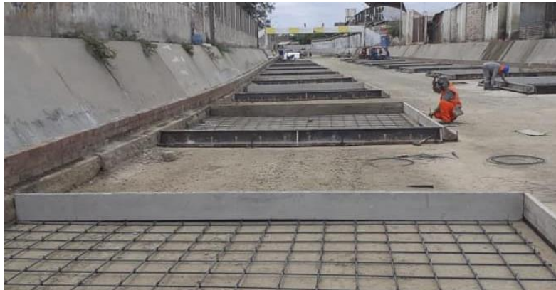
Ilustración 79: Mallas electrosoldadas para pavimento hidráulico en losas.
