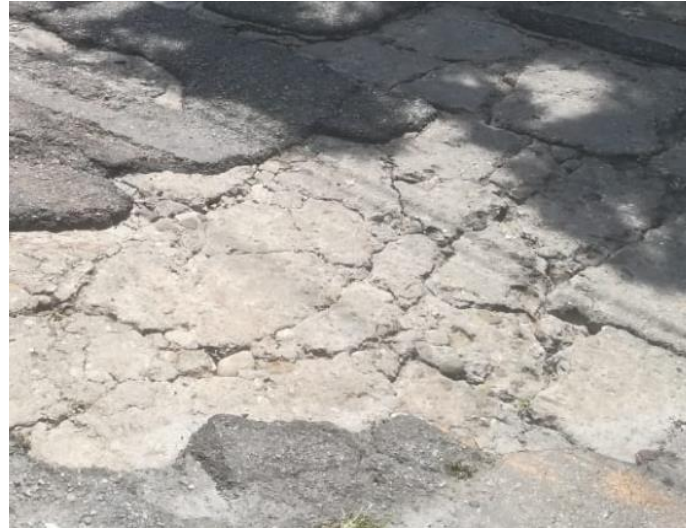
Ilustración 67: Identificación del estado de la Vía
