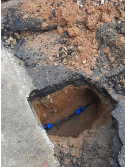
Ilustración 20: Apique para detección de estructuras existentes
