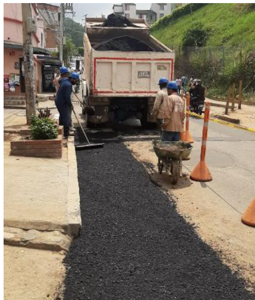
Ilustración 12: Reconstrucción pavimento asfaltico
