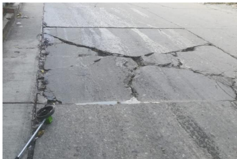
Ilustración 48: Identificación de tipo de pavimento (Pavimento Hidráulico - Losas de hormigón) – Al igual que saber el estado de la vía.
