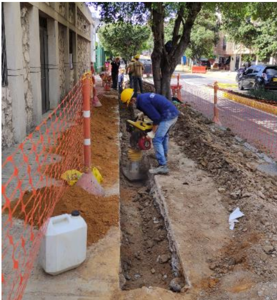
Ilustración 18: Base granular suministro y compactación
