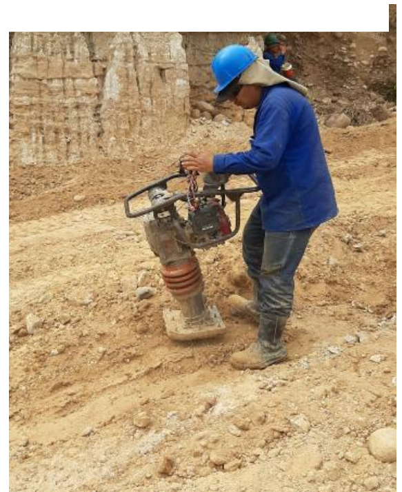
Ilustración 45: Rellenos en materia común y compactados
