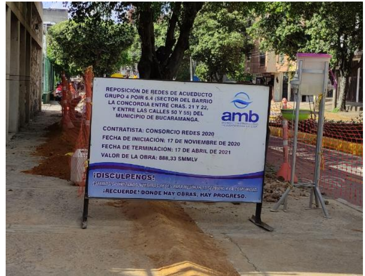
Ilustración 19: Señalización de obra
