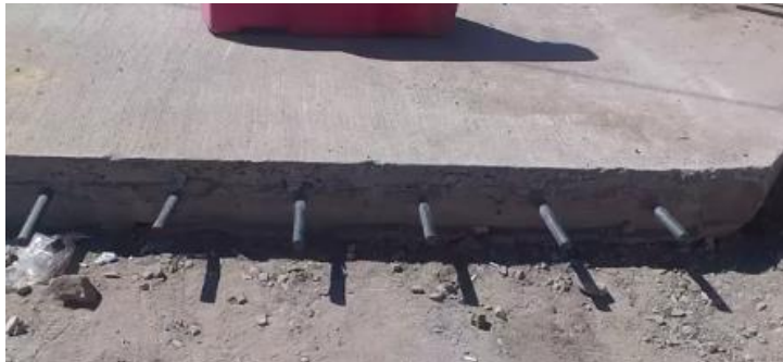
Ilustración 78: Acero de refuerzo para losas de concreto
