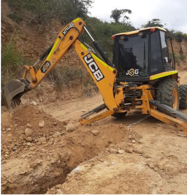
Ilustración 42: Excavación en tierra y conglomerado
