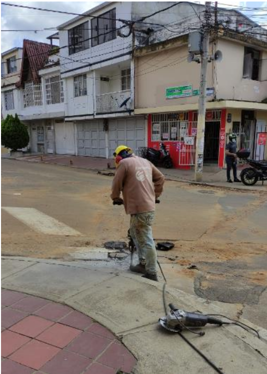
Ilustración 3: Rotura de pavimentos con taladro
