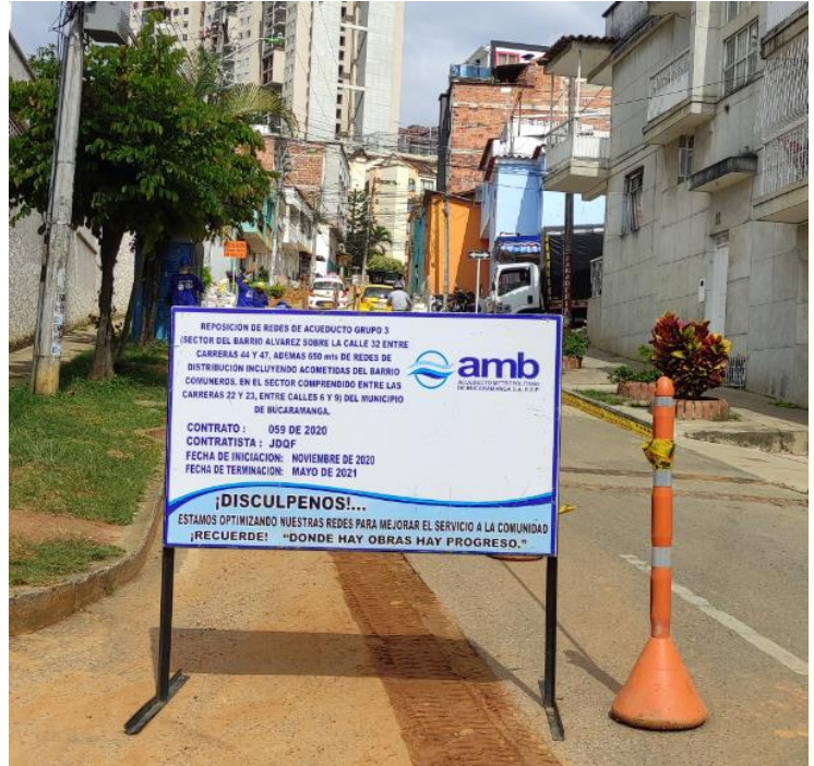
Ilustración 4: Señalización valla aviso de obra
