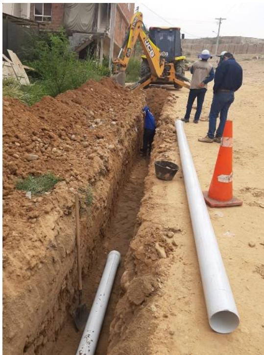
Ilustración 44: Instalación de tuberías
