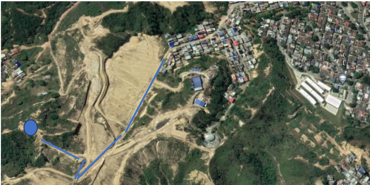
Ilustración 41: Ubicación de la obra de instalación de redes y construcción de tanque de almacenamiento.
