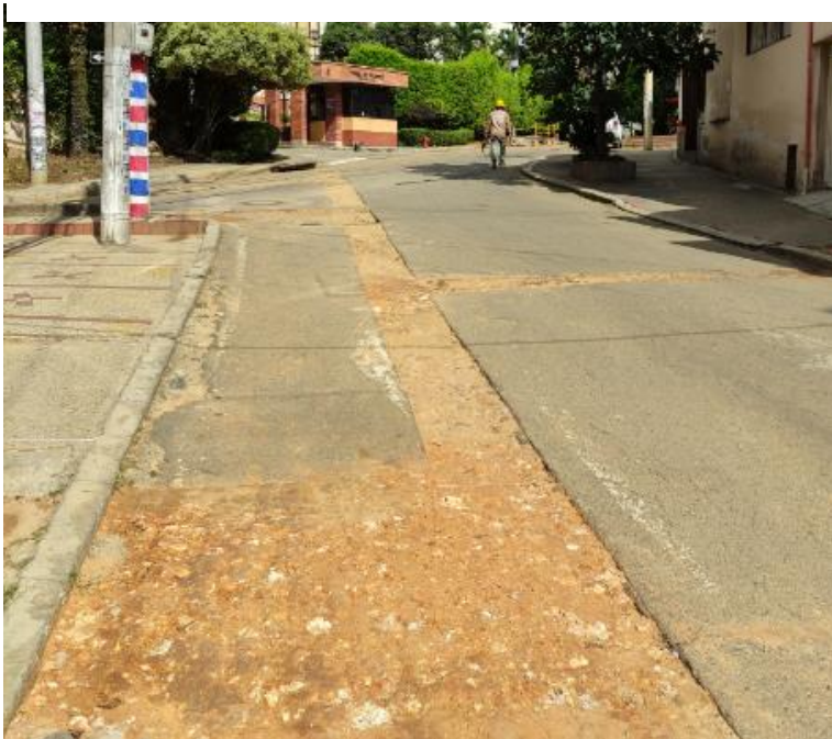
Ilustración 7: Suministro y compactación de capa base
