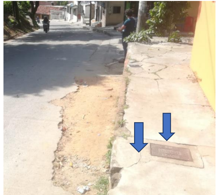
Ilustración 50: Registro de acometidas domiciliarias.
