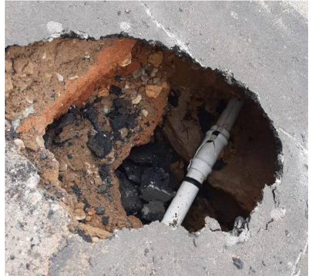
Ilustración 9: Apique para detección de tuberías o estructuras dañadas
