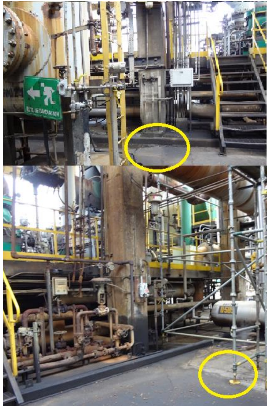
Imagen 5. Ubicación en sitio de las zapatas de la estructura metálica.
