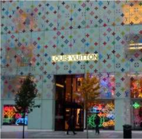
Imagen 27: Fachada tienda Louis Vuitton Nueva York.
