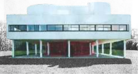
Imagen 53: Fachada Villa Savoye intervenida.
