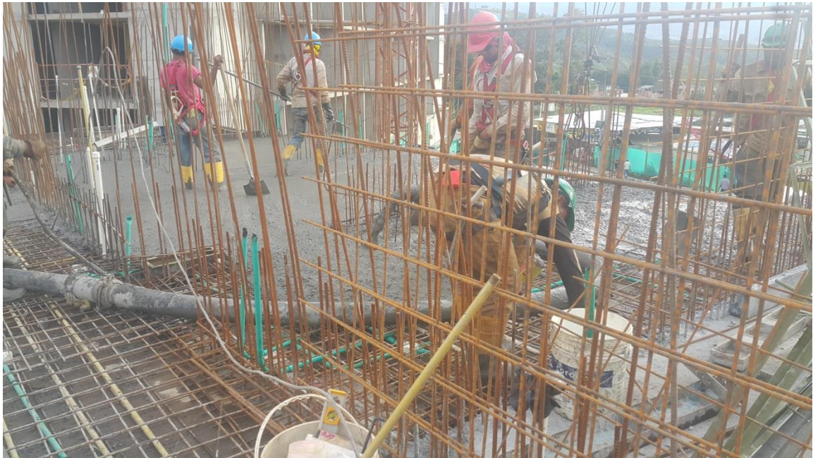
Figura 41. Supervisión fundida de placa entrepiso torre 2.
