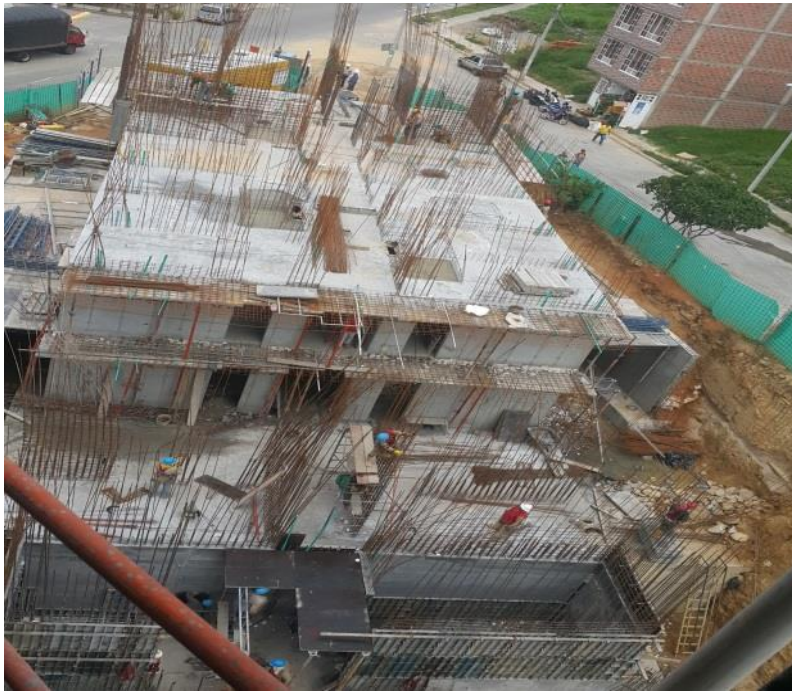
Figura 29. Avance torre 2 a 25 de Octubre 2016.
