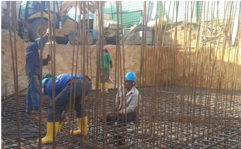
Figura 34. Ubicación de arranques de pantallas.
