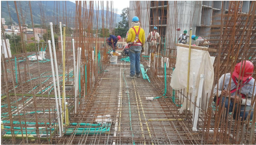
Figura 39. Inspección amarre de hierros en placa.
