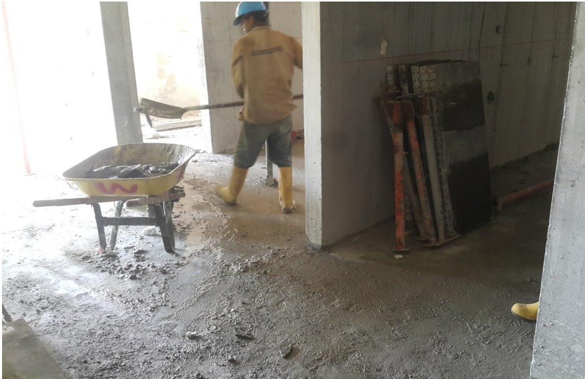
Figura 48. Adecuación y aseo de espacios.
