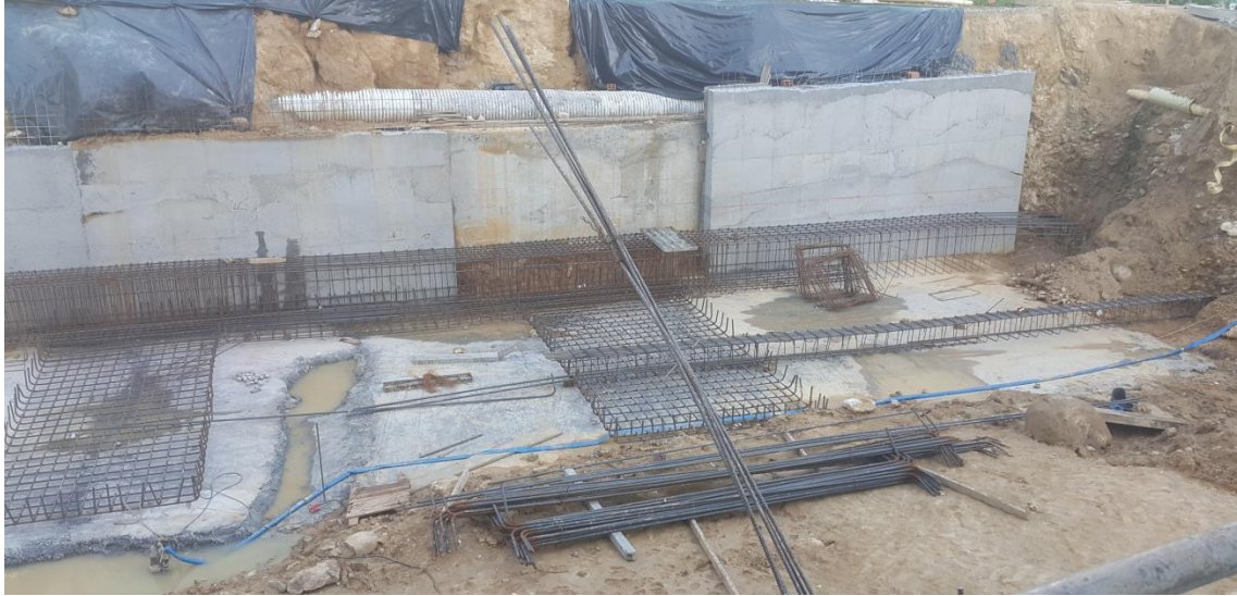
Figura 45. Amarre de hierros vigas y zapatas cimentación parqueaderos.
