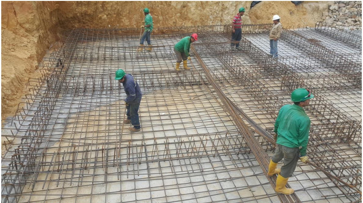
Figura 33. Amarre de hierros placa maciza cimentación torre 2.
