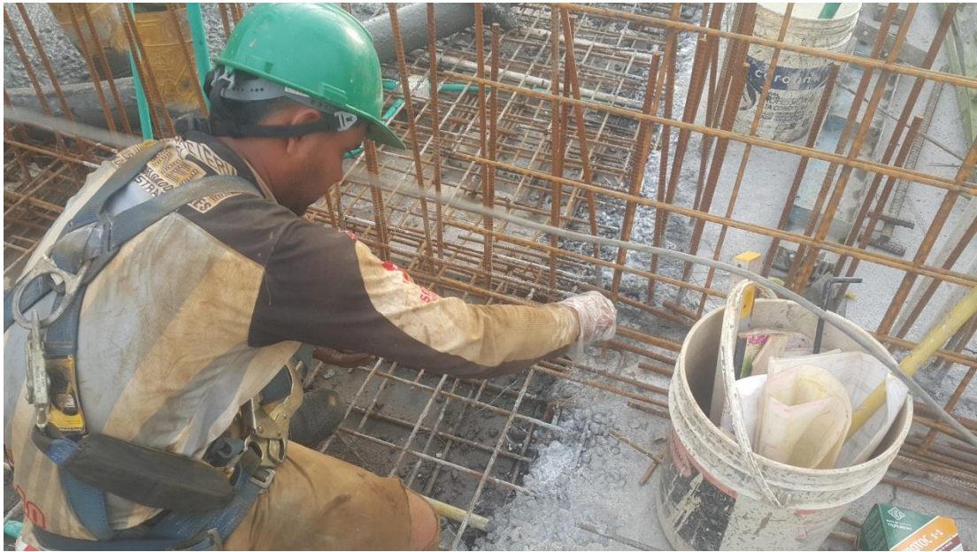
Figura 40. Aplicación de “epotoc” en concreto viejo.
