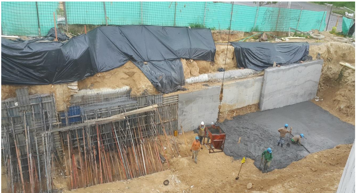
Figura 44. Fundida de solado y submuración costado oriental.
