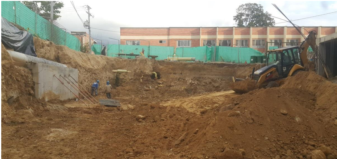
Figura 42. Movimiento final de tierras torre de parqueaderos.
