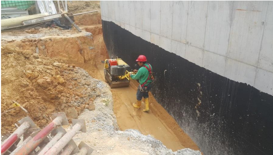
Figura 37. Compactación de tierra torre 2.
