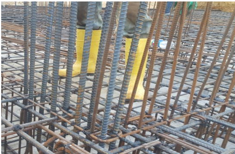
Figura 35. Ubicación de flejes pantallas.
