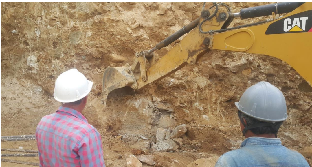
Figura 43. Demolición de piedras con la retroexcavadora.
