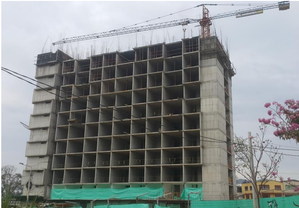
Figura 28. Avance torre 1 a 25 de Octubre 2016.
