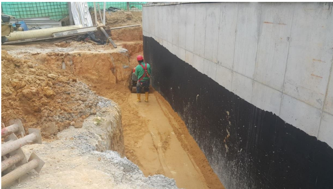
Figura 38. Compactación de tierra torre 2.
