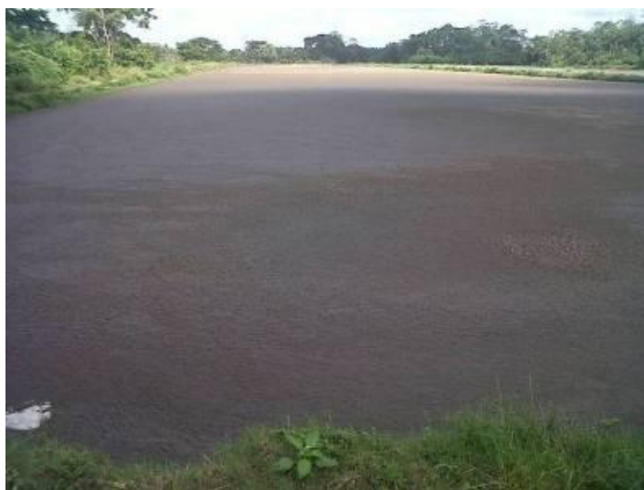
Fotografía 10.Laguna de oxidación anaeróbica.
