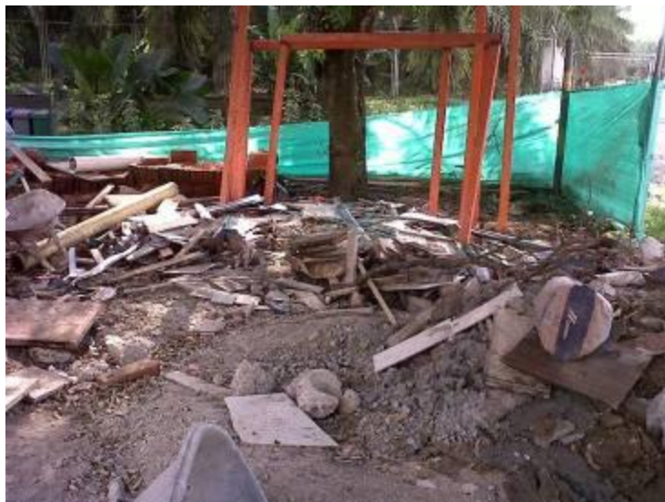
Fotografía 16.Inspección a obras dentro de las instalaciones.
