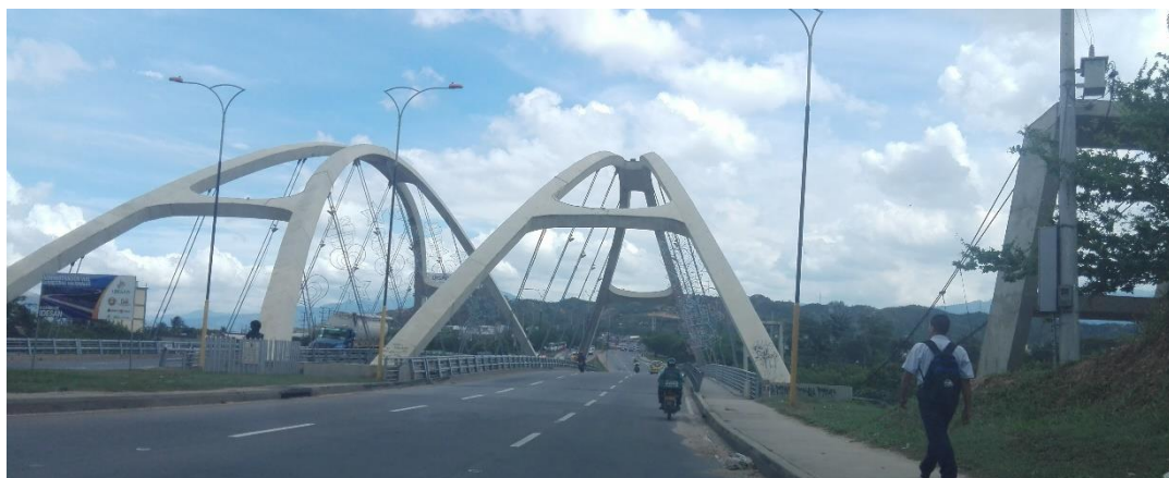
Imagen 48. Seguimiento ICA-OC, Construcción Puente Flandes- Girón
