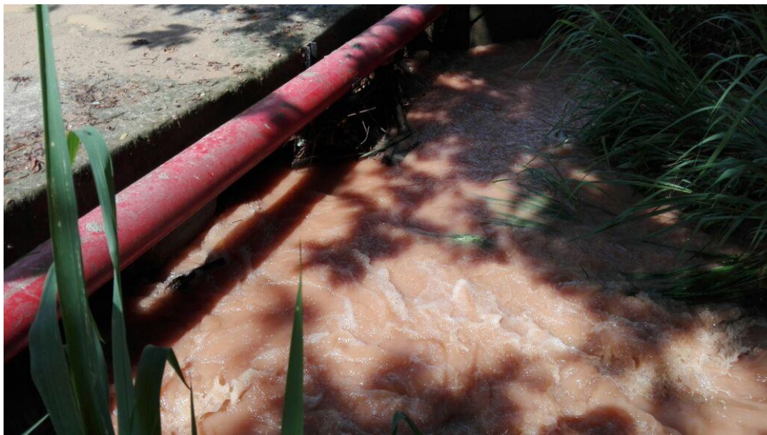
Imagen 57. Seguimiento ICA-OC, Tubería Subfluvial de Gas METROGAS S.A.-Girón
