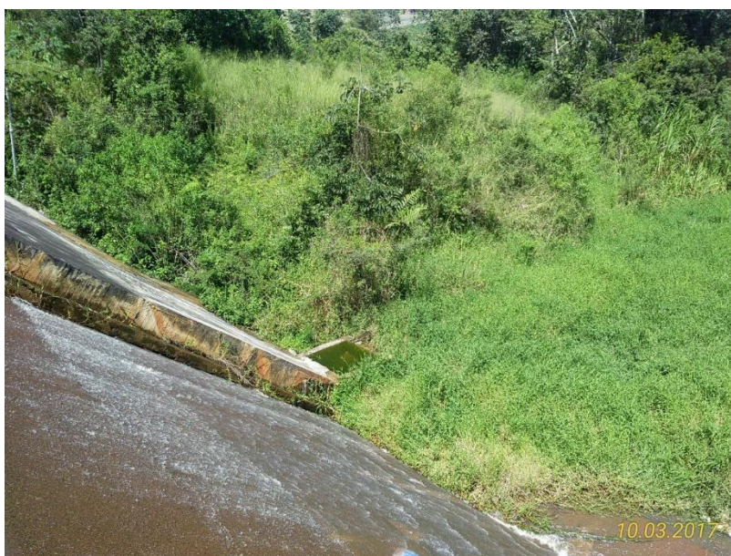
Imagen 38. Control de Obra, RAD CDMB 16407 de 2017
