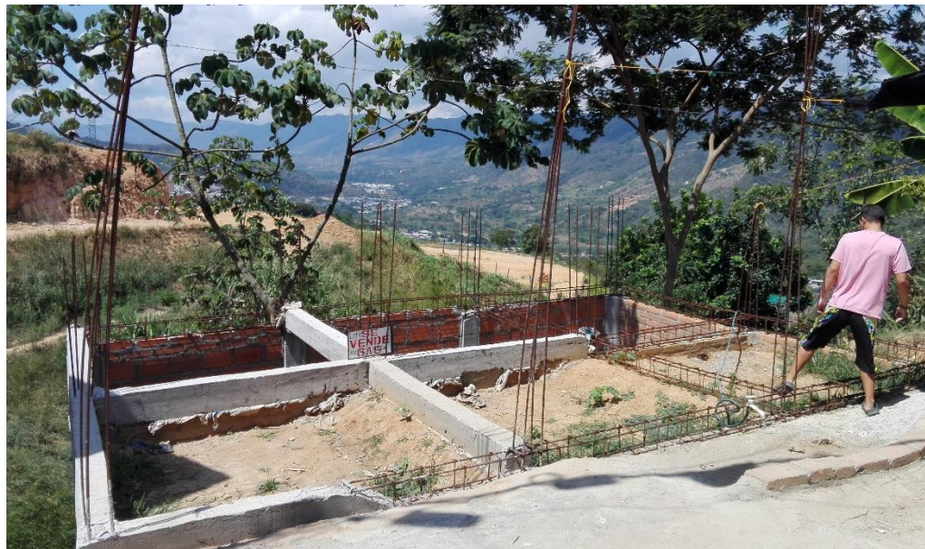
Imagen 28. Control de Obra RAD CDMB 14495 de 2017
