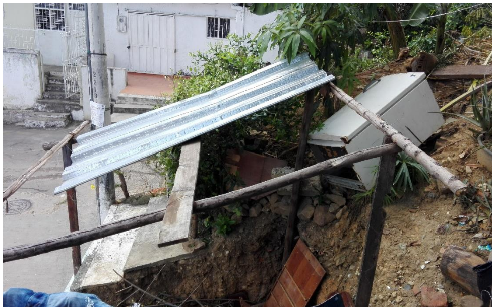
Imagen 32. Control de Obra RAD CDMB 15418 de 2017
