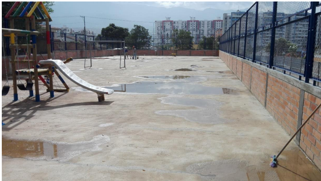
Imagen 13 Control de obra RAD CDMB 14135 de 2017
