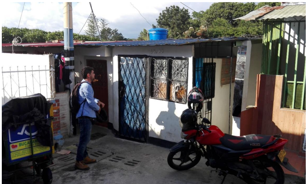
Imagen 34. Control de Obra en zona DRMI RAD CDMB 14710 de 2017
