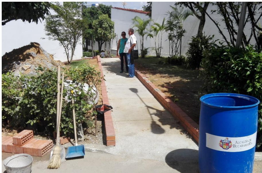
Imagen 42 Control de Obra, RAD CDMB 17344 de 2017
