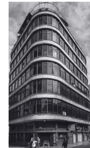
Figura 20. Edificio Álvarez Santamaría. Fotografía tomada de APP.
