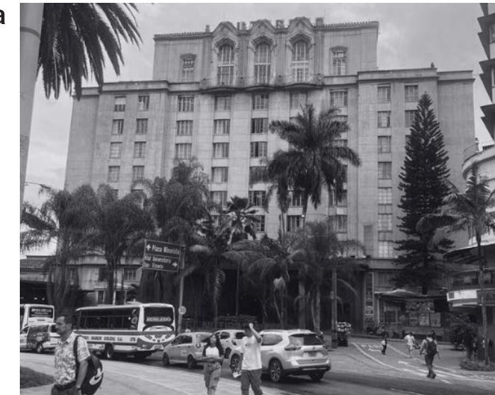
Figura 18. Hotel Nutibara. Fotografía propia.
