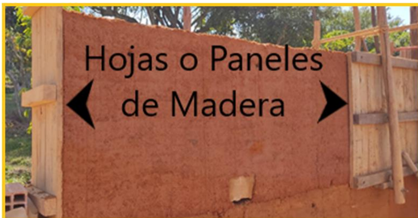
Figura 15. Hojas o Paneles de Madera del Tapial.
