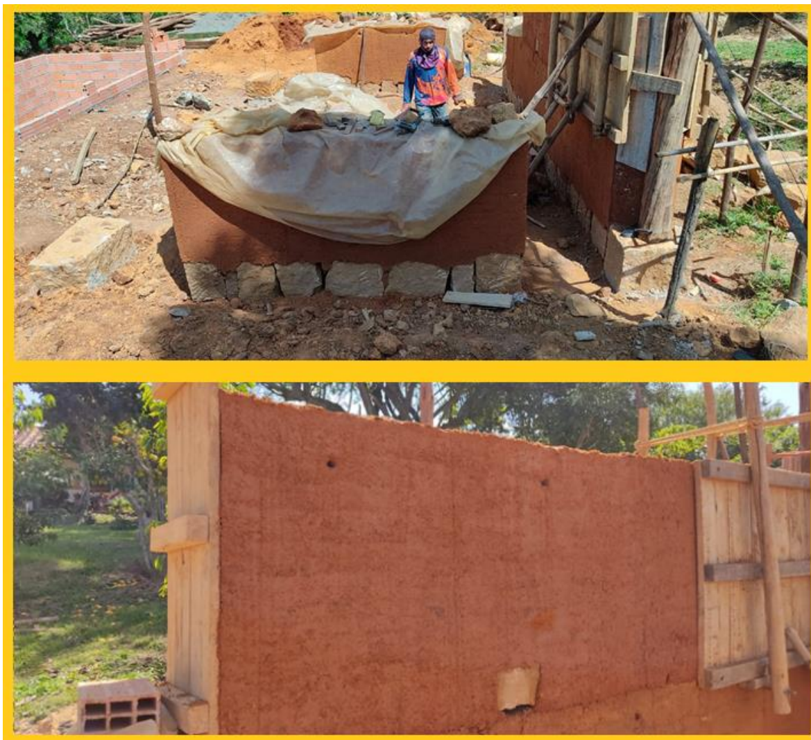
Figura 12. Diseño de muro Técnica Tapia Pisada
