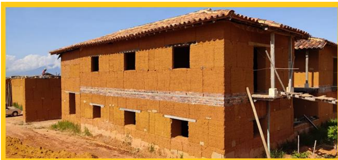
Figura 23. Casa de Dos pisos Construcción Maestro Ivan Ramírez
