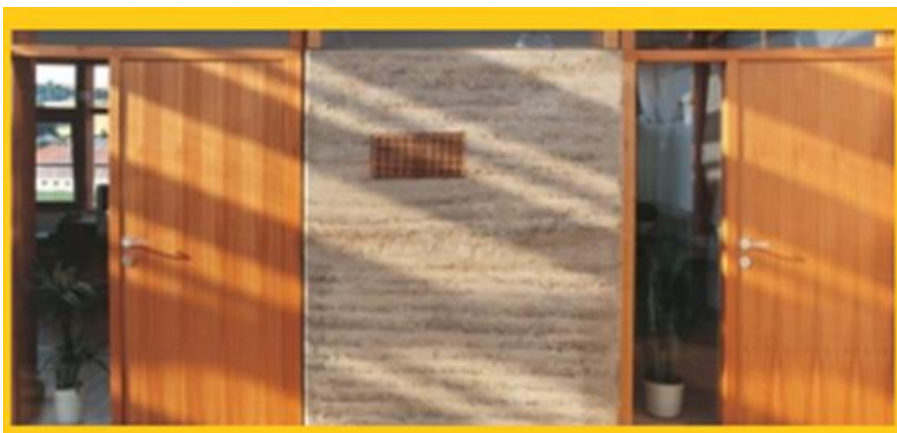
Figura 28. Oficinas imprenta Gugler print&media. Prefabricación muros de Tapia
