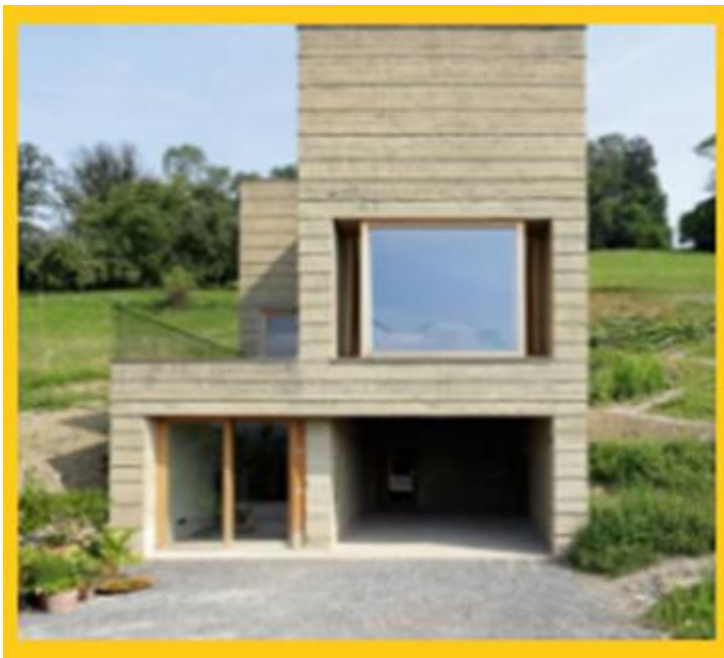
Figura 29. Casa Rauch Austria. Construcción con herramientas mecánicas y neumáticas.
