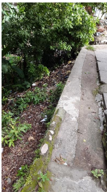
Figura 36. Vista del muro del barrio Buena Vista
