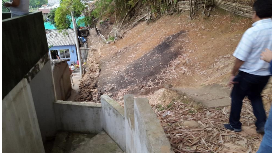
Figura 28. Visita técnica al barrio Los Lagos
