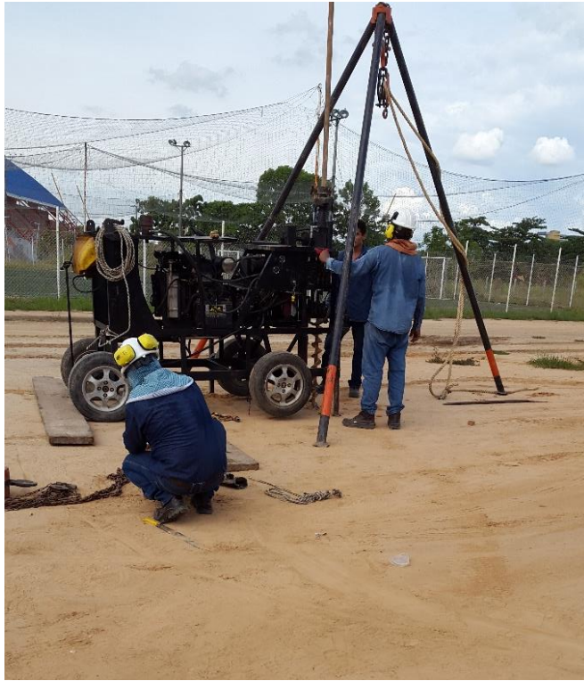
Figura 14. Ensayo de penetración estándar en el lote ubicado detrás del Coliseo Luis F. Castellanos
