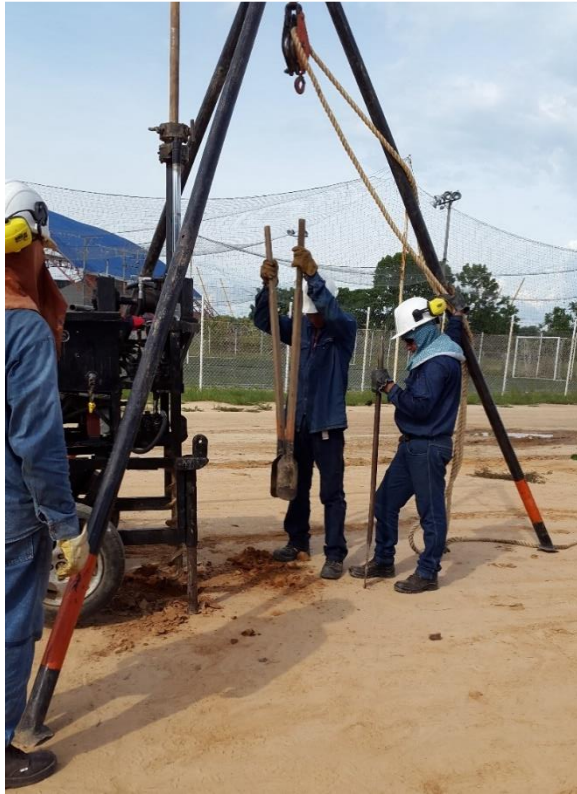
Figura 15. Excavación inicial para remover el relleno antropogénico
