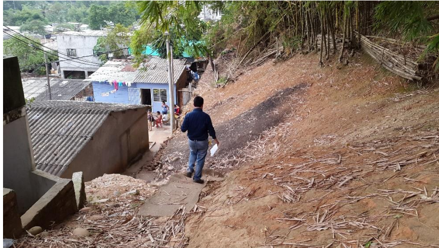
Figura 27. Visita al talud del barrio Los Lagos
