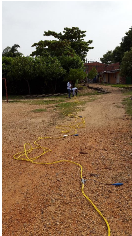
Figura 53. Tendido del cableado a lo largo de la línea
