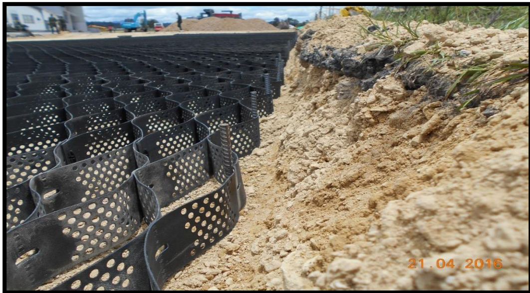
Figura 67. Instalación de geocelda.
