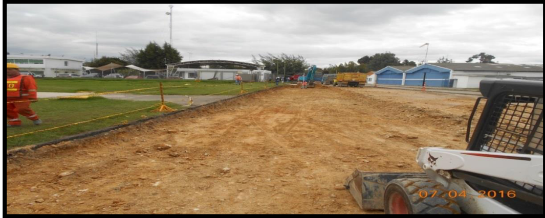
Figura 42. Arreglo de nivelación del terreno natural.
