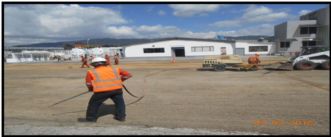
Figura 31. Operador limpiando área fresada con máquina sopladora.
