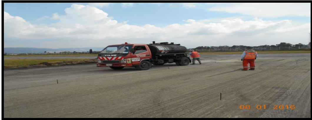
Figura 4. Imprimación de área fresada con el carro irrigador.
