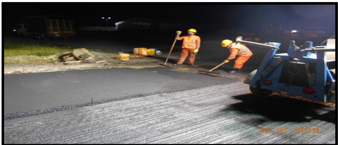
Figura 18. Instalación de la primera carpeta asfáltica.
