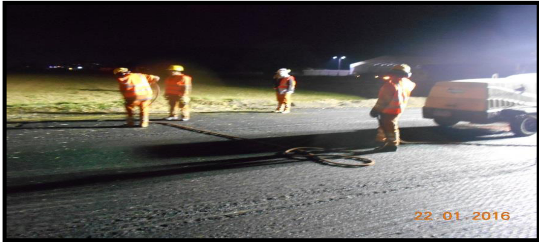
Figura 19. Limpieza calle de rodaje con máquina compresor.
