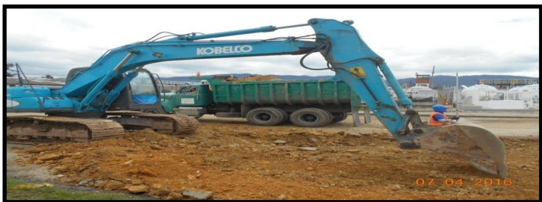
Figura 41. Retroexcavadora excava estructura de área averiada por aguas lluvias.
