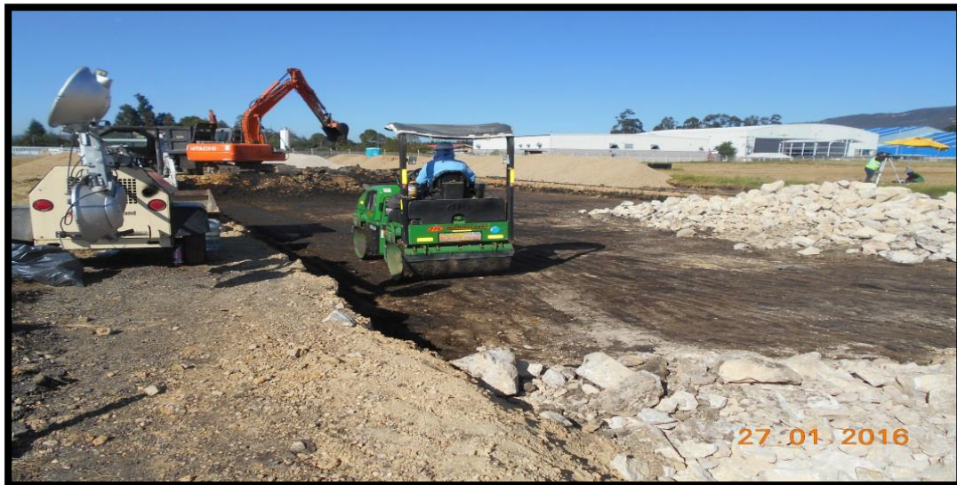
Figura 10. Vibrocompactador de rodillo compacta terreno natural.
