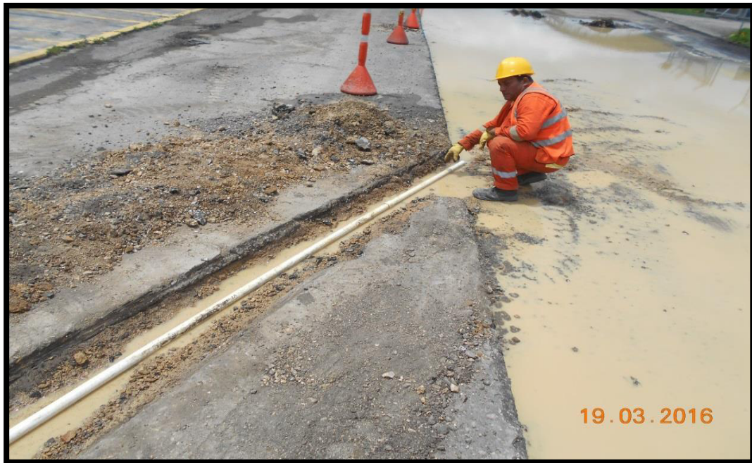
Figura 37. Instalación de tubería en el canal.
