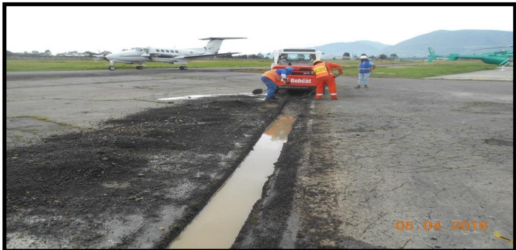
Figura 39. Actividad de fresado en la caja de inspección.
