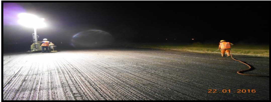
Figura 17. Limpieza de calle de rodaje.
