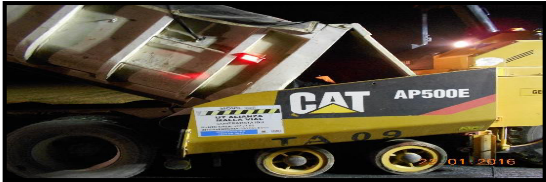
Figura 15. Volqueta insertando material asfáltico sobre la tolva de la finisher.
