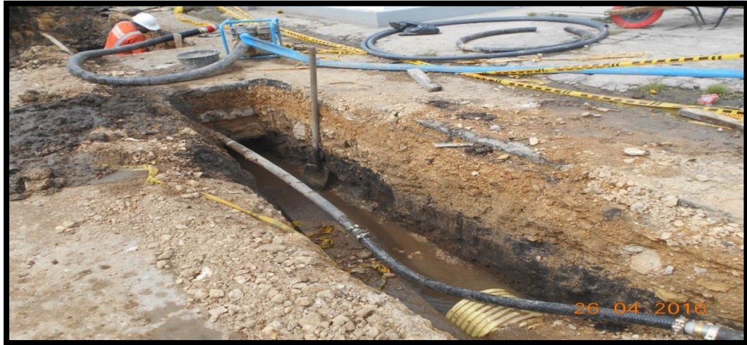
Figura. 69. Instalación de tubería Novafort.
