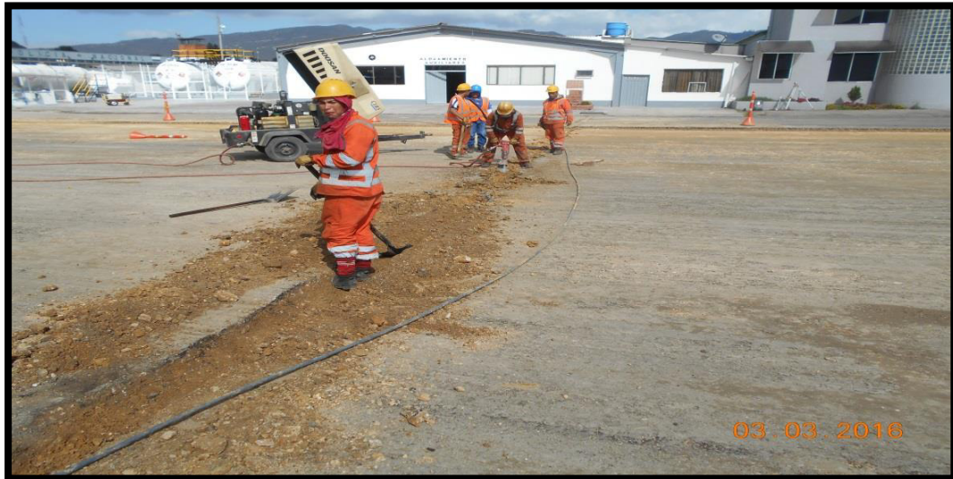
Figura 32. Trabajadores excavando zona donde se averió la tubería.
