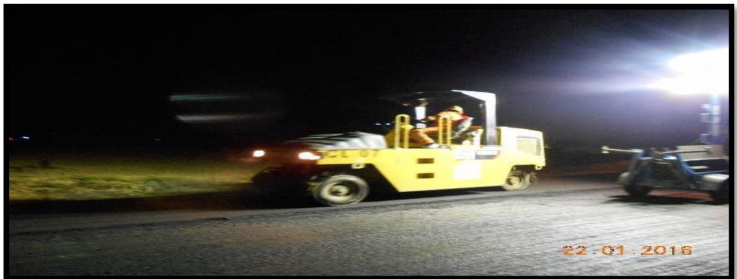
Figura 24. Máquina vibrocompactador hyster compactando la carpeta asfáltica.
