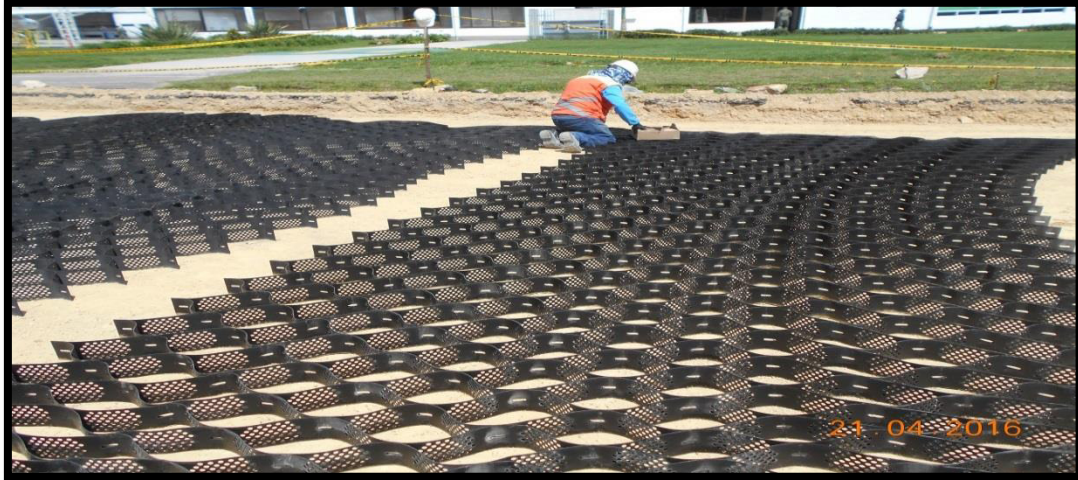
Figura 66. Instalación de geocelda Geoweb.
