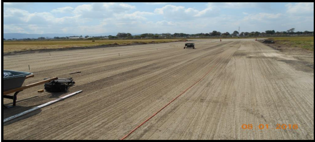
Figura 2. Área de calle de rodaje completamente fresada.
