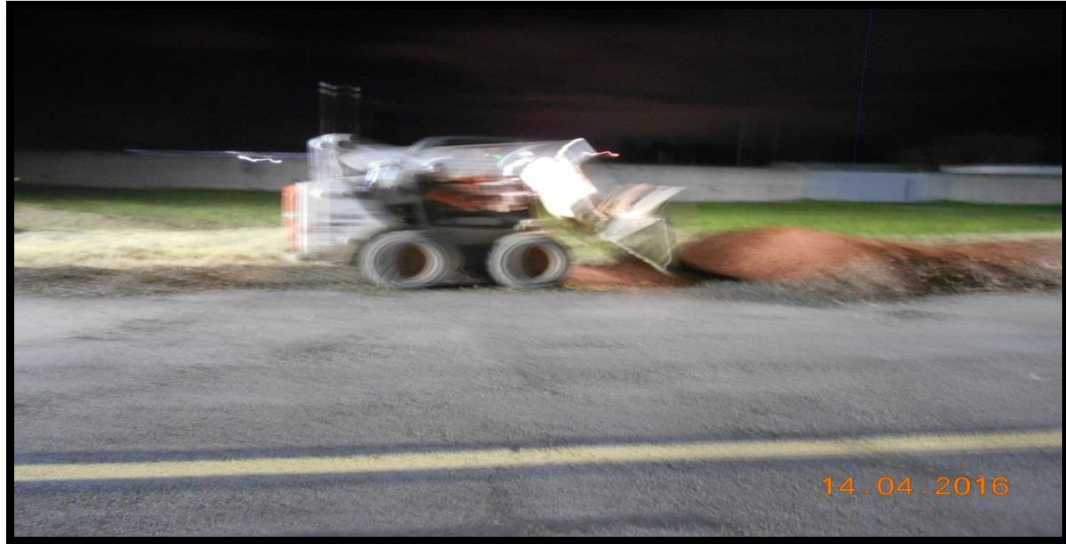
Figura 59. Minicargador extendiendo material fresado sobre las bermas de la paralela.
