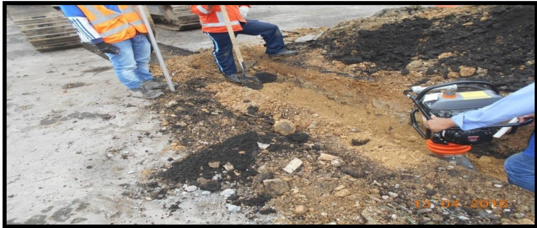
Figura 53. Compactación de la base del canal con el canguro.
