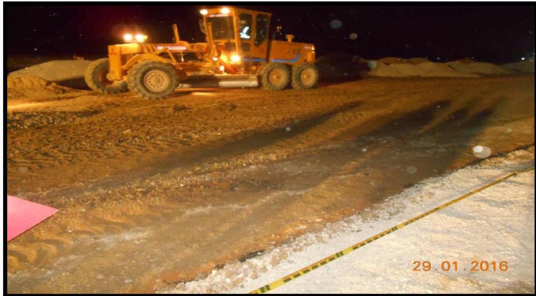
Figura 12. Se extiende material base con máquina motoniveladora.
