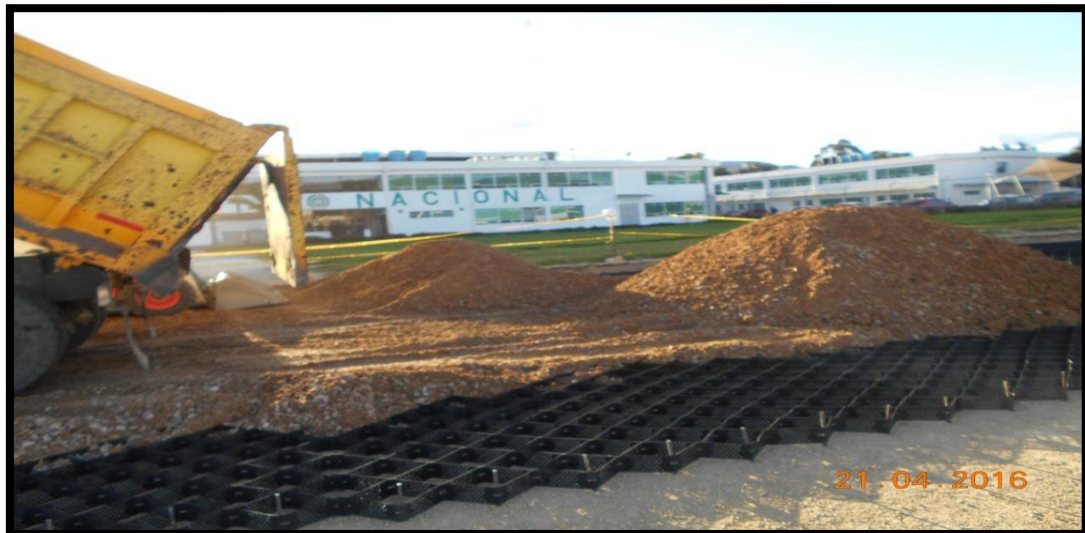
Figura 68. Extendida de material base.
