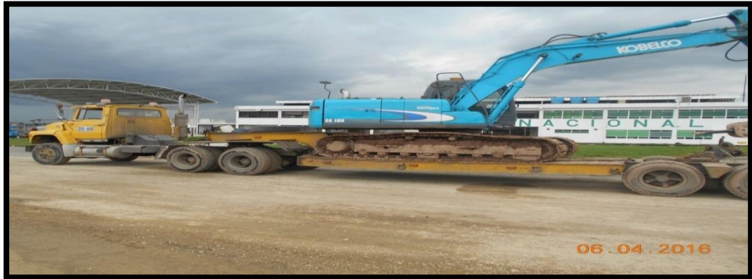
Figura 40. Llegada de máquina retroexcavadora al aeropuerto.
