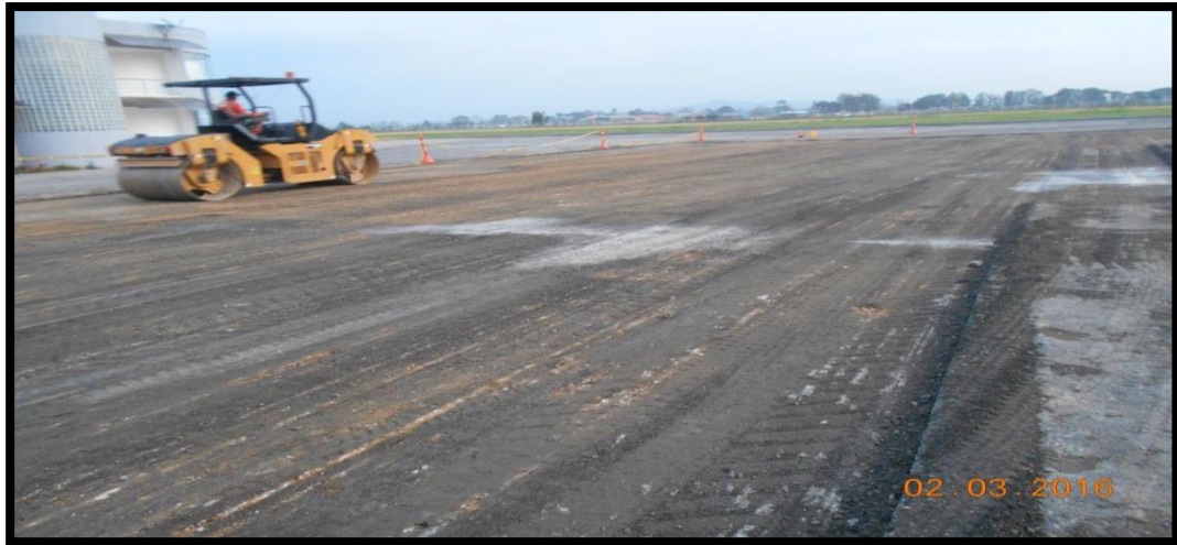
Figura 30. Compactación sobre el área fresada.
