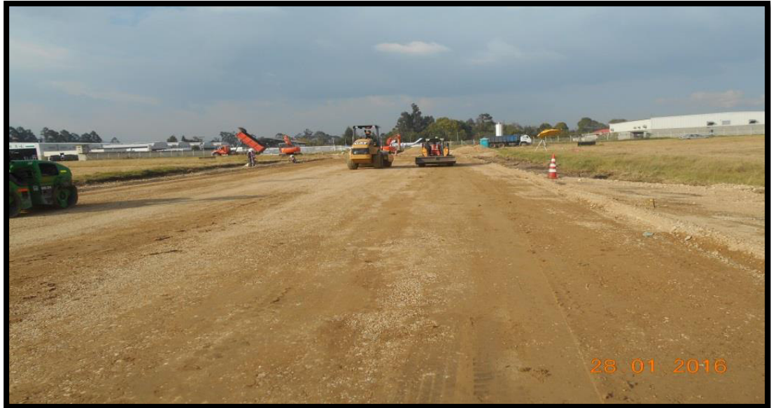
Figura 11. Compactación de material subbase.
