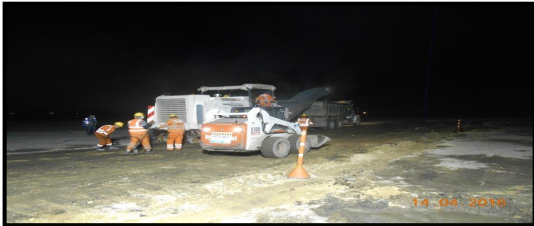
Figura 58. Actividad de fresado en horario nocturno.
