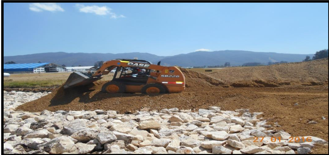
Figura 9. Minicargador extendiendo material subbase.
