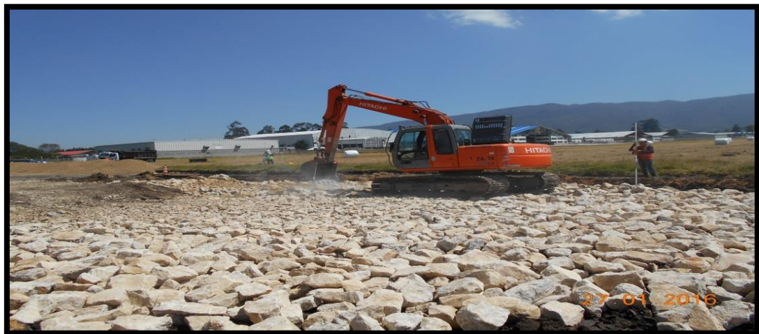
Figura 8. La máquina retroexcavadora instala y compacta el material de rajón.
