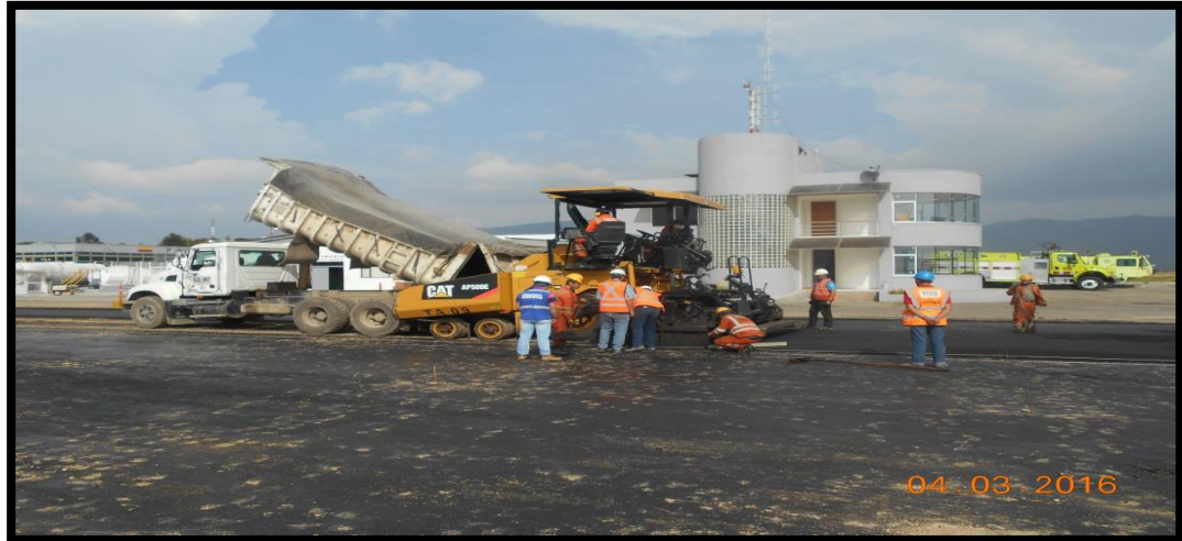
Figura 33. Extendida de material asfáltico en plataforma de bomberos.
