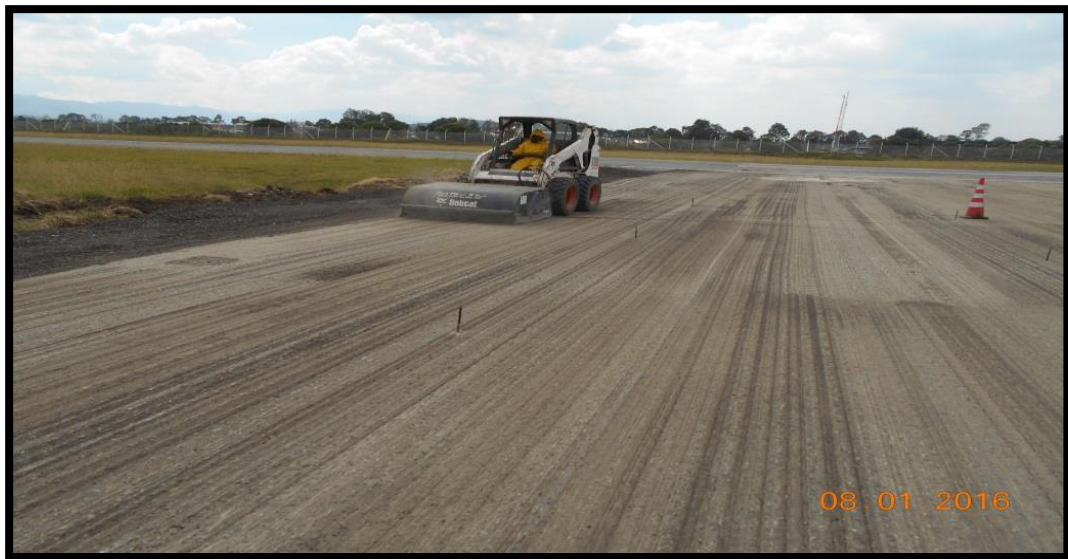
Figura 3. Limpieza de área fresada con máquina minicargador.
