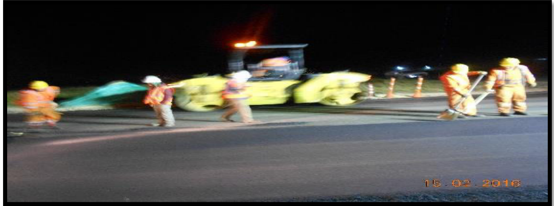
Figura 25. Máquina vibrocompactador tandem compactando la carpeta asfáltica.
