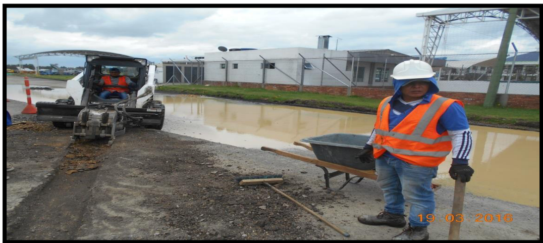
Figura 36. Construcción del canal para drenar agua estancada.
