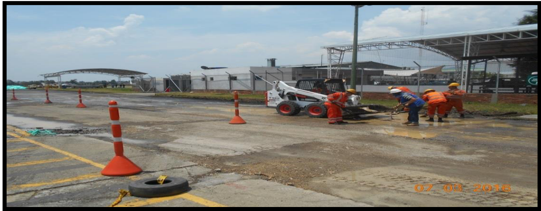
Figura 35. Trabajadores drenando agua estancada.
