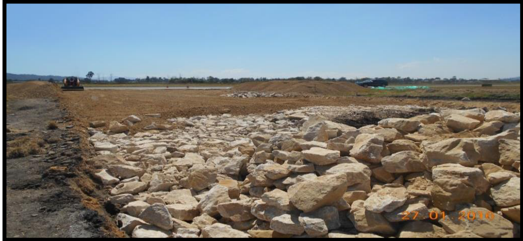
Figura 7. Material de rajón y subbase extendido sobre el área excavada.
