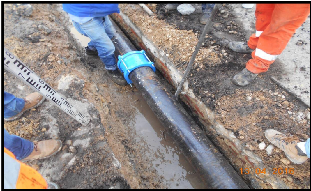
Figura 55. Instalación de tubería metálica con uniones tipo Dresser.
