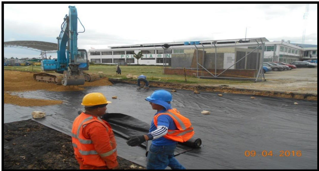
Figura 44. Extendida de material subbase sobre geotextil.
