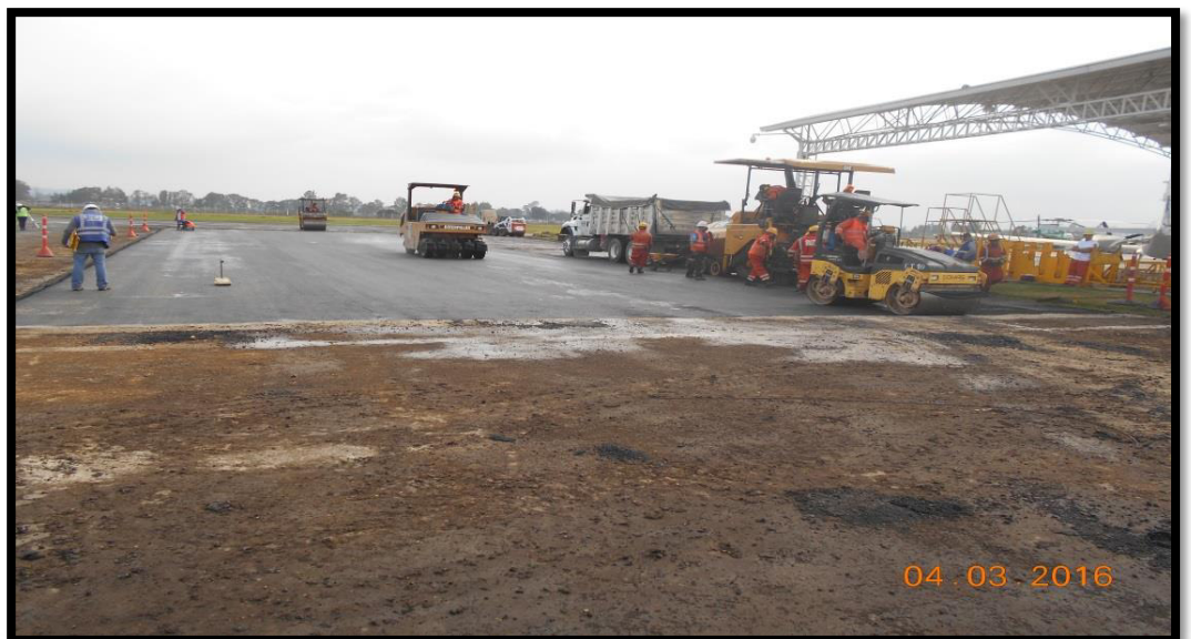
Figura 34. Compactación, extendida de asfalto y pruebas de laboratorio.
