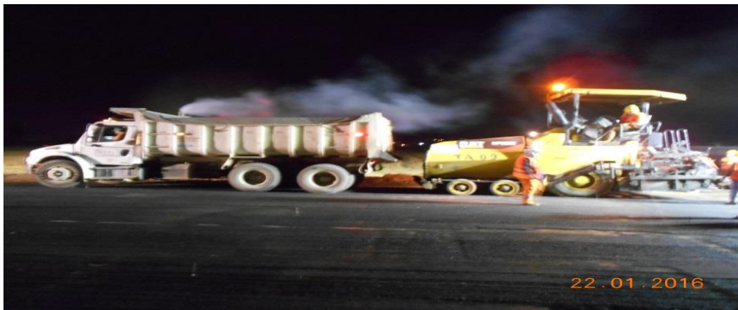
Figura 20. Volqueta con material de asfalto inserta material a la finisher.
