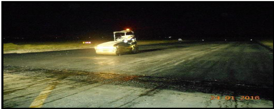
Figura 26. Geomalla instalada sobre la primera carpeta asfáltica y compactación.
