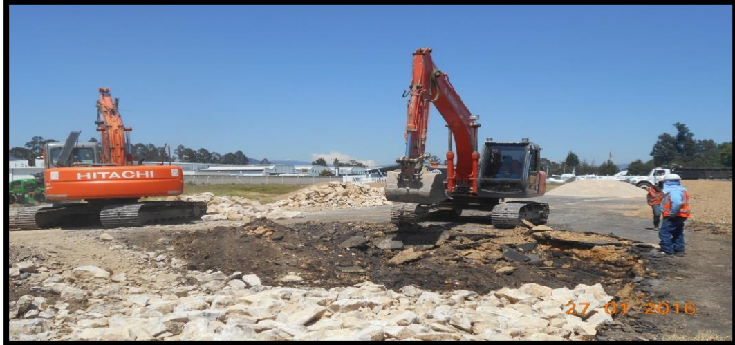
Figura 5. Excavación con máquina retroexcavadora.
