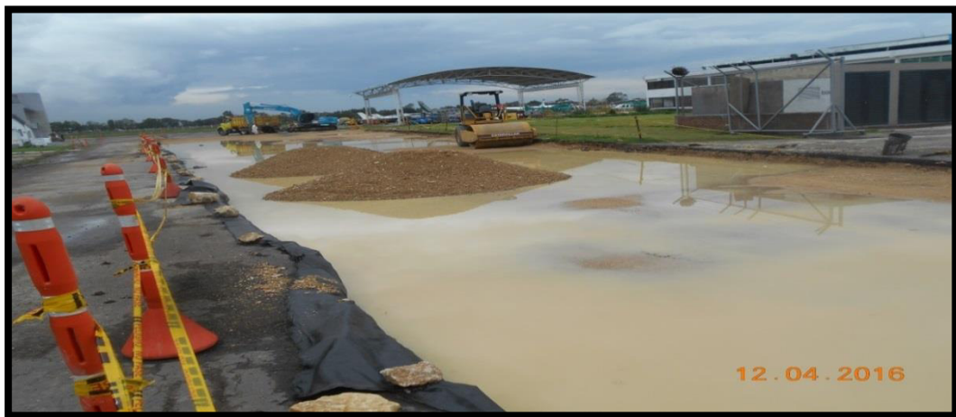
Figura 50. Obra detenida por condiciones climáticas.
