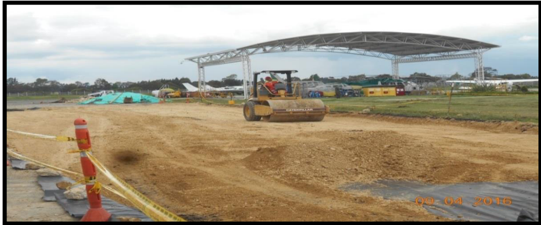
Figura 49. Compactación de subbase con el vibrocompactador.
