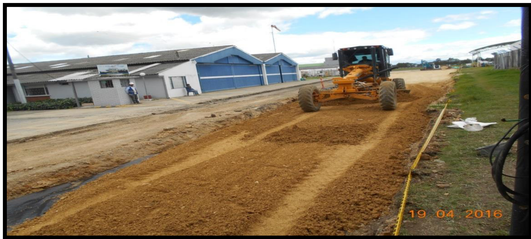
Figura 64. Extendida de material subbase sobre el área donde se ubicaban los fallos.
