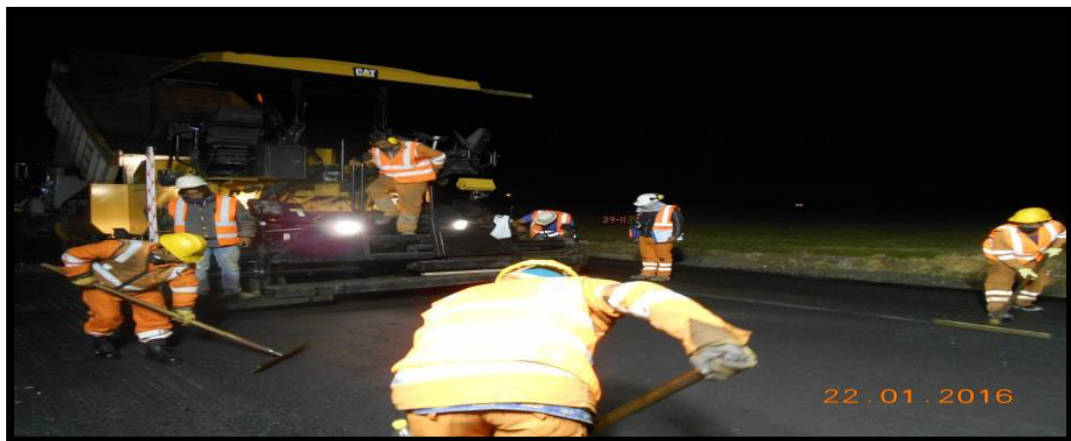
Figura 22. Instalación de la carpeta de nivelación.
