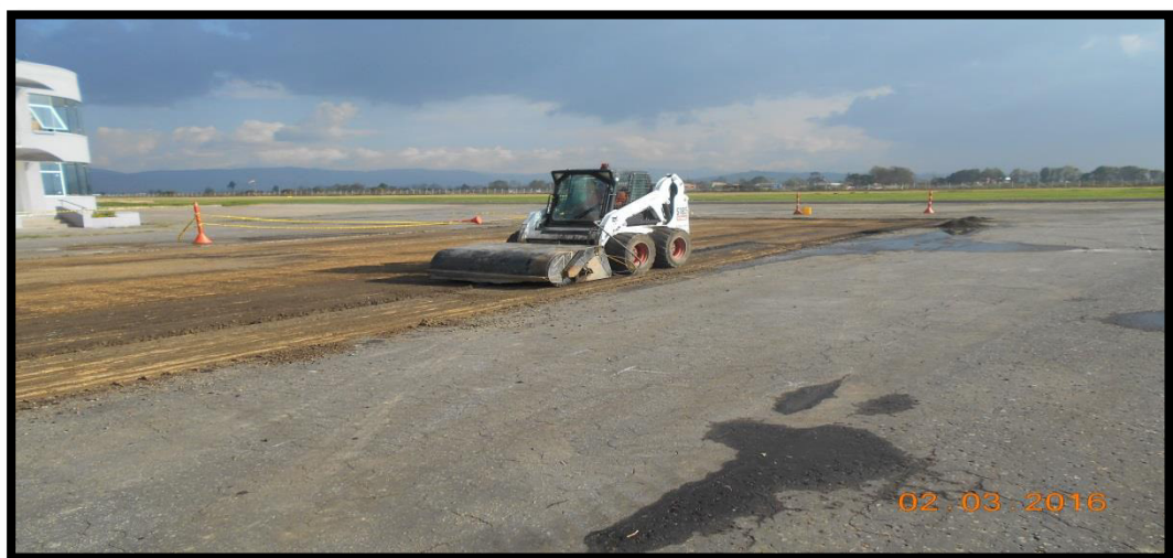
Figura 29. Minicargador limpiando sobre el área donde se fresó con el artefacto barredora.
