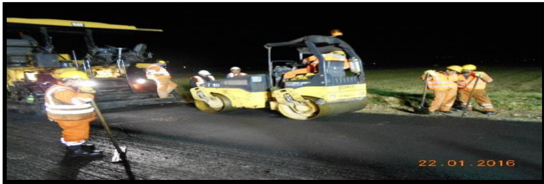
Figura 23. Máquina vibrocompactador benitín compactando la carpeta asfáltica.
