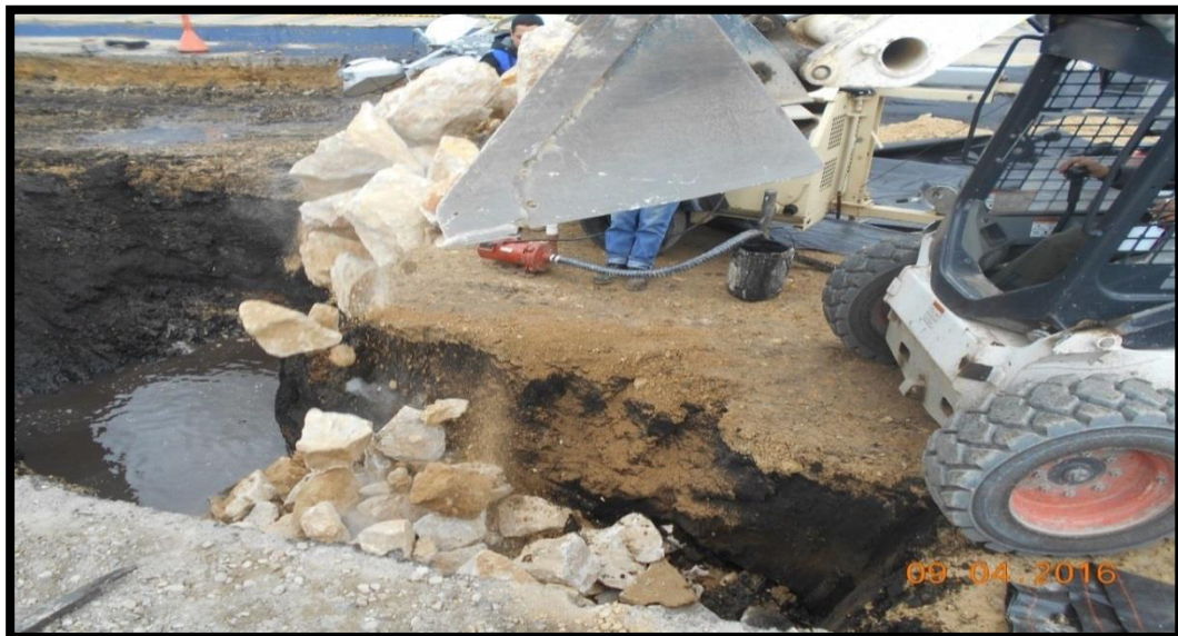
Figura 46. Reforzamiento de zona de nivel freático.
