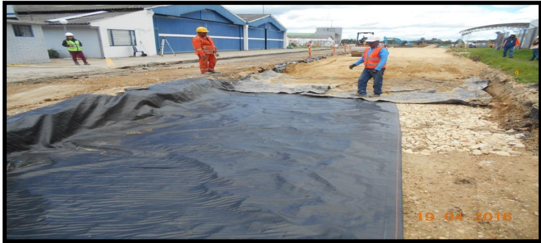
Figura 63. Extendida de nuevo geotextil donde se situaban los fallos.
