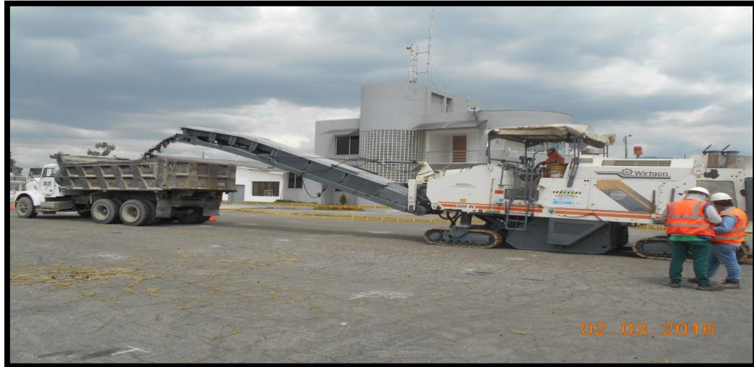
Figura 28. Actividad de fresado en plataforma de bomberos.
