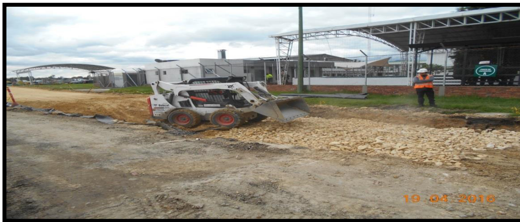
Figura 62. Arreglo en zona de fallo.
