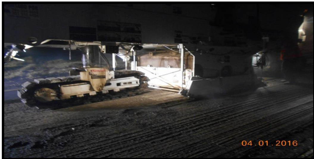
Figura 1. Máquina fresadora y volqueta recolectando material fresado.
