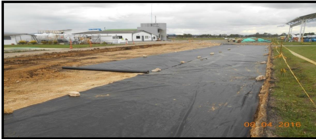
Figura 43. Geotextil extendido sobre el terreno natural.
