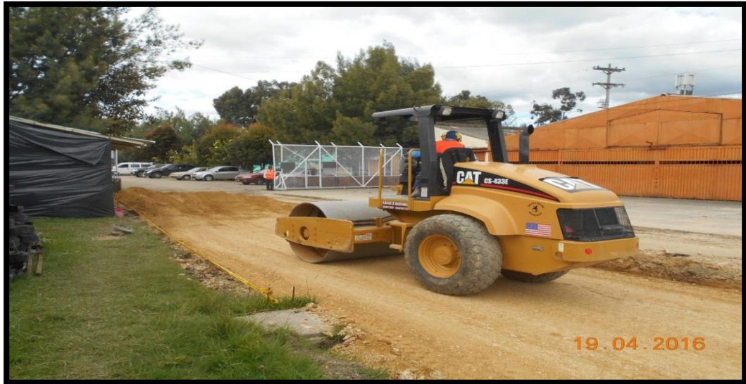
Figura 65. Sellado y compactación en zona de falla con el vibrocompactador.
