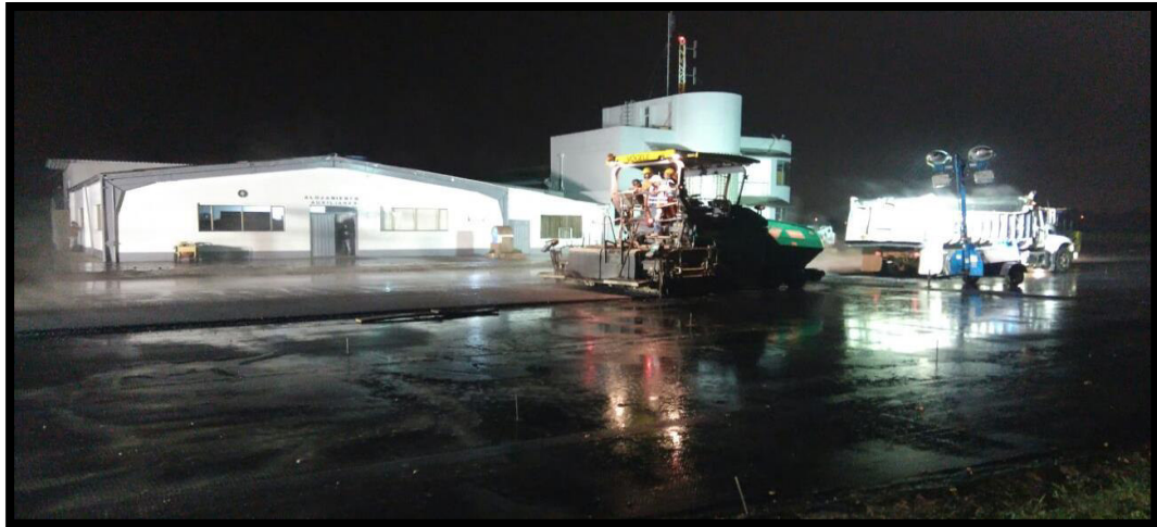
Figura 71. Extendida de material asfalto por la máquina finisher.
