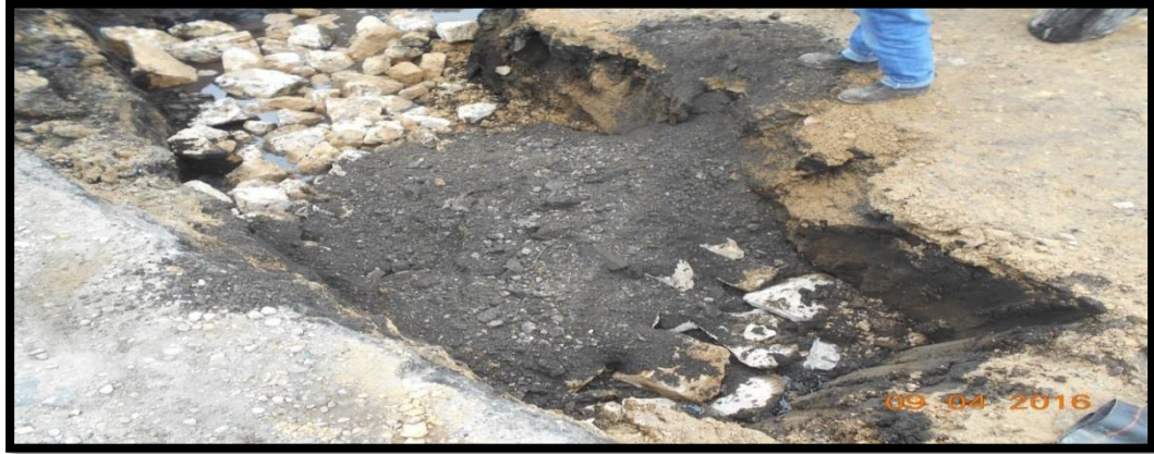
Figura 47. Reforzamiento en zona de nivel freático con material de rajón y fresado.
