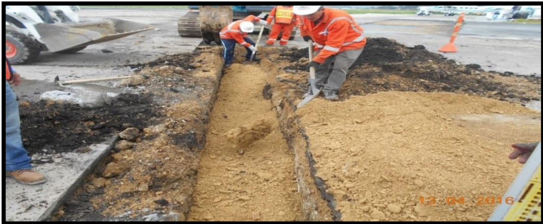
Figura 52. Excavación del canal donde se instalará tubería.
