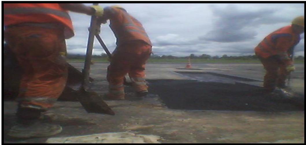
Figura 73. Extendida de aglomerados de forma manual hecha por trabajadores.
