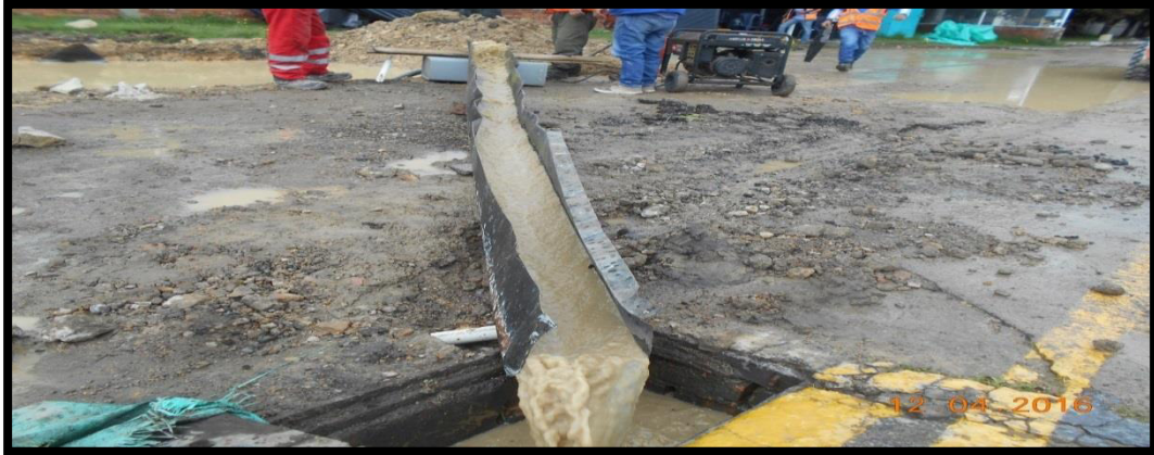
Figura 51. Canal drenando aguas lluvias.
