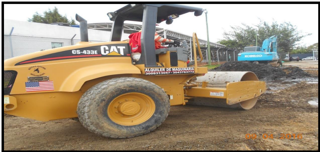
Figura 48. Compactación en zona de nivel freático.
