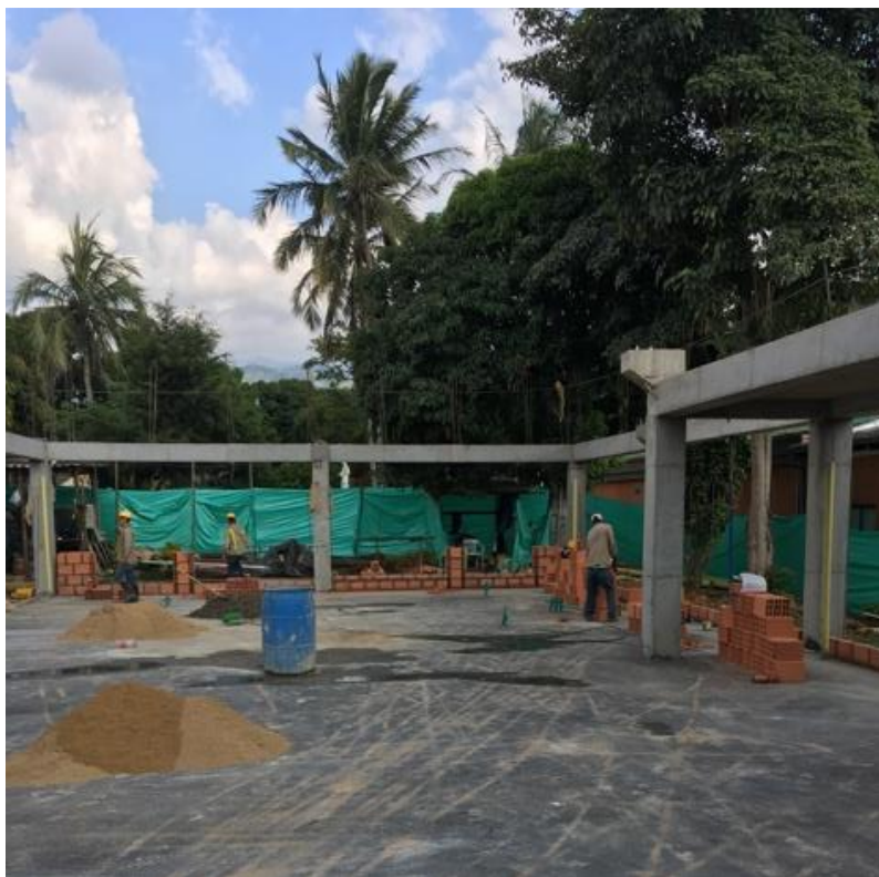
Figura 28. Registro fotográfico visita técnica a obra (UNIÓN TEMPORAL ADMISAN CAMILO 2016)
