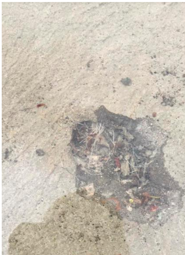
Figura 32. Registro fotográfico revisión de inconformidades en obra (Tanque Almacenamiento AMB).
