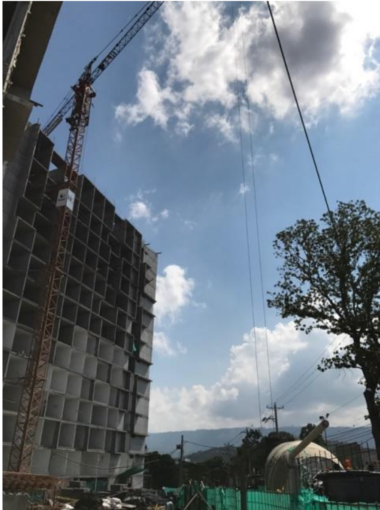
Figura 36. Visita técnica a obra, Fundida con Góndola.
