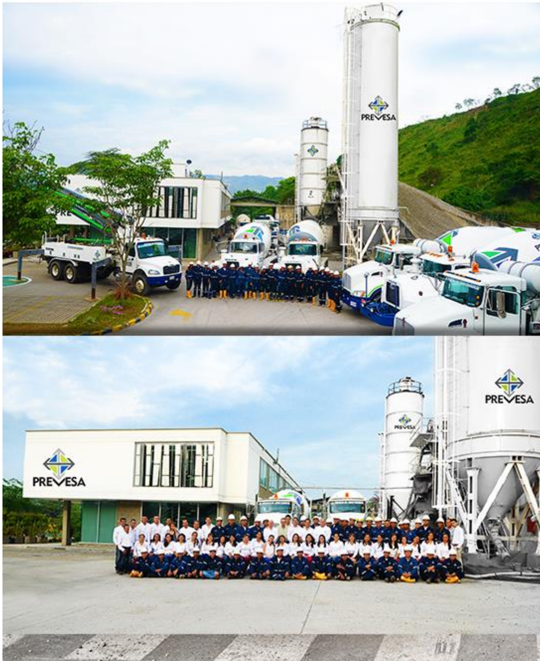
Figura 1. Planta de Concretos PREVEESA S.A.S Fuente: PREVEESA S.A.S
