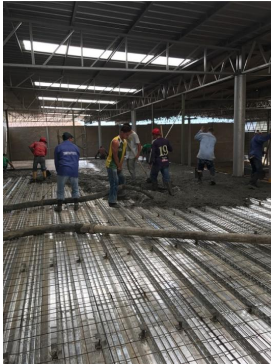
Figura 35. Visita técnica a obra, fundida en placa Metaldeck. Fuente: Autor.
