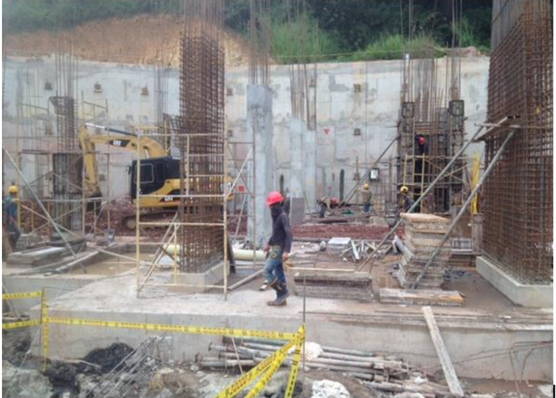
Imagen 7. Columnas y Foso ascensor fundidos
