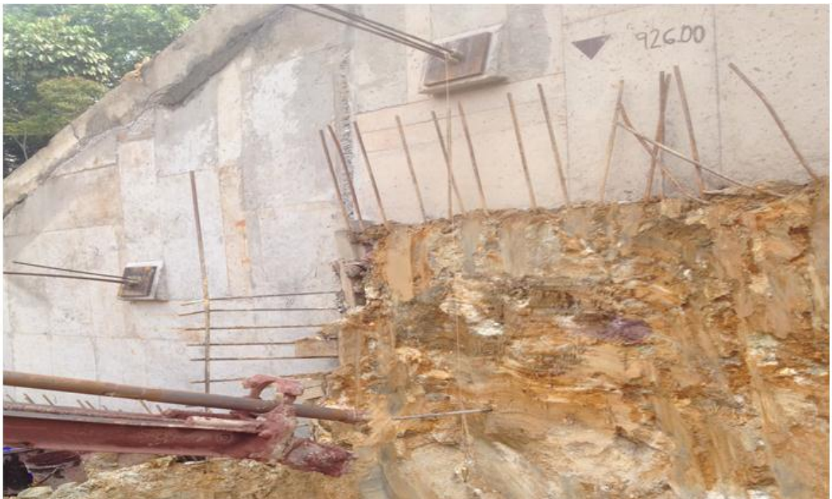
Imagen 2. Verificación de la ubicación del nuevo anclaje
