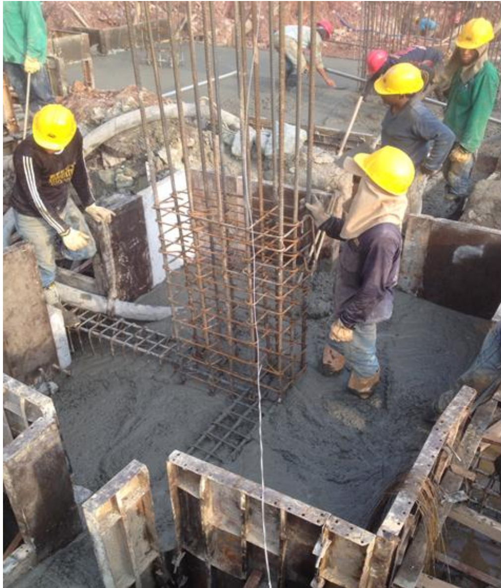
Imagen 5. Fundida de zapata, placa y vigas de cimentación
