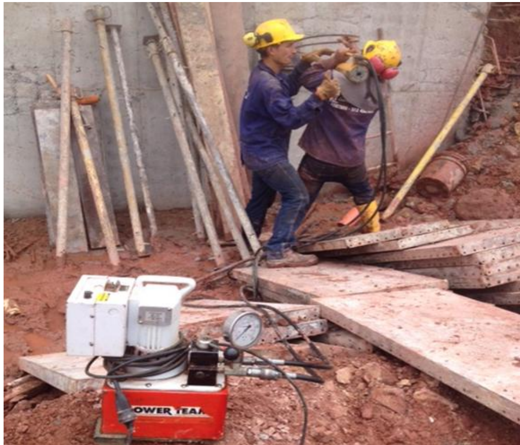
Imagen 4. Tensionamiento de anclajes
