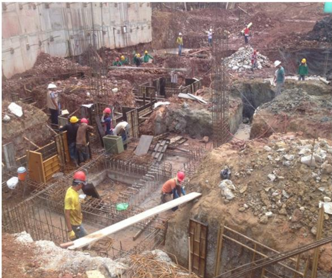
Imagen 9. Armado de zapatas, vigas y columnas de cimentación
