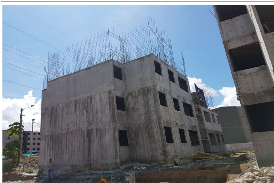
Figura 5. Fotografía de una torre del proyecto terrazas del puerto, sistema de encofrado y alma en malla electro-soldada
