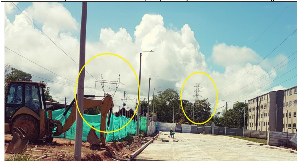
Figura 6. Fotografía de cables de alta tensión sobre el proyecto de vivienda Terrazas del Puerto.
