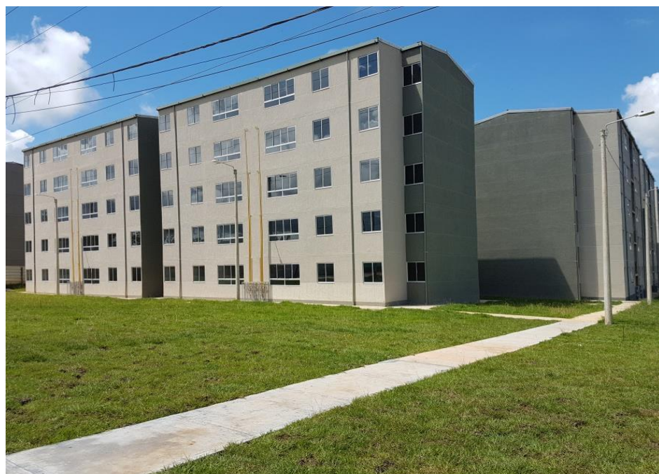
Figura 7. Fotografía de torres terminadas del proyecto de vivienda Terrazas del Puerto.
