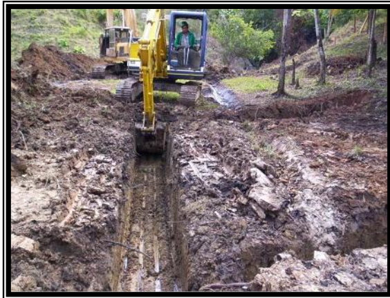
Figura 9. Excavación de los filtros con retroexcavadoras en el manadero Oponcito.
