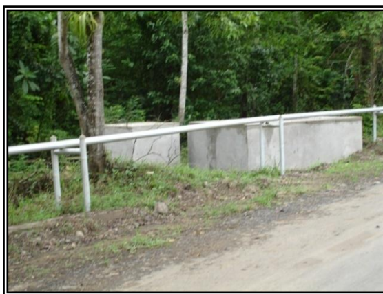
Figura 41. Situación después de culminadas las obras de construcción en Oponcito 1.2
