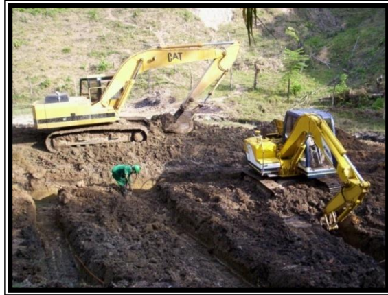
Figura10. Excavación de los filtros con retroexcavadoras en el Campo 13
