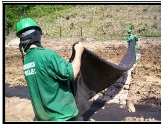
Figura13. Colocación del gestextil para evitar el taponamiento del filtro.
