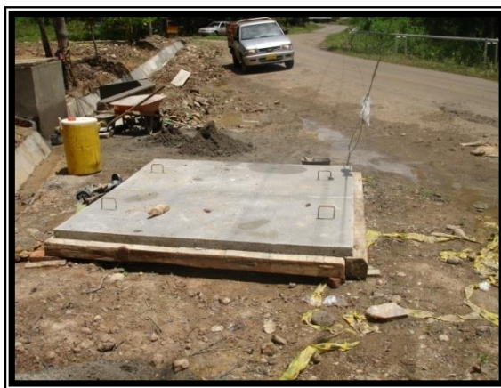
Figura 23. Construcción de las tapas de las cajas en Oponcito 1.2.
