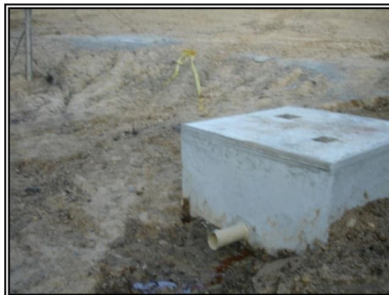
Figura 37. Ambiente del Campo 13 después de culminar las obras de recuperación y construcción.
