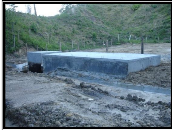
Figura16. Construcción de caja recolectora de crudo API en el Oponcito 1.1.
