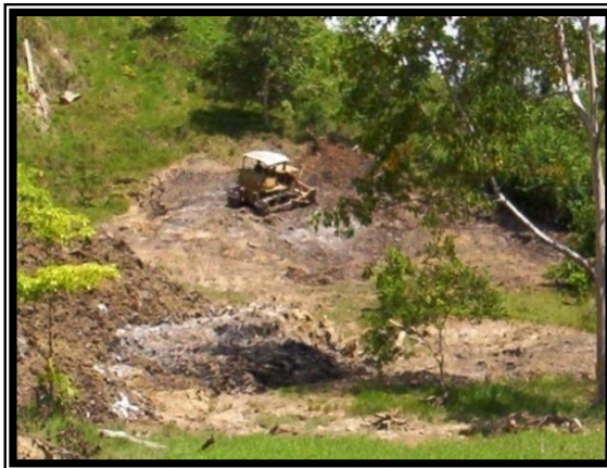
Figura 5. Movimiento de material contaminado con buldózer en el manadero Oponcito.
