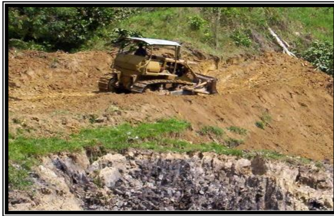
Figura 4. Movimiento y adecuación del terreno con buldózer en el manadero Oponcito
