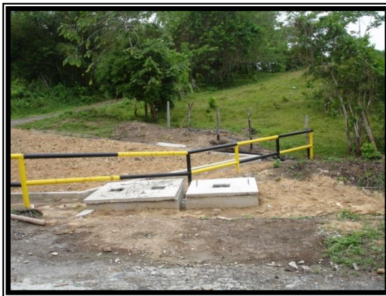
Figura 19. Construcción de caja recolectora de crudo API en Severiche.
