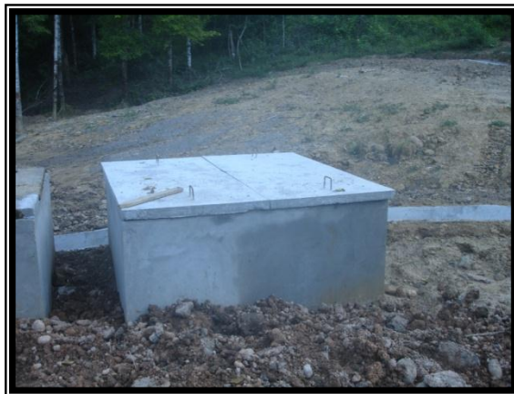
Figura 24. Terminación y colocación de las tapas de las cajas 1.1.
