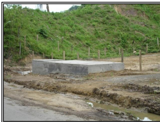
Figura 40. Situación después de culminadas las obras de construcción en Oponcito 1.1
