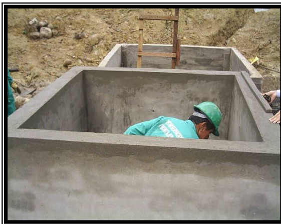
Figura17. Construcción de caja recolectora de crudo API en el Oponcito 1.2.
