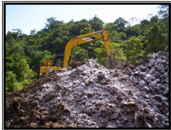
Figura 7. Volteo del material contaminado con cal dolomita, triple 15 y urea, con retroexcavadora en el campo 13.
