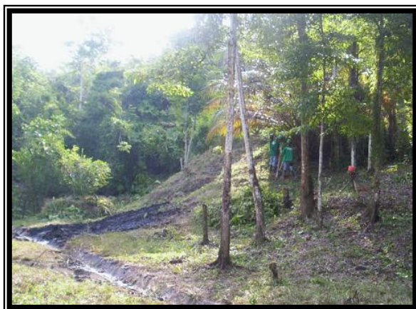
Figura 38. Situación antes de iniciar las obras de recuperación y construcción en Oponcito.
