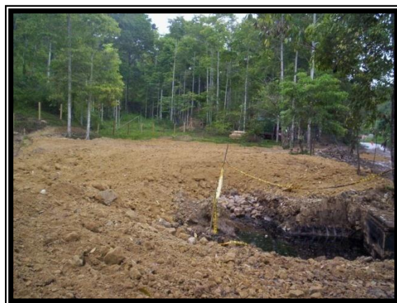
Figura 39. Situación antes de iniciar las obras de recuperación y construcción en Oponcito.
