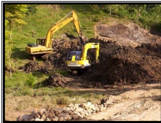
Figura 3. Excavación y adecuación del terreno con retroexcavadora en el Campo 13
