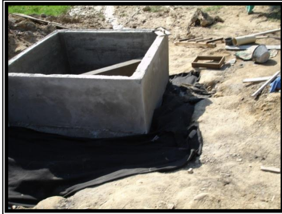
Figura18. Construcción de caja recolectora de crudo API En el Campo 13.
