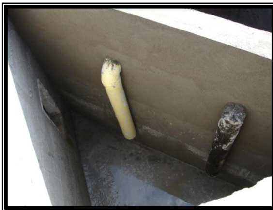
Figura 22. Terminación de las cortinas o separadores internos en Severiche.
