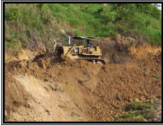
Figura 6. Movimiento de material contaminado con buldózer en el Campo 13.
