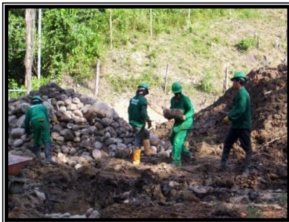
Figura11. Relleno con piedra bolo en la zanja del filtro en el manadero Oponcito.
