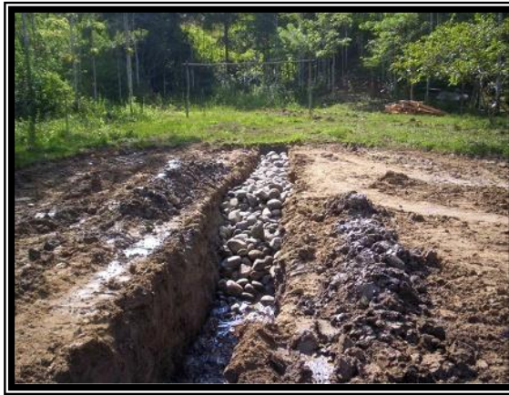
Figura 12. Relleno con piedra bolo entro de la zanja del filtro en el campo 13.
