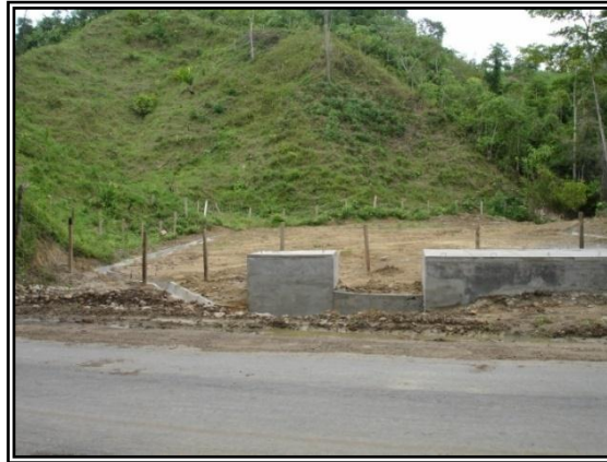
Figura 42. Situación después de culminadas las obras de construcción en Oponcito 1.2
