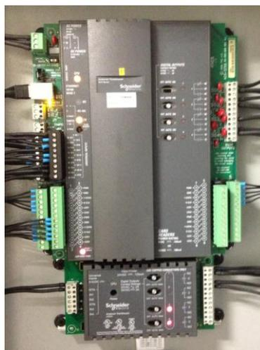
*Figura 9. Controladora de accesos ACX 5740 de Schneider Electric.[9]*
