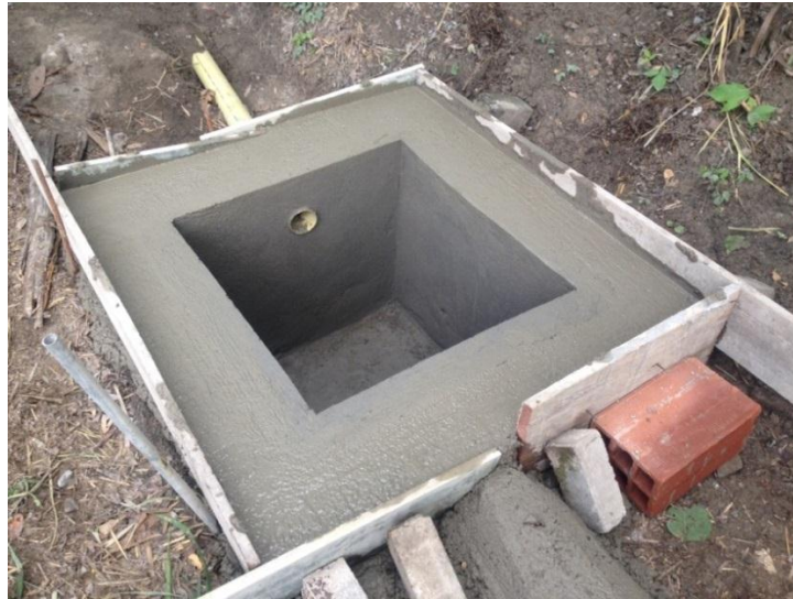
Fotografía N°16. Construcción caja desarenador.
