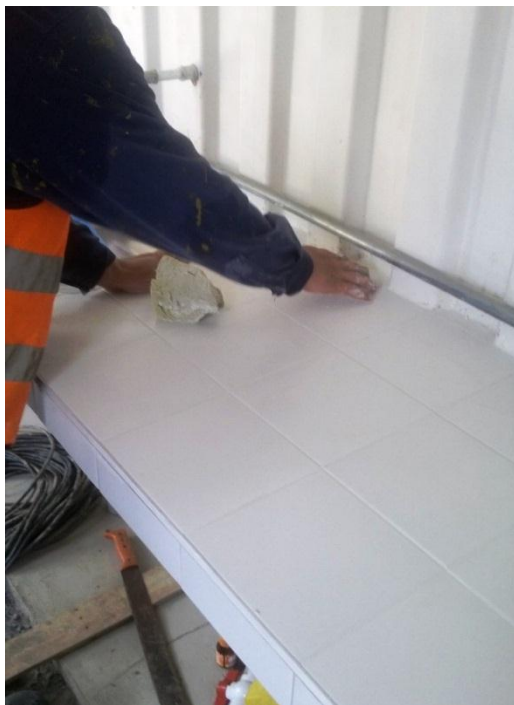
Fotografía N°14. Sellado de juntas cerámicas con boquilla.
