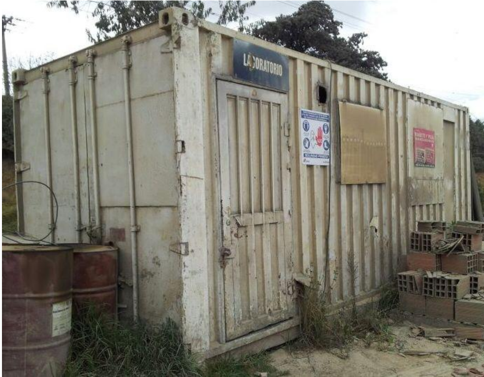
Fotografía N° 1. Vista exterior contenedor.
