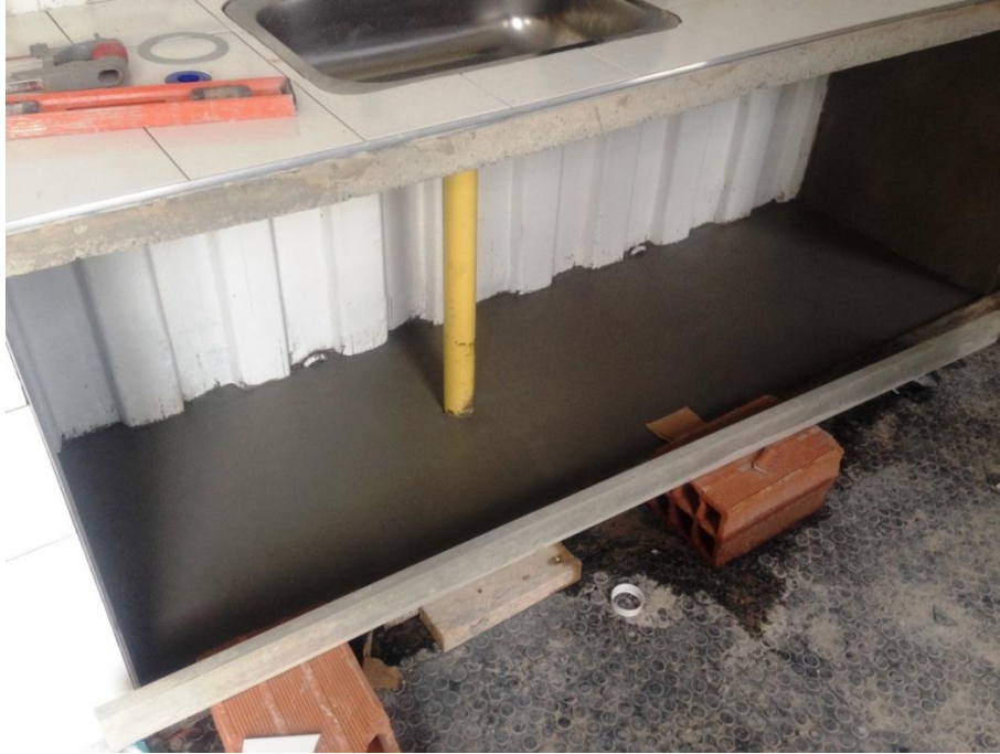
Fotografía N°13. Afinado de pisos e instalación de bajantes de agua.
