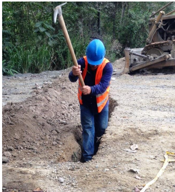
Fotografía N°17. Excavación e instalación de la tubería de agua potable.
