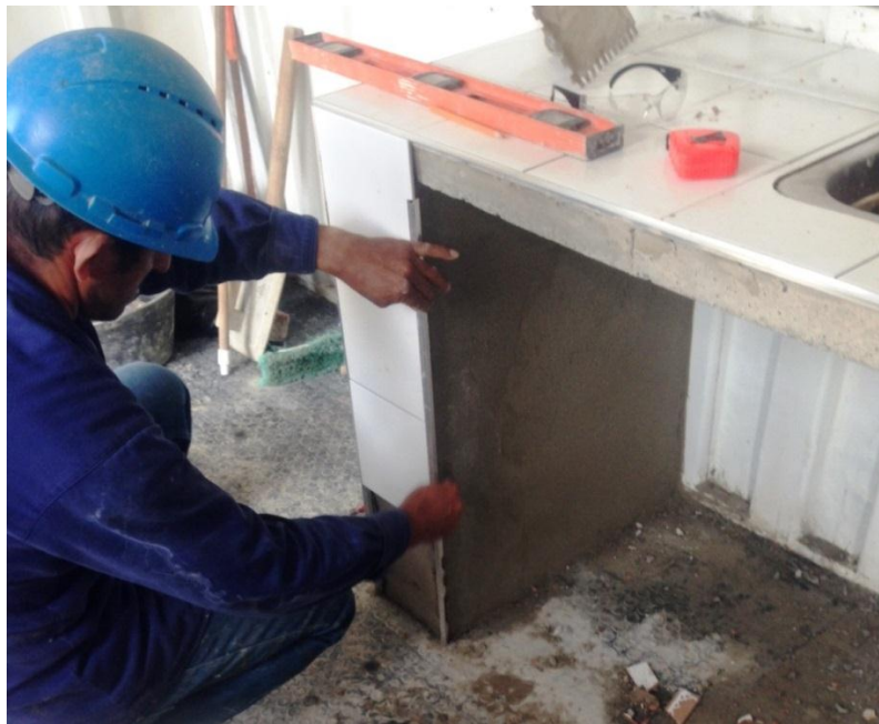
Fotografía N°12. Enchapados muros divisorios y mesones.
