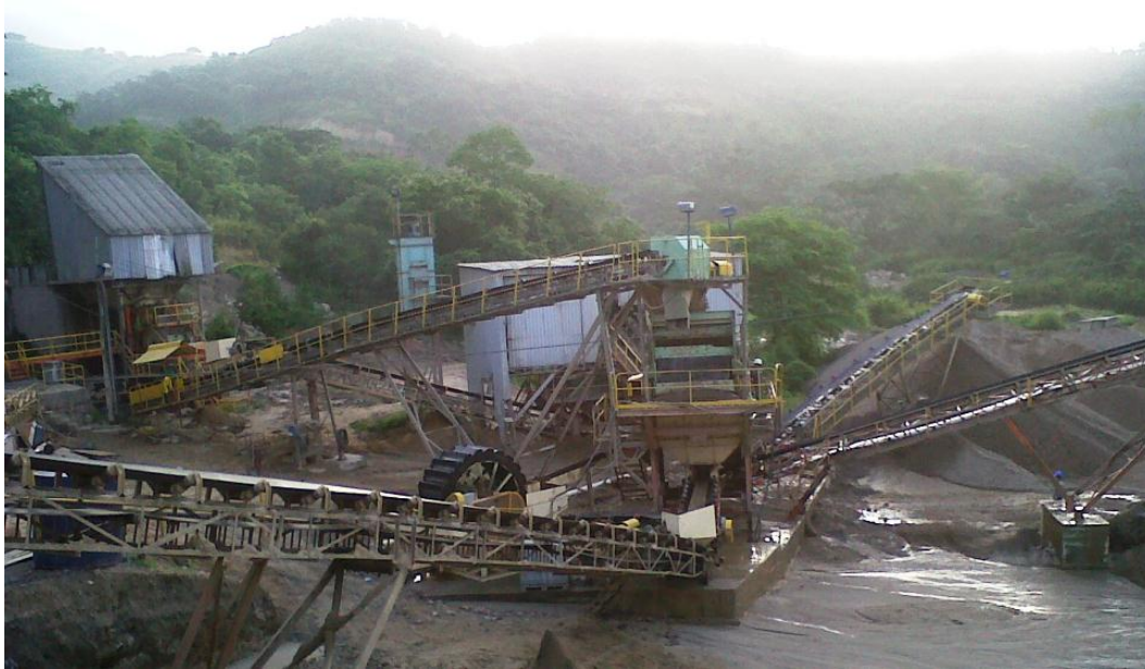
Fotografía N°3. Planta de agregados Suratá.
