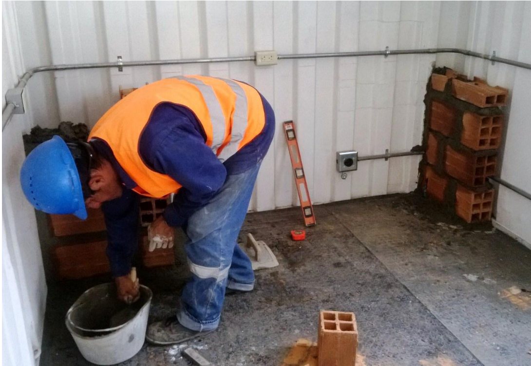
Fotografía N°8. Mampostería muros divisorios para los mesones del laboratorio.
