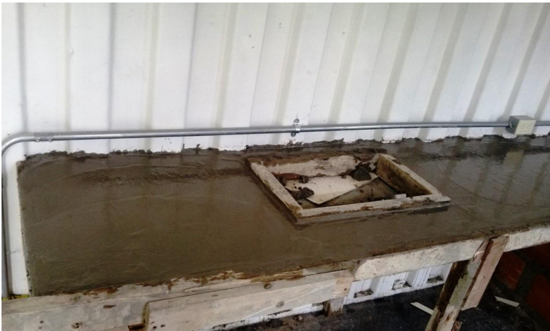
Fotografía N°10. Fundida de los mesones en concreto convencional (3000 psi)
