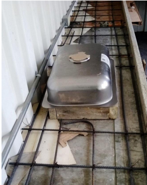
Fotografía N°9. Armado y refuerzo de los mesones del laboratorio.
