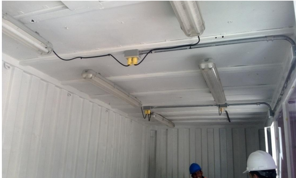
Fotografía N°6. Acondicionamiento eléctrico del laboratorio.
