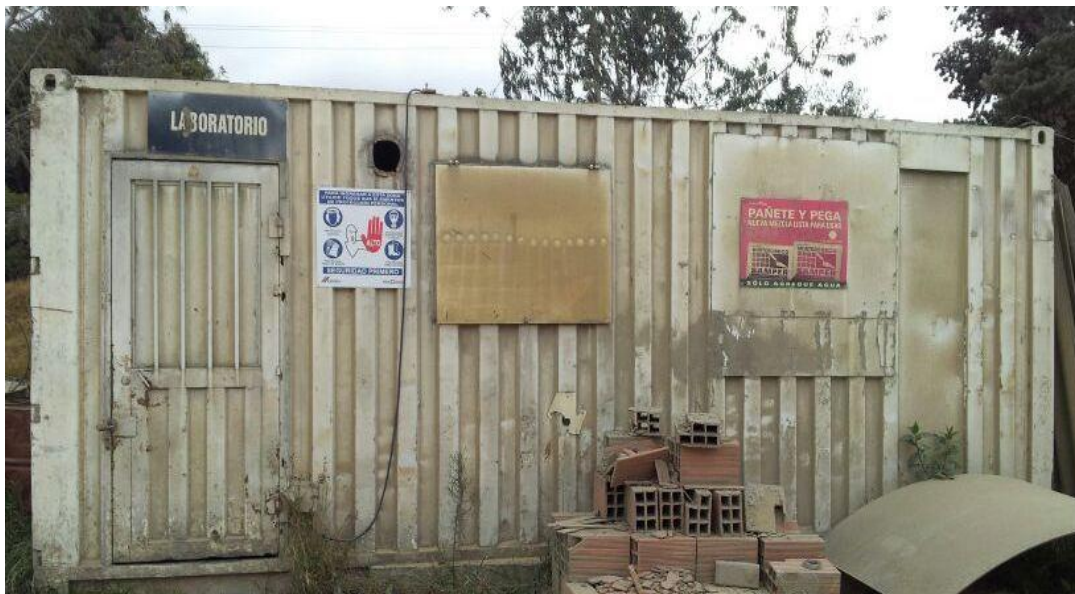
Fotografía N° 2. Vista exterior contenedor.
