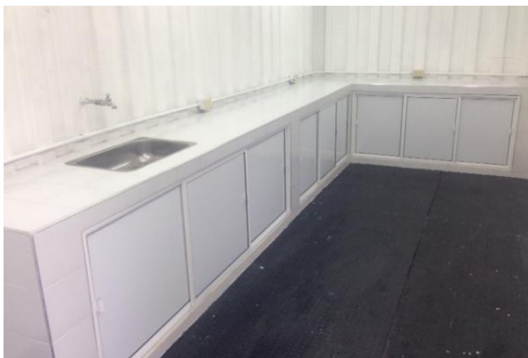
Fotografía N°18. Mesones laboratorio satélite Bucaramanga.
