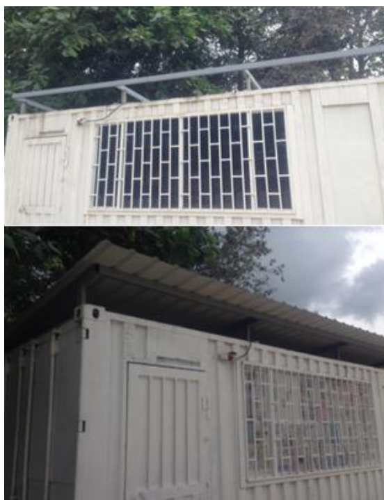
Fotografía N°19. Instalación de cubierta en tejas de lámina.
