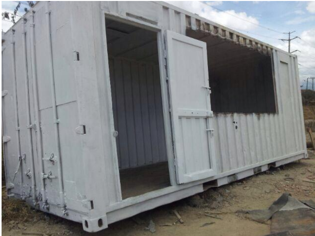
Fotografía N°5. Reparación de latonería, pintura y acabados.
