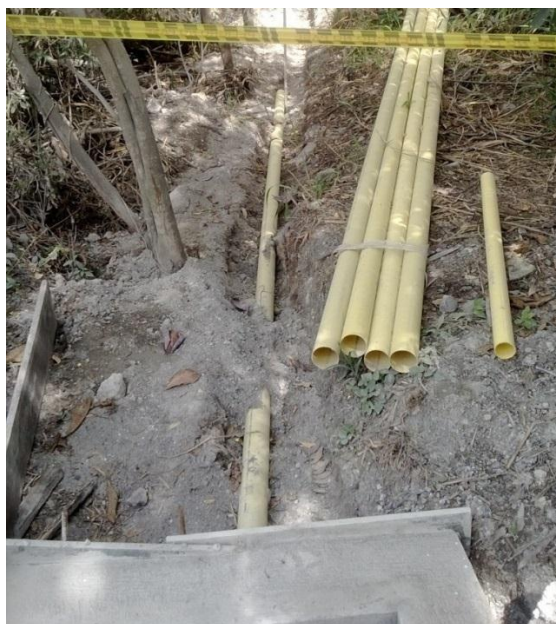
Fotografía N°15. Instalación de la red de alcantarillado para el laboratorio.
