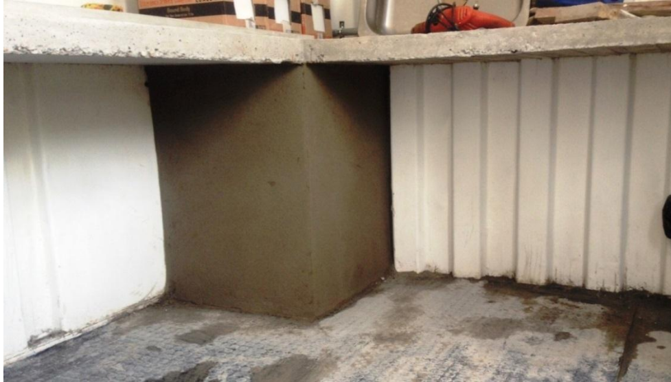
Fotografía N°11. Friso de los muros divisorios.
