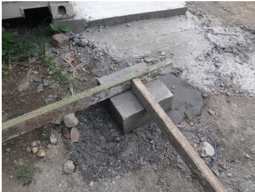
Fotografía N°7. Construcción de bases (0,30x0,30) en concreto, para fijación y nivelación del contenedor.
