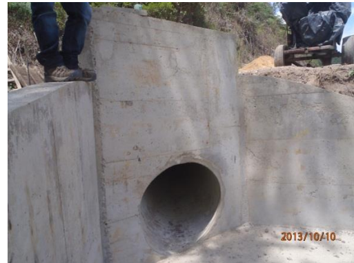
Figura 42.: Instalación de aceros aletas y dentellón. Figura 43.: Desencofrado y entrega final del cabezote
