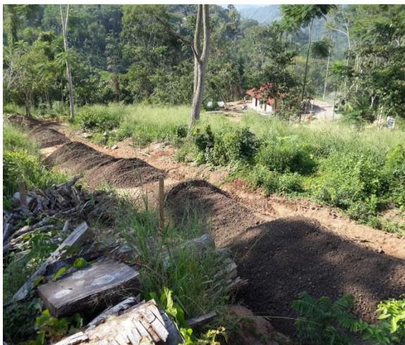
Figura 21.: Viajes de material colocados en sitio para extendido de afirmado
