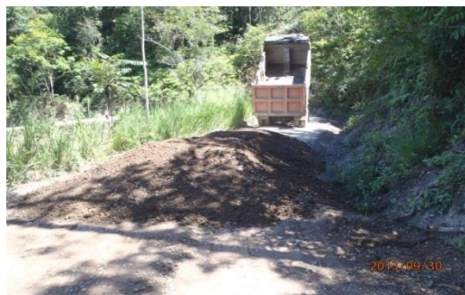
Figura 14.: Liberación del material de la volqueta
