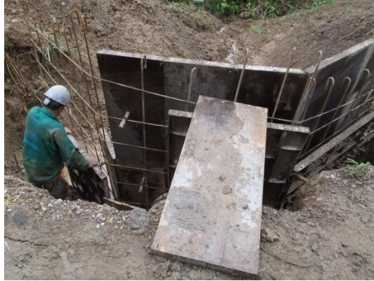
Figura 48.: Acero y encofrado del cabezote de salida.
