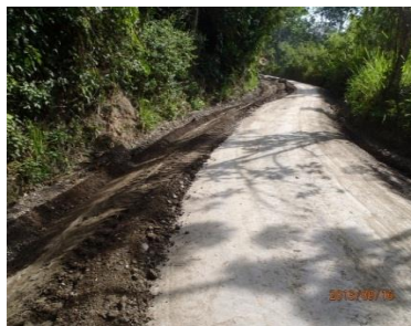
Figura 10.: Conformación de cunetas
