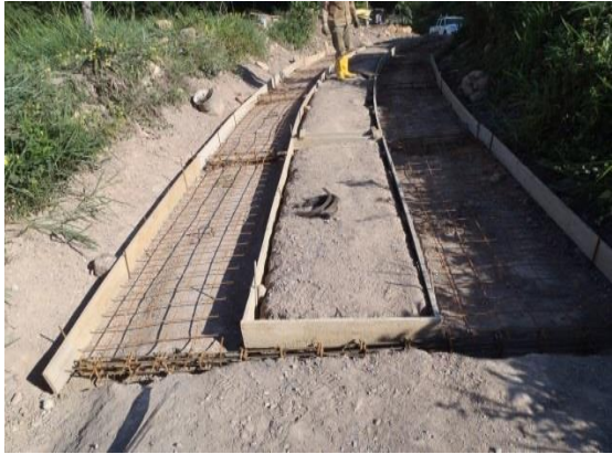
Figura 32.: Instalación de aceros y encofrado de huellas
