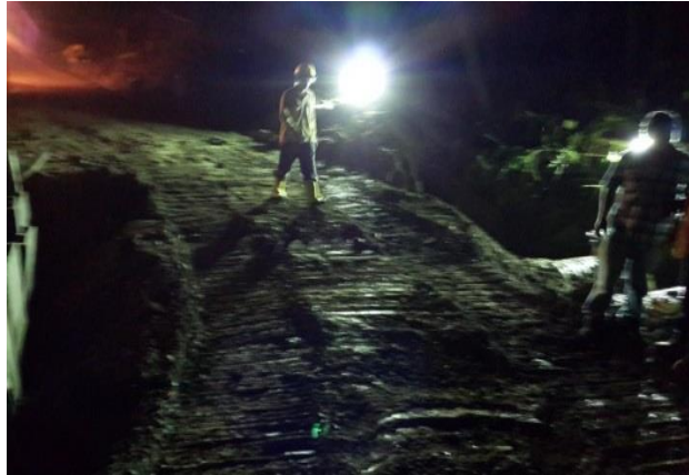
Figura 40.: Relleno y compactación de la alcantarilla doble
