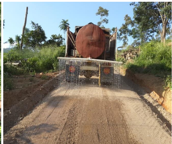
Figura 22.: Humectación de material conformado
