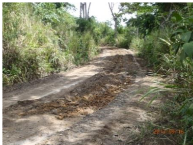
Figura 9.: Terreno escarificado
