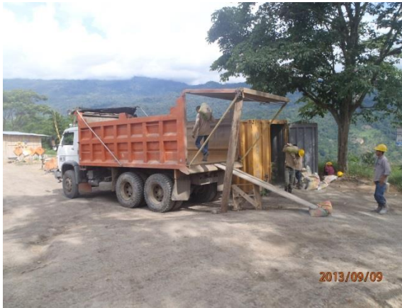
Figura 24.: Cargue de gran cantidad de cemento y acero
