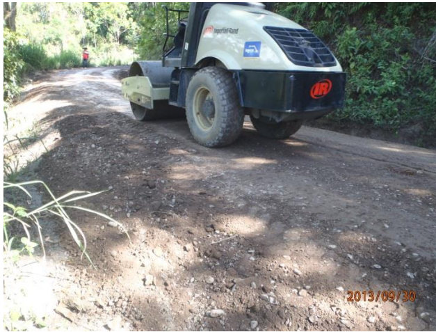
Figura 15.: Compactación del talud establecido
