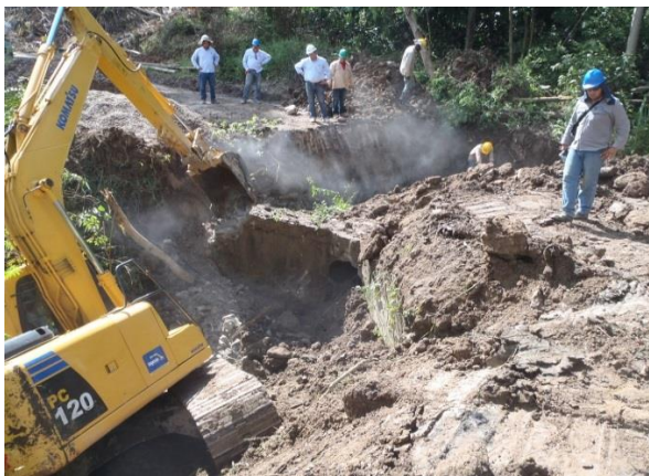
Figura 38.: Pontón en concreto ciclópeo demolido
