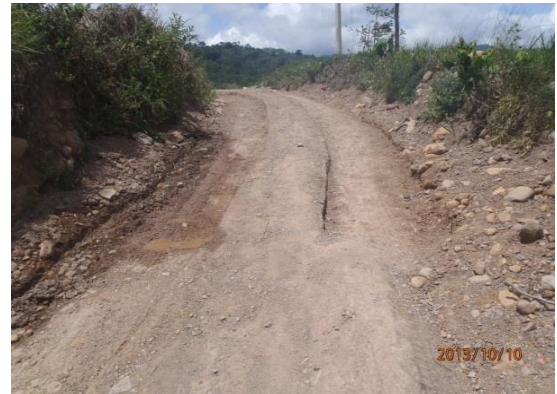
Figura 31.: Inicio de excavación placa huellas santa cruz C
