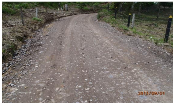
Figura 12.: Afirmado totumos tramo A
