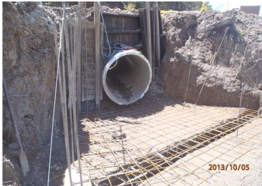
Figura 42.: Instalación de aceros aletas y dentellón. Figura 43.: Desencofrado y entrega final del cabezote
