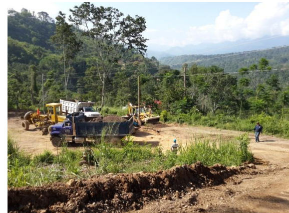
Figura 27.: Transporte de material por medio de las volquetas y posterior extendido
