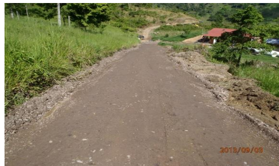
Figura 13.: Afirmado totumos tramo B
