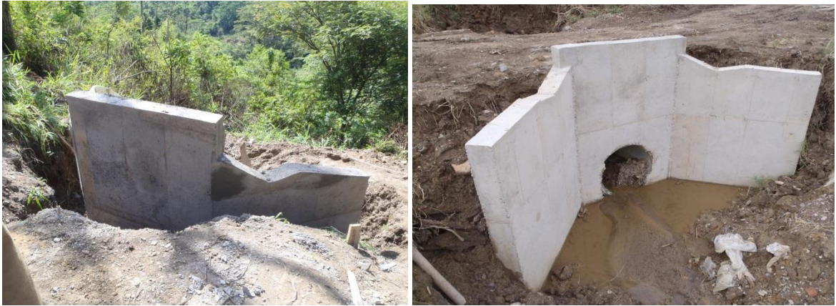
Figura 52.: Resultado final del cabezote de salida
