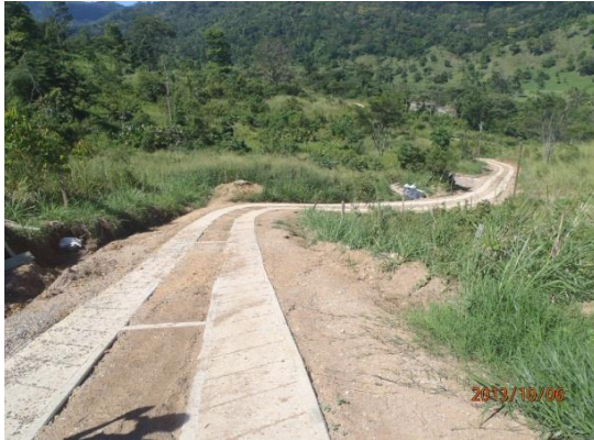
Figura 30.: Finalización de placa huellas totumos tramo B
