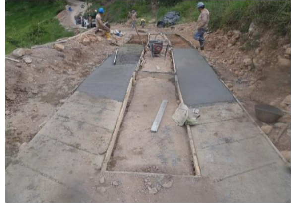
Figura 33.: Fundición de placa huellas y vibrado
