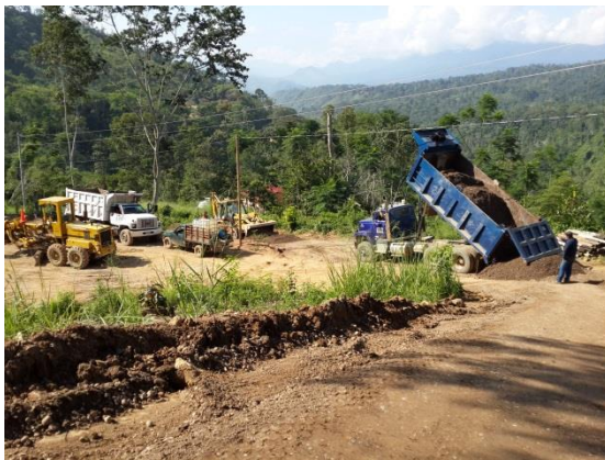
Figura 27.: Transporte de material por medio de las volquetas y posterior extendido
