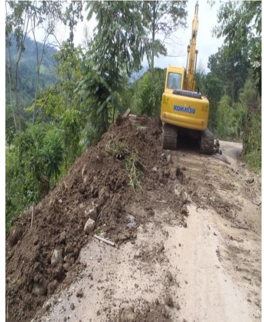
Figura 54.: Conformación de talud con el material retirado.
