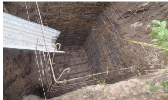
Figura 47.: Acero de la poceta antes de fundir el piso.
