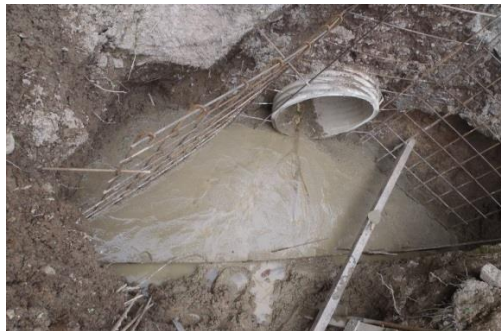
Figura 46.: Fundición del piso de aleta de salida.
