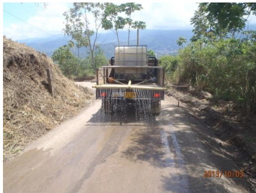
Figura 16.: Humectación de la rasante de la vía
