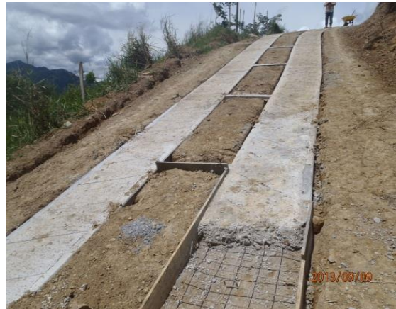
Figura 29.: Fundición de huellas en totumos tramo B
