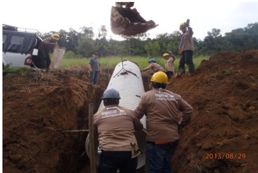
Figura 35.: Instalación de tubo Novafort
