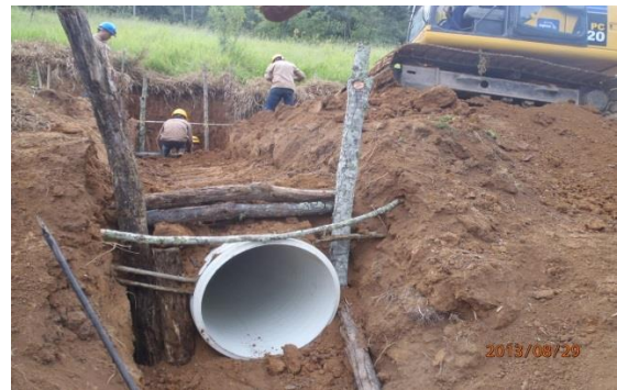
Figura 36.: Realización de relleno en material común
