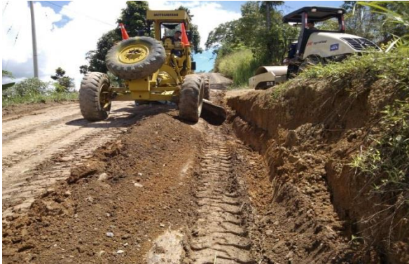
Figura 7.: Conformación de cunetas
