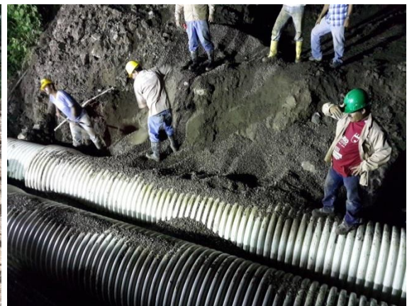
Figura 39.: Instalación de atraque de triturado para la tubería
