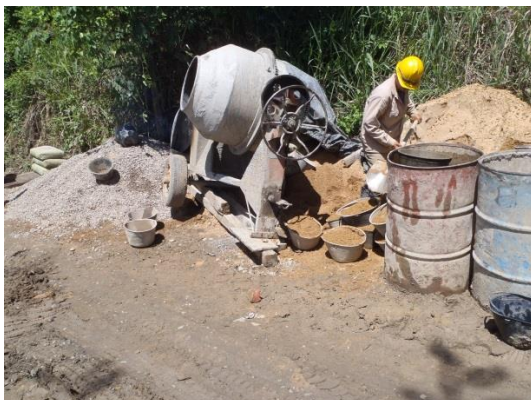
Figura 50.: Relación de material por baldes.
