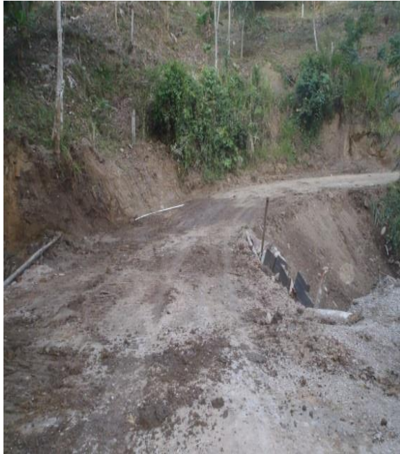
Figura 53.: Alcantarilla doble después de retirar el material.
