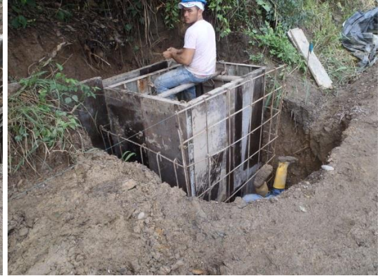
Figura 49.: Acero y encofrado de la poceta
