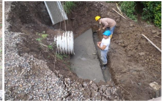
Figura 45.: Solado de limpieza del cabezote.
