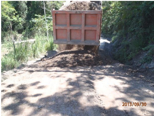
Figura 26.: Descargue de material para afirmado
