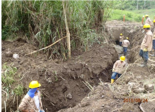
Figura 41.: Realización de descole de alcantarilla existente
