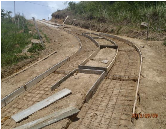
Figura 28.: Aceros y encofrado de huellas en Totumos tramo B
