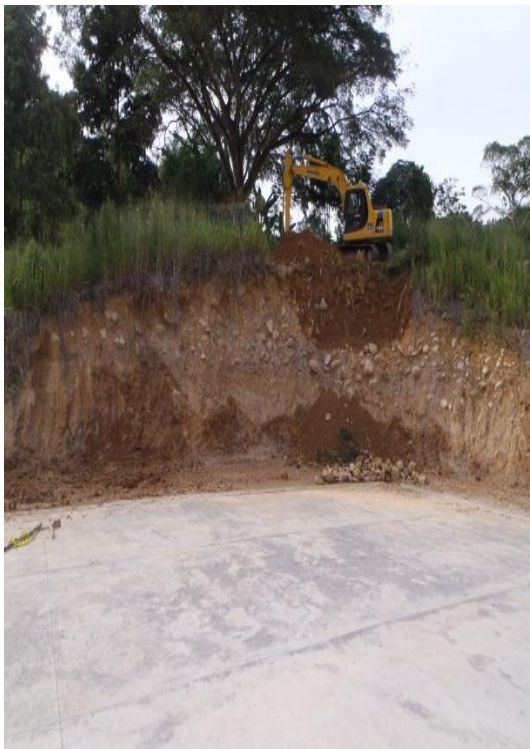
Figura 55.: Perfilado de talud en la escuela
