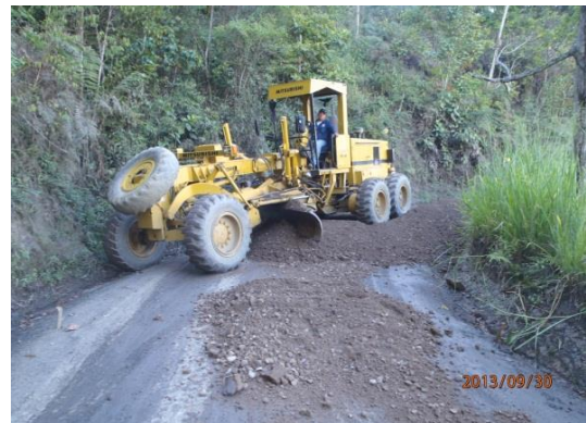
Figura 17.: Extendido del material
