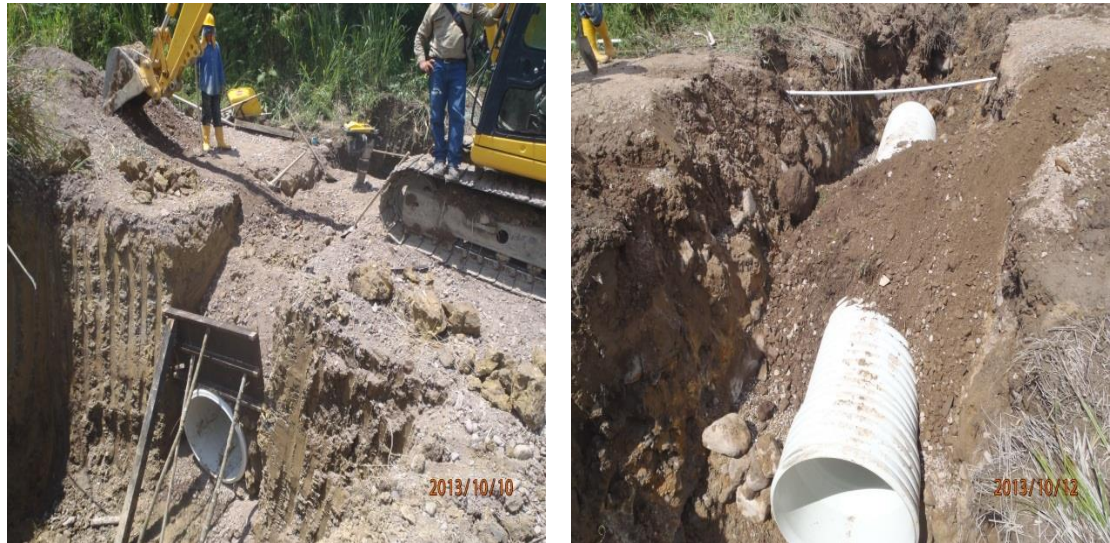
Figura 37.: Realización de rellenos con material mezclado usado en el afirmado
