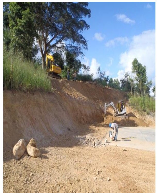
Figura 56.: Resultado final del talud perfilado en la escuela
