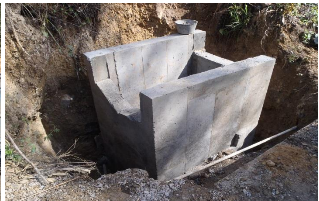
Figura 51.: Resultado final de la poceta de entrada
