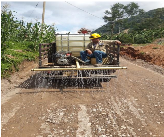
Figura 19.: Humectación del material extendido
