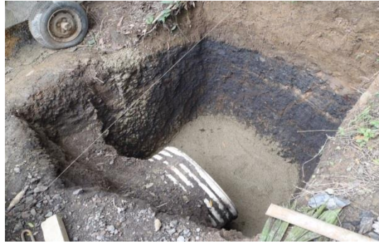
Figura 44.: Solado de limpieza de la poceta.
