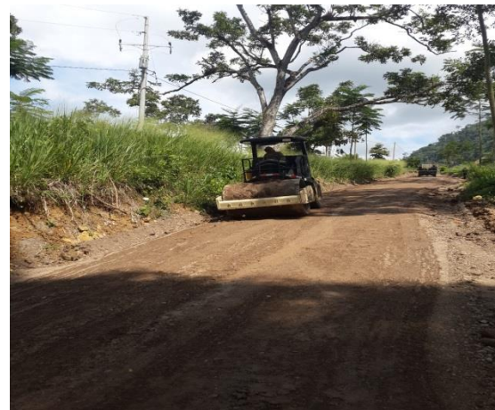
Figura 20.: Compactación del material humectado
