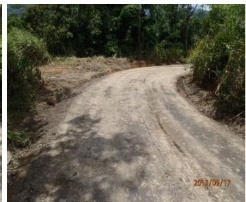
Figura 11.: Conformación final
